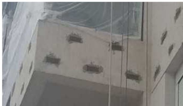
Figura 13 - Exemplo de espaçamento do grampeamento
