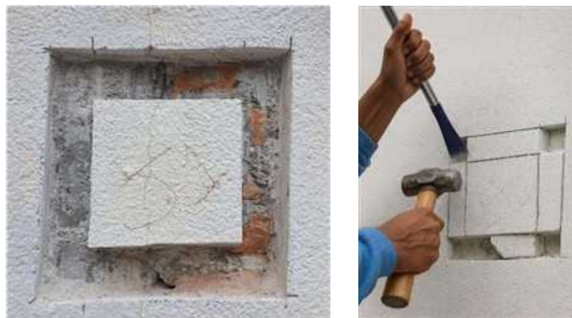
Figura 8 - Janela de inspeção
