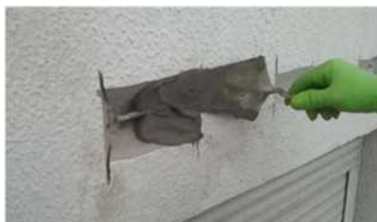
Figura 14 - Execução do grampeamento
