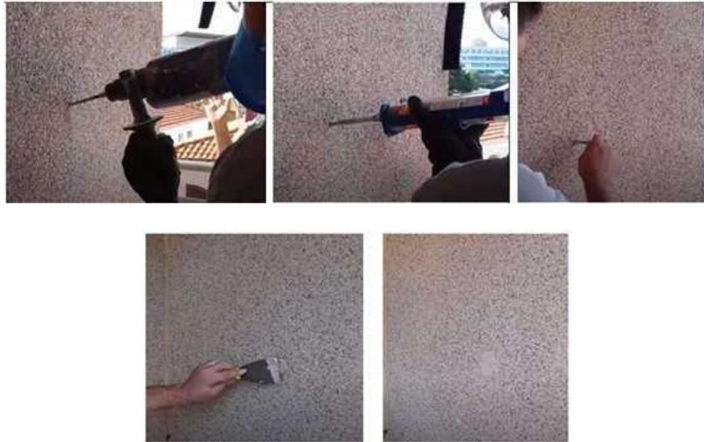
Figura 24 - Execução do pinamento
