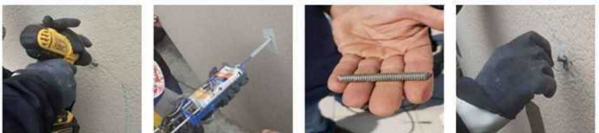
Figura 33 - Execução do pinamento
