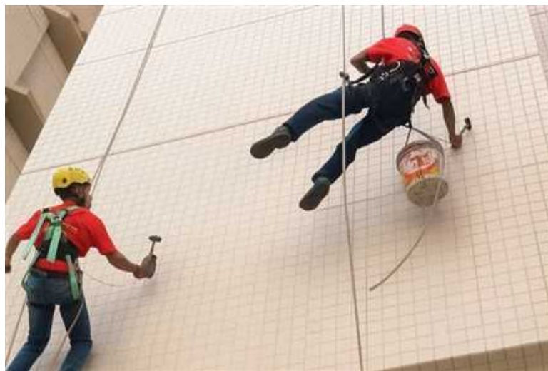
Figura 9 - Ensaio de percussão
