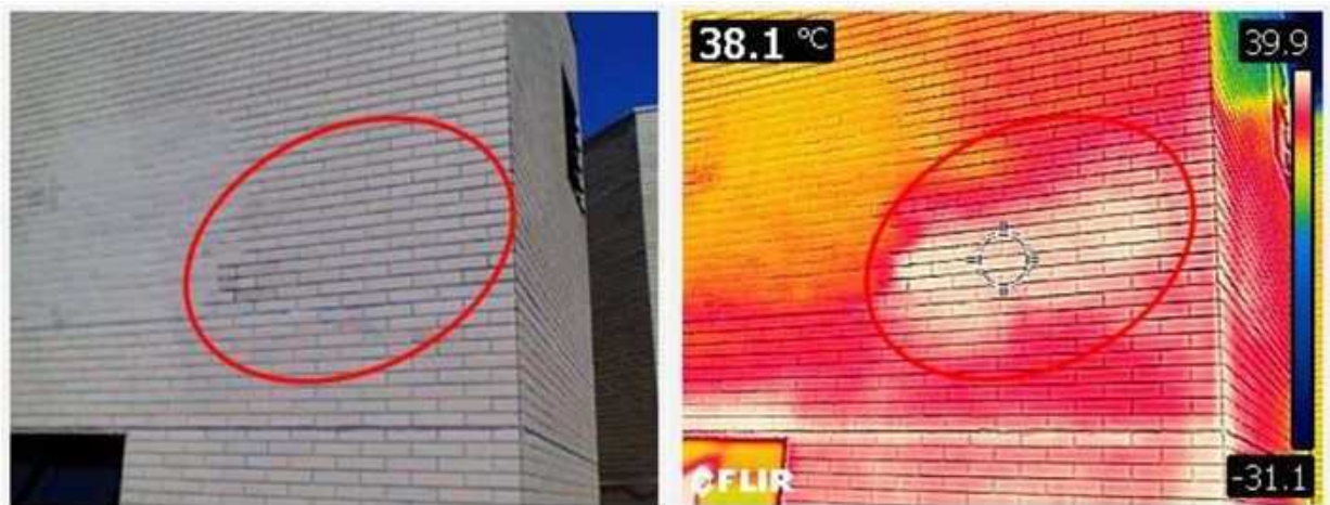
Figura 10 - Uso de termografia infravermelha
