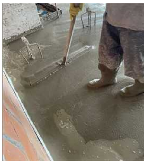
Figura 14 – Acabamento na argamassa fluida
