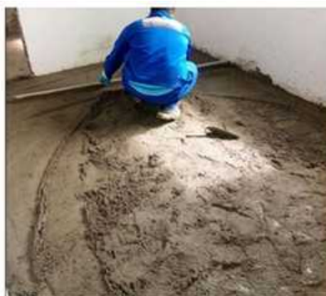
Figura 9 – Sarrafeamento da argamassa
