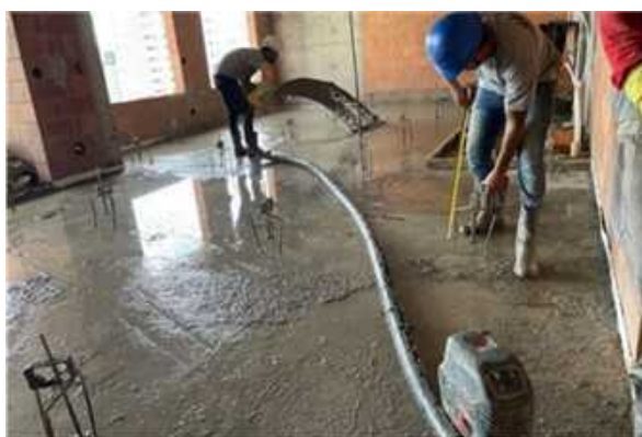
Figura 12 – Distribuição de niveletas
