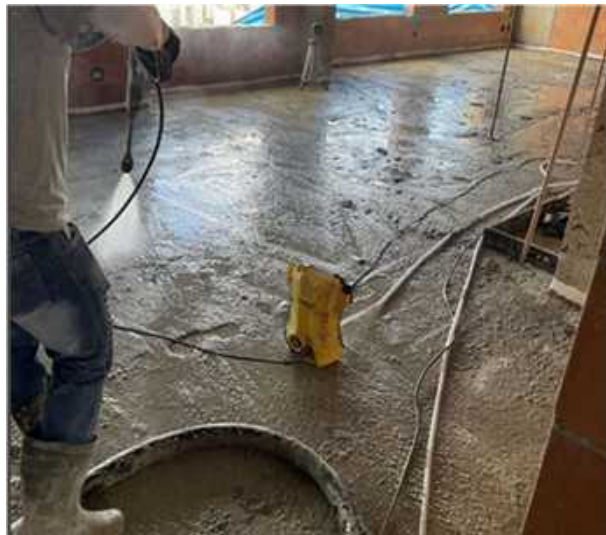
Figura 11 – Limpeza da base, para a remoção de impurezas
