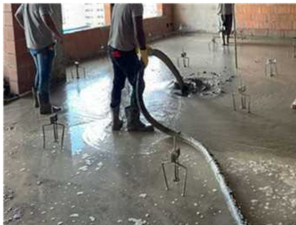
Figura 13 – Lançamento da argamassa fluida
