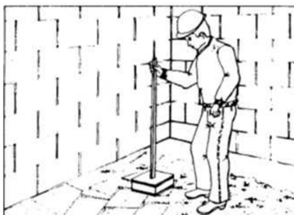
Figura 8 – Apiloamento do contrapiso
