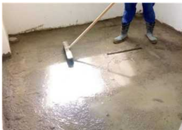
Figura 6 – Limpeza da base e realização da ponte de aderência
