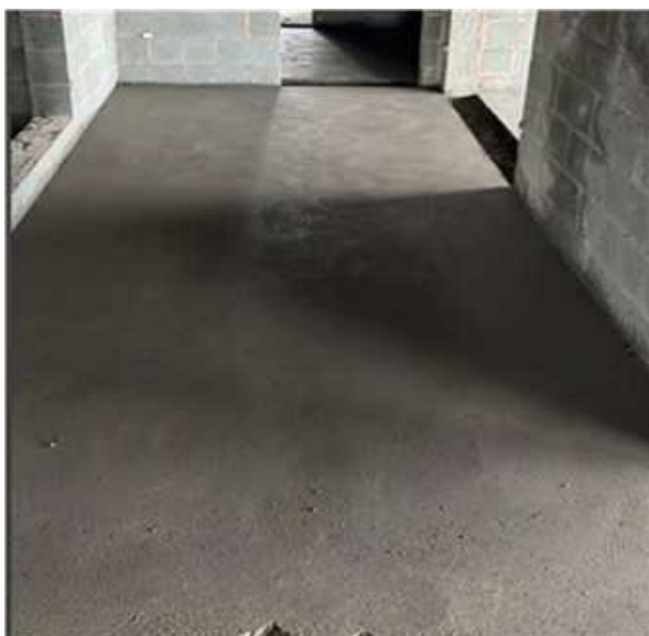
Figura 10 – Acabamento do contrapiso
