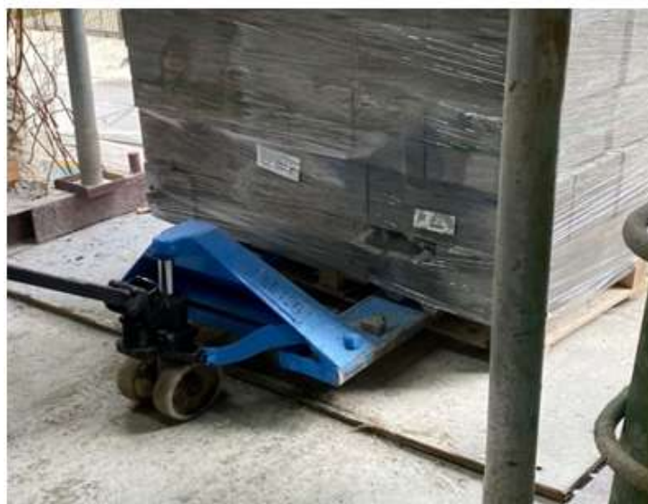
Figura 18. Desnível entre a saída da plataforma de madeira e a entrada da laje do andar.
