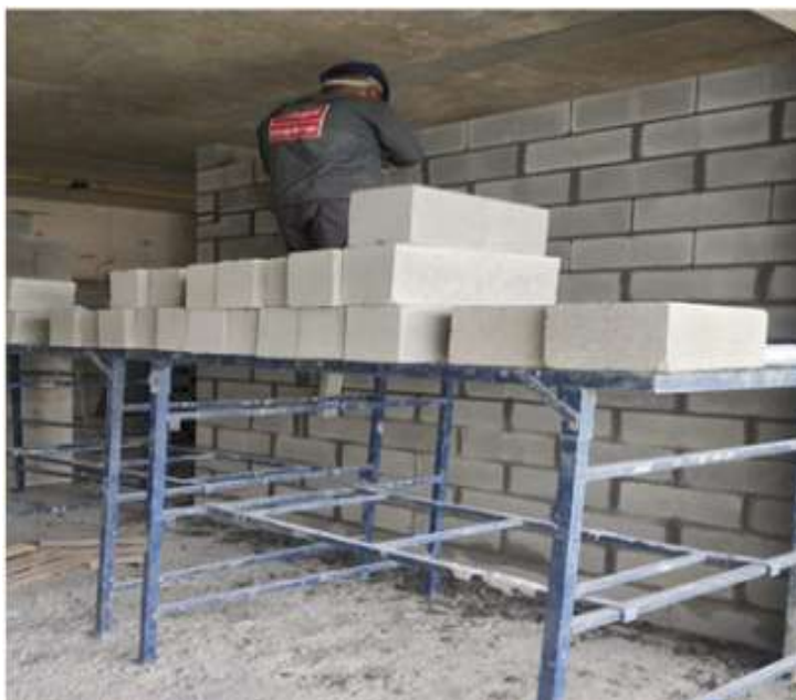
Figura 19. Pedreiro executando a alvenaria de vedação, utilizando mesa andaime.
