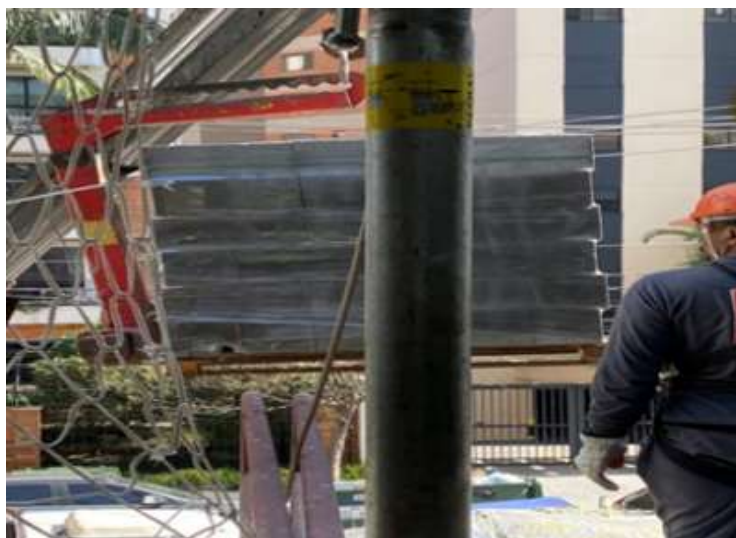
Figura 16. Descarga do pallet de blocos.
