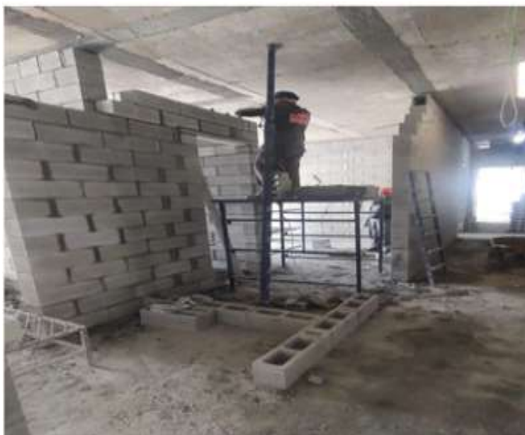
Figura 22. Pedreiro executando a alvenaria de vedação, utilizando mesa andaime.
