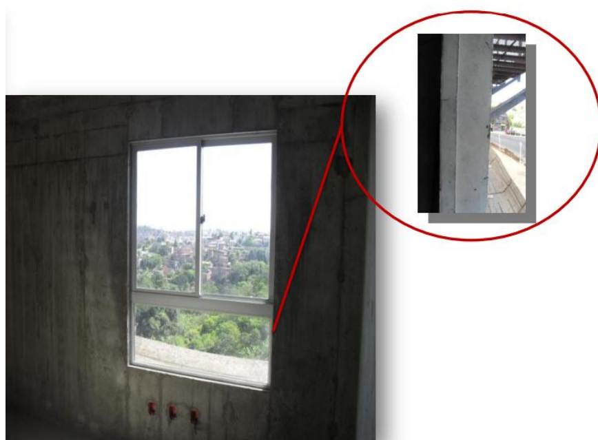
Figura 3.3: Rebaixo do concreto na função de contramarco - Fôrma de alumínio Fonte: ABESC – Parede de concreto em edifícios altos
