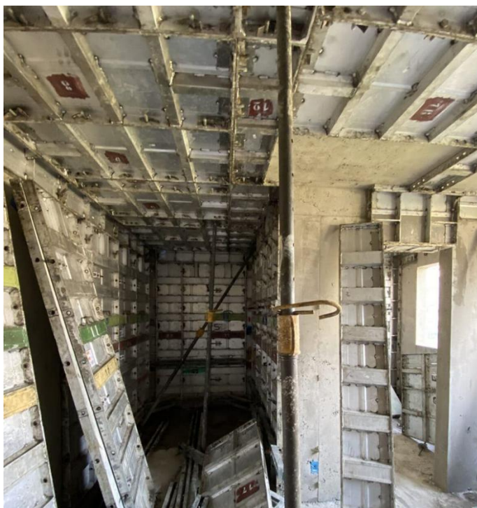
Figura 3.1: Retrato do sistema de fôrmas após concretagem Fonte: Acervo do autor
