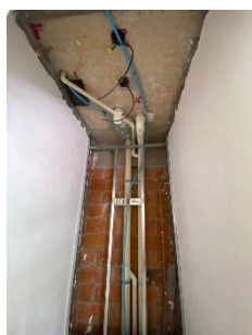
Kit travessa registro e kit aranha esgoto e chicote em PEX
