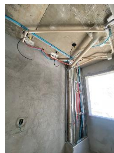
Kit Aranha (Esgoto) e Kit Chuveiro (PEX)
