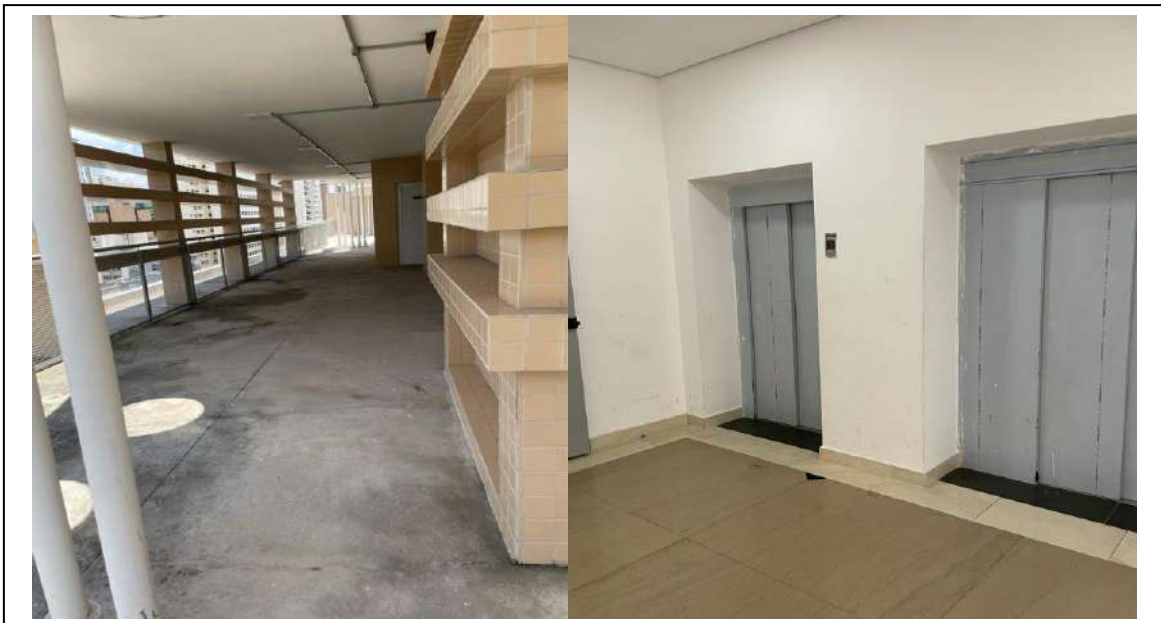
Figura 16: Terraço e elevadores prédio existente
