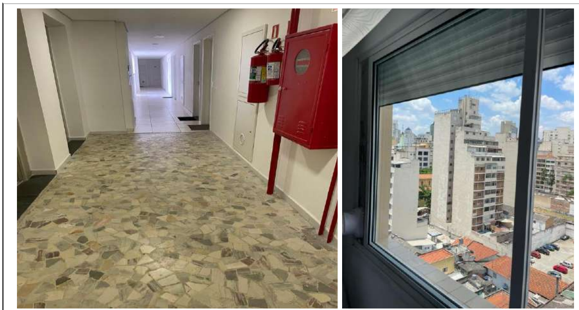
Figura 17: Revestimento que foram mantidos na área escada e circulação e caixilho utilizado nos apartamentos
