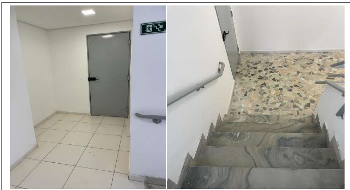
Figura 12: Foto da circulação enclausurada à prova de fumaça
