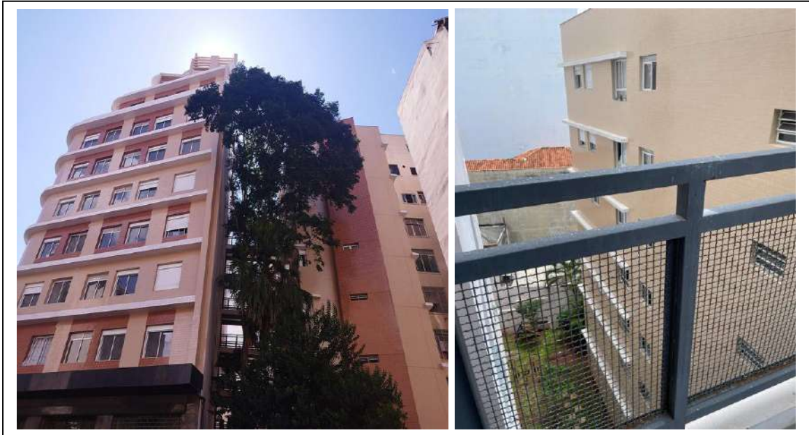
Figura 13- Foto da fachada depois da troca de revestimento
