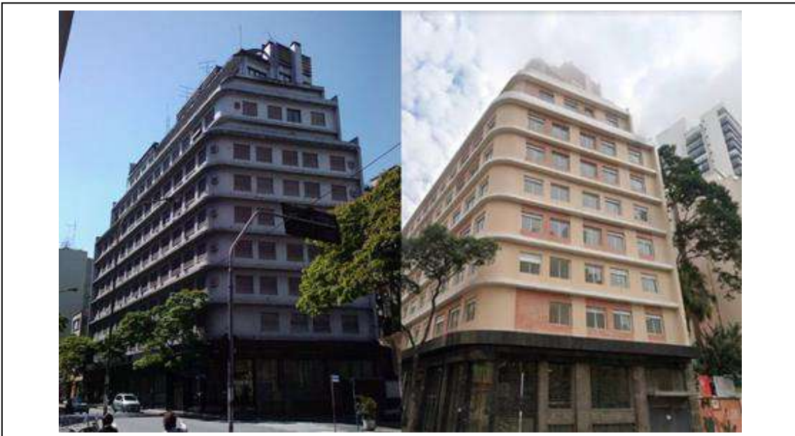
Figura 14: Antes e Depois do imóvel reabilitado
