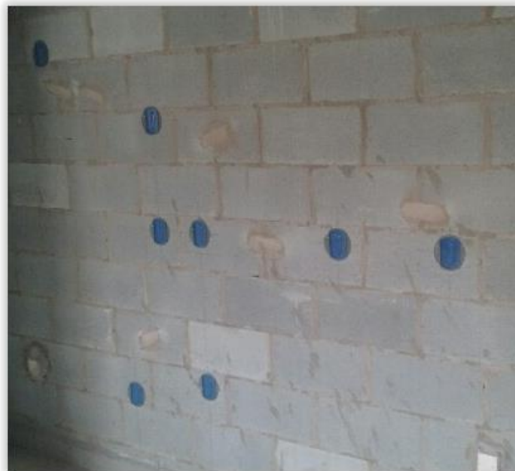
Figura 20 – Distribuição elétrica executada
