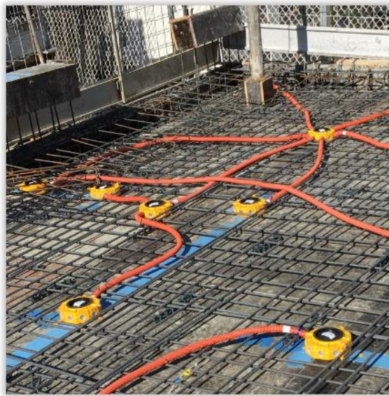
Figura 16 – Kit elétrico distribuído na laje
