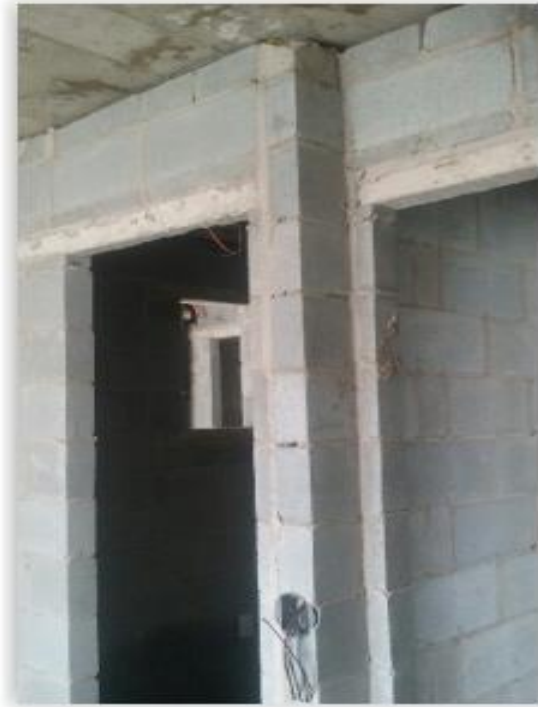
Figura 19 – Caixas para interruptor e tomada posicionadas
