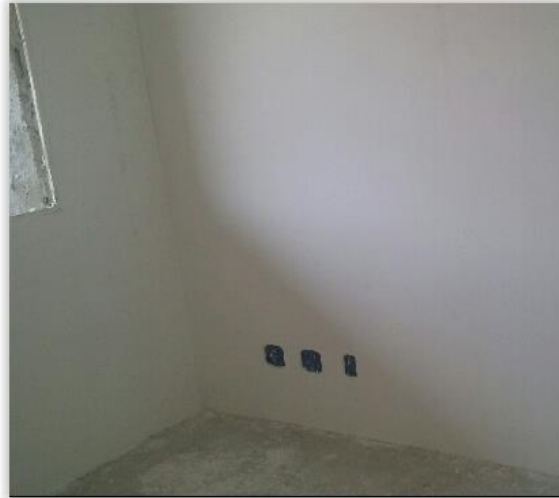
Figura 21 – Distribuição elétrica e revestimento executado
