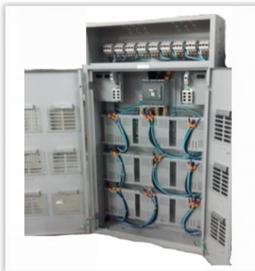
Figura 11 – Caixa de medição eletrônica descentralizada
