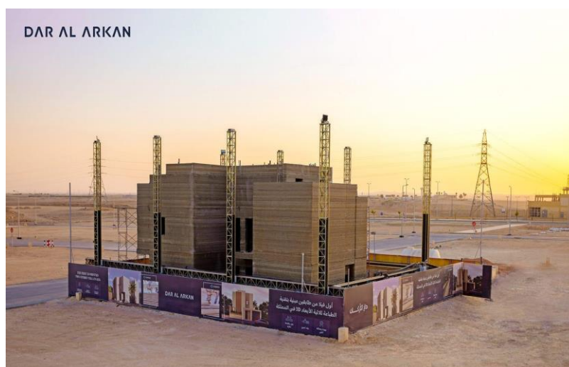
Figura 22 - Construção impressa pela Dar Al Arkan
