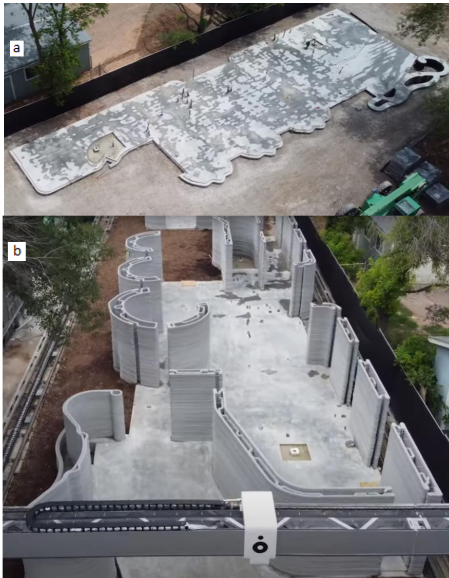
Figura 16 - Etapas construtivas da fundação (a) e da elevação das paredes (b)
