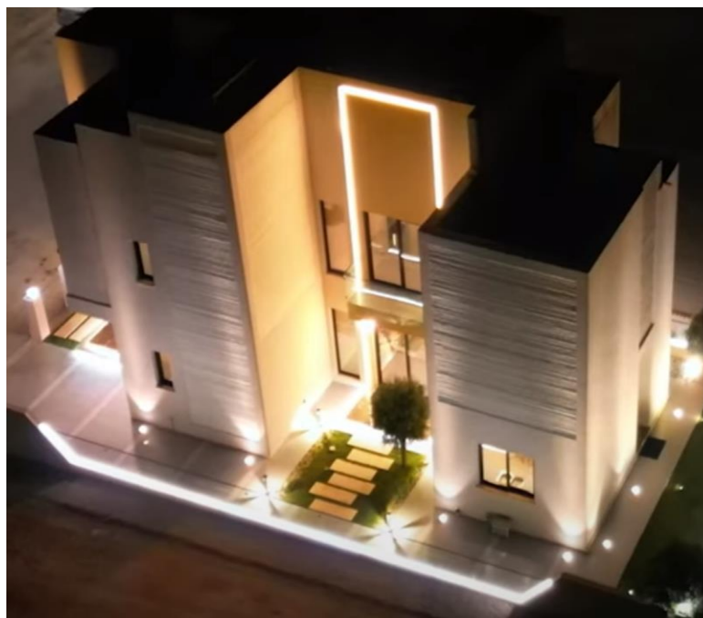
Figura 23 - Construção impressa pela Dar Al Arkan
