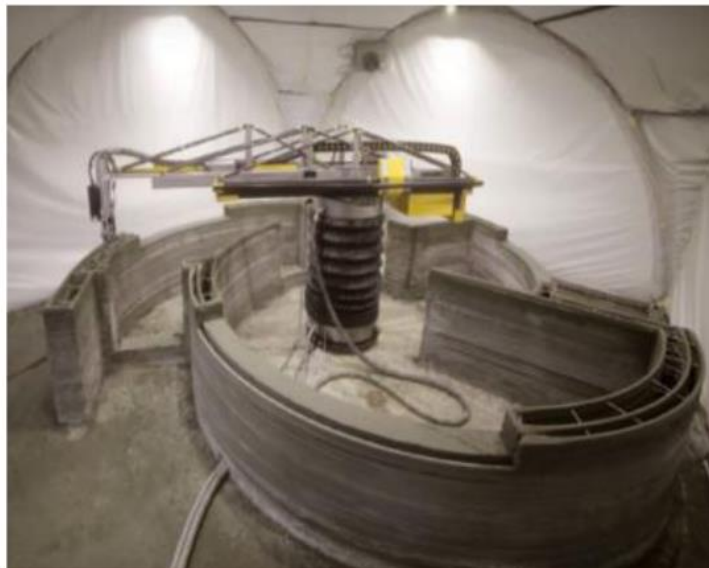
Figura 6- Impressão 3D de concreto por um braço robótico fixo
