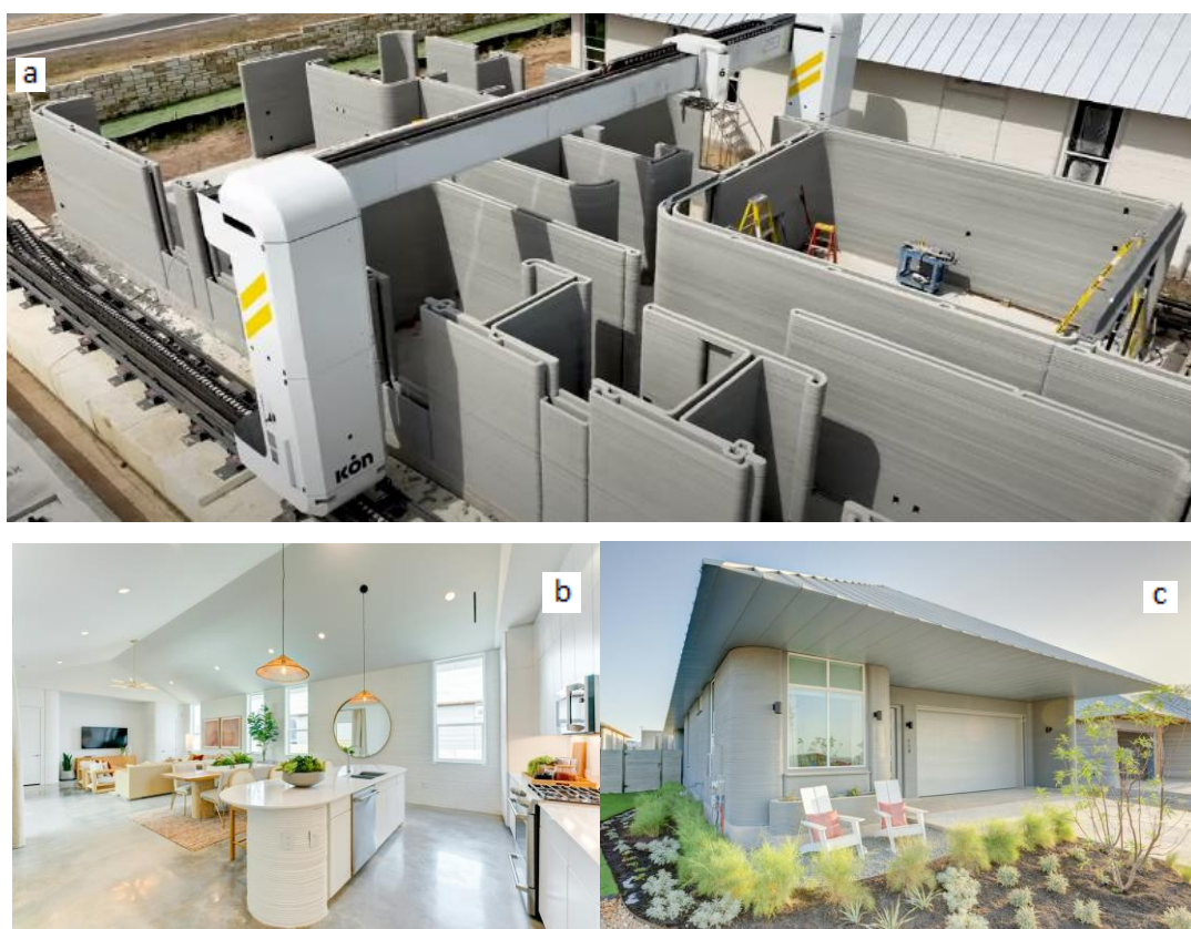
Figura 17 - Processo de impressão (a) e acabamentos da construção (b) e (c)
