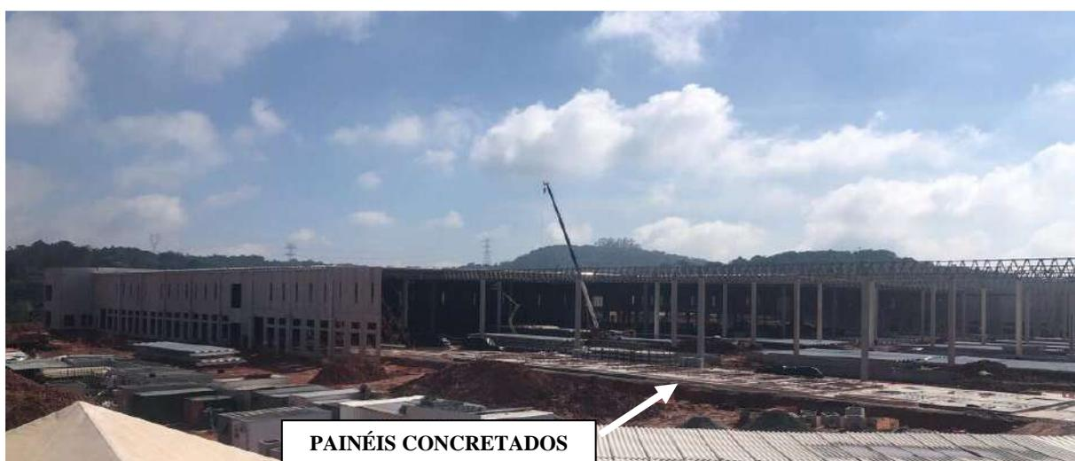
Figura 32 – Fotografia placas de concreto do sistema *tilt up* (Fonte: Autora)
