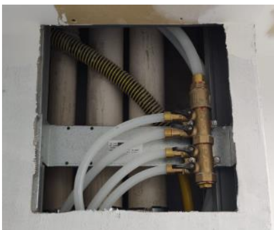
Figura 8 - Kit manifold (módulo distribuidor) para sistema PEX
