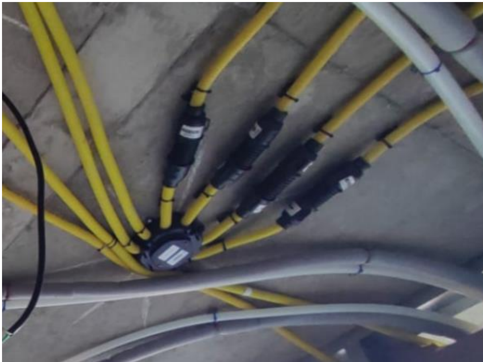
Figura 12 – Sistema de encaixe de conexão elétricas
