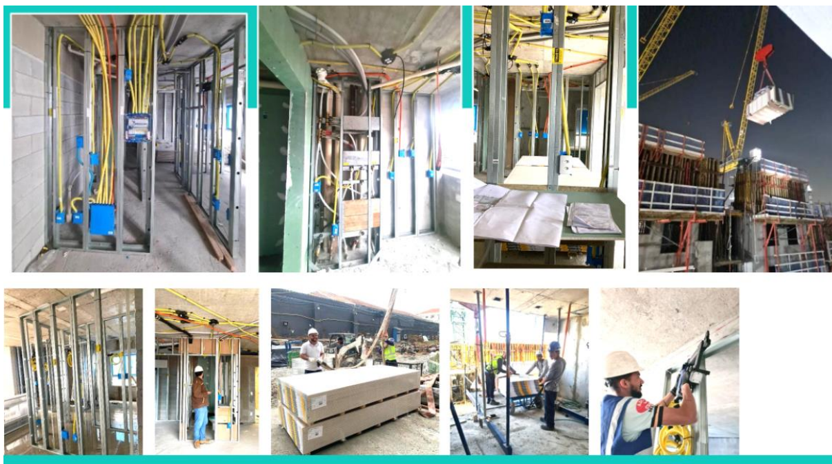
Figura 22 - Projeto Side Barra Funda (Trisul) em Execução
