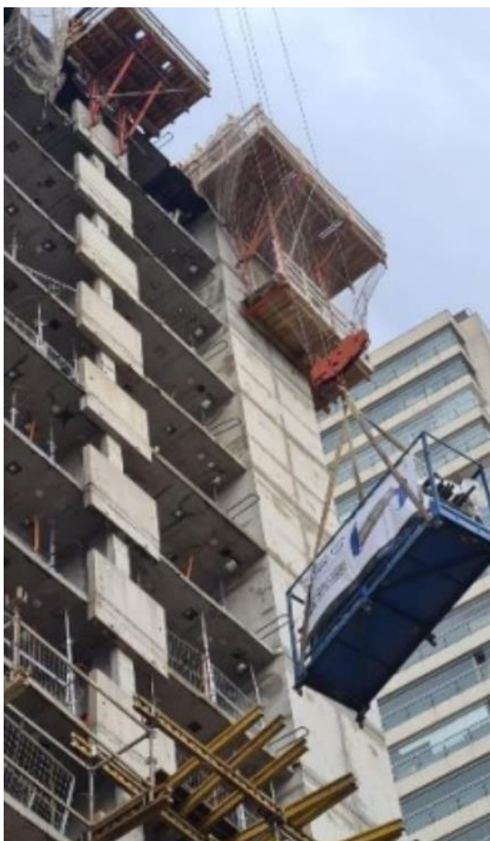
Figura 17 - Içamento dos módulos de shafts hidráulicos por grua até o pavimento de destino
