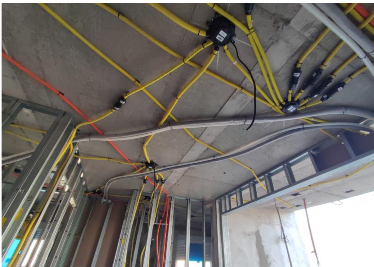
Figura 10 - Chicote elétrico pré-montado instalado e testado
