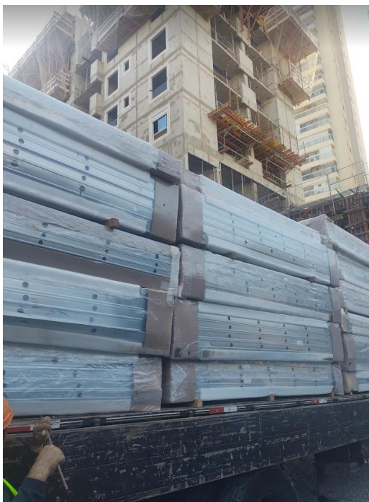
Figura 15 - Recebimento dos módulos em caminhão truck
