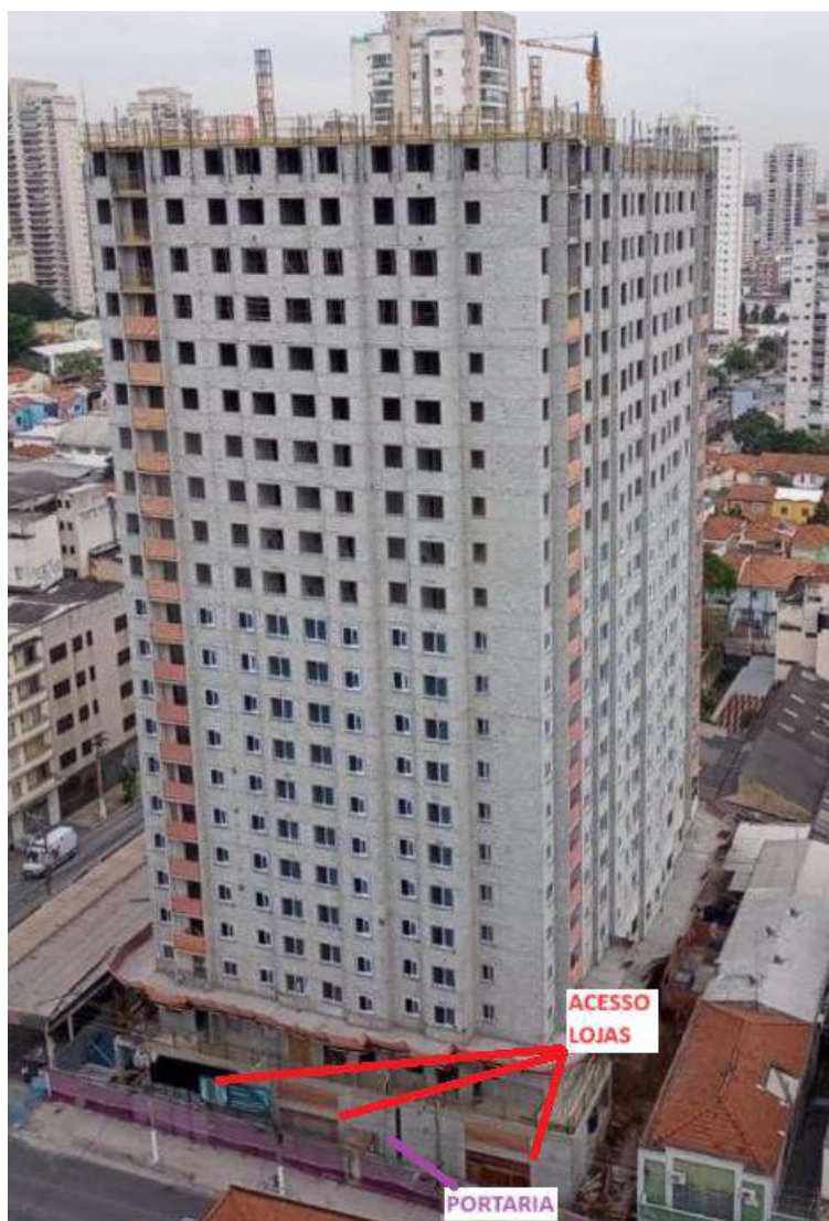
Figura 40- Acesso portaria rua Caio Graco - Caso B
