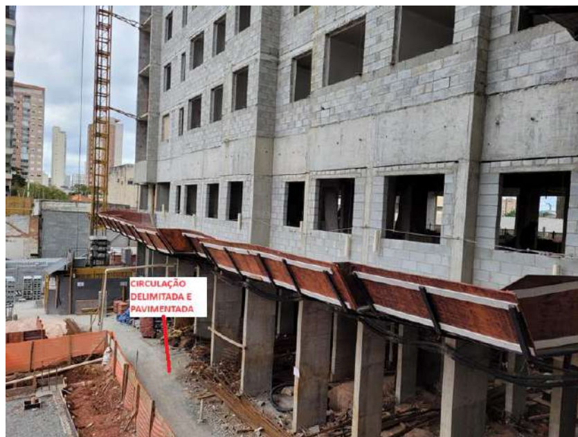
Figura 38 - Circulação fase inicial de estrutura - Caso B
