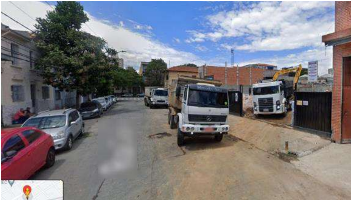
Figura 10 - Via de acesso Caso A
