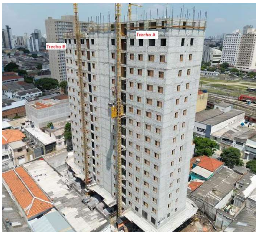
Figura 29 - Divisão da estrutura em trechos - Caso A
