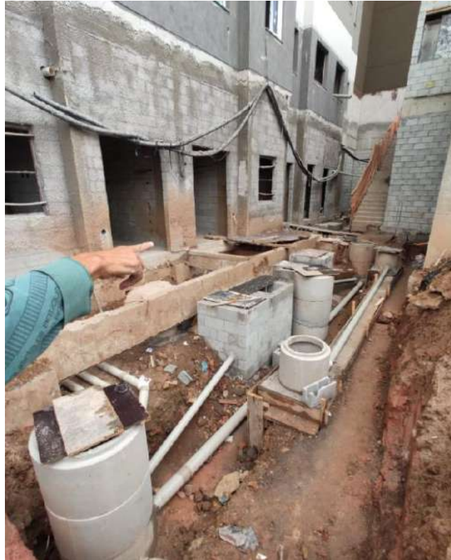
Figura 47 - Trecho utilizado para transporte horizontal interdito - Caso B
