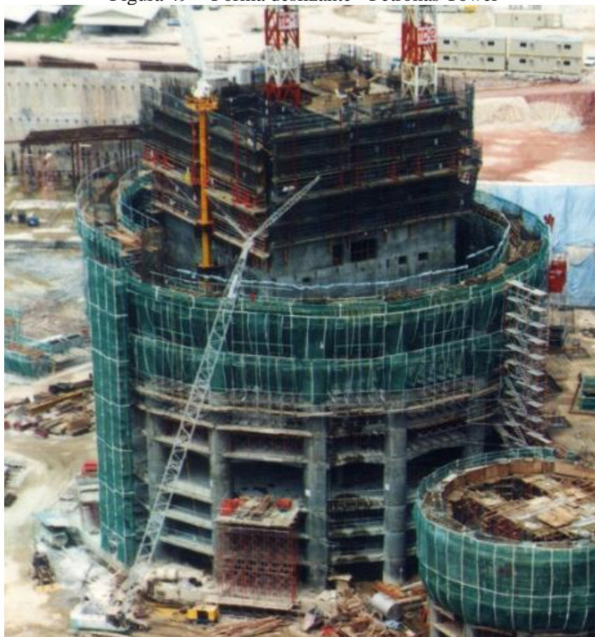
Figura 49 - Forma deslizante - Petronas Tower
