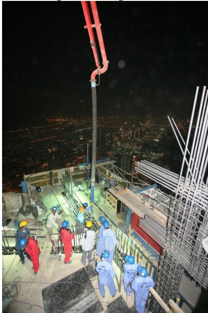
Figura 7 – Concretagem noturna
