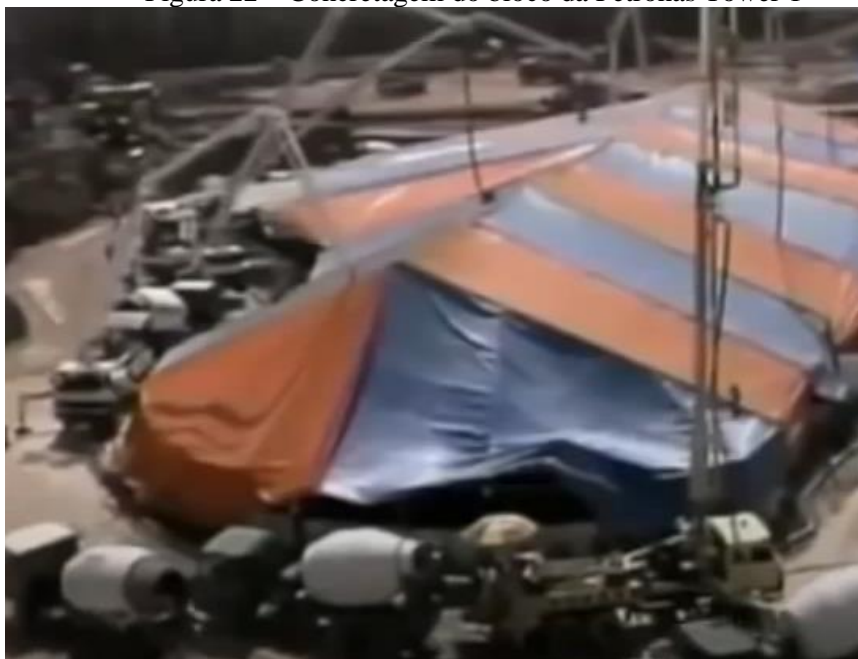
Figura 22 – Concretagem do bloco da Petronas Tower 1
