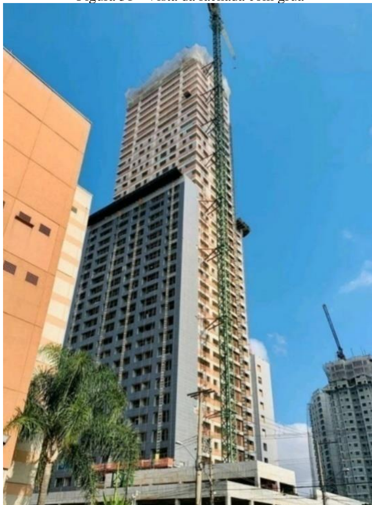
Figura 31 - Vista da fachada com grua
