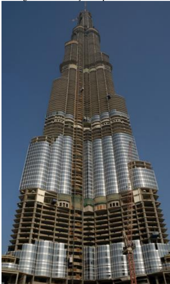
Figura 9 – Instalação de painéis de vidro
