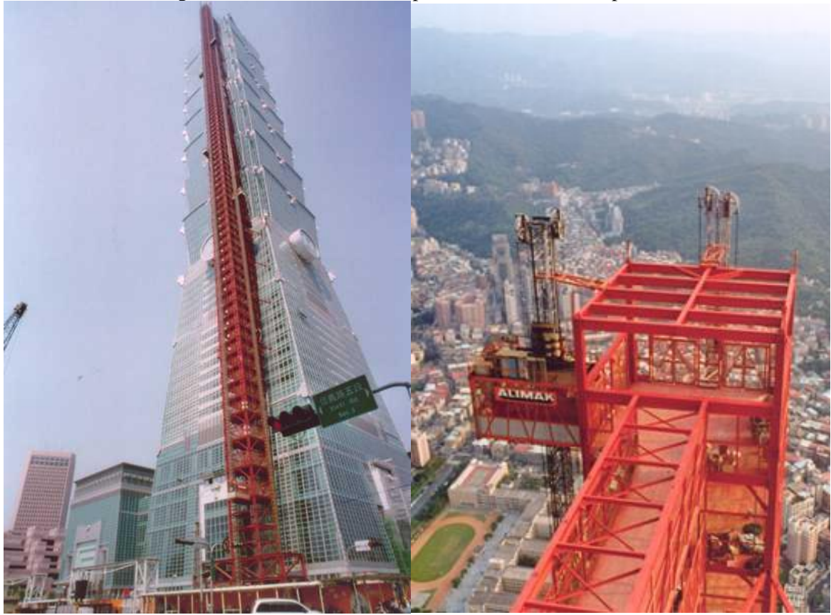
Figura 45 – Estrutura auxiliar para cremalheira do Taipei 101
