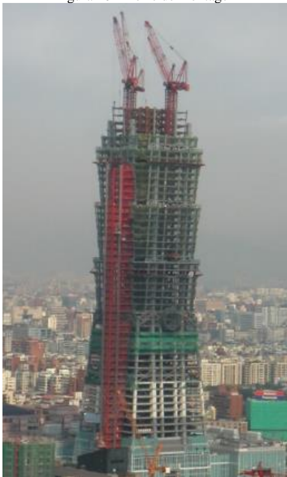
Figura 20 – Torre de montagem
