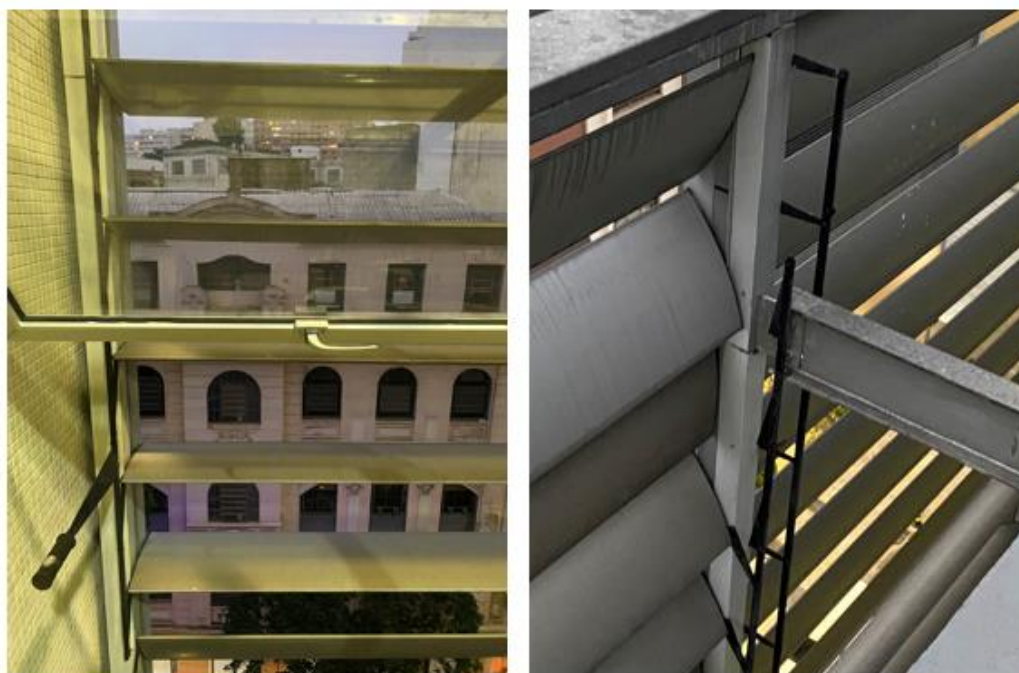
Figura 28 – Acionamento móvel dos brises
