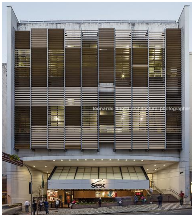
Figura 27 – Brises da fachada atual do Sesc Consolação
