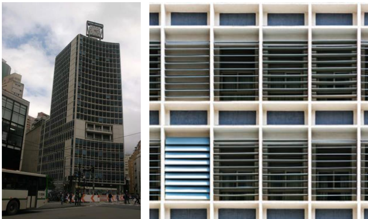
Figura 7 - Edifício O Estado de São Paulo - fachada em grelha e brises
