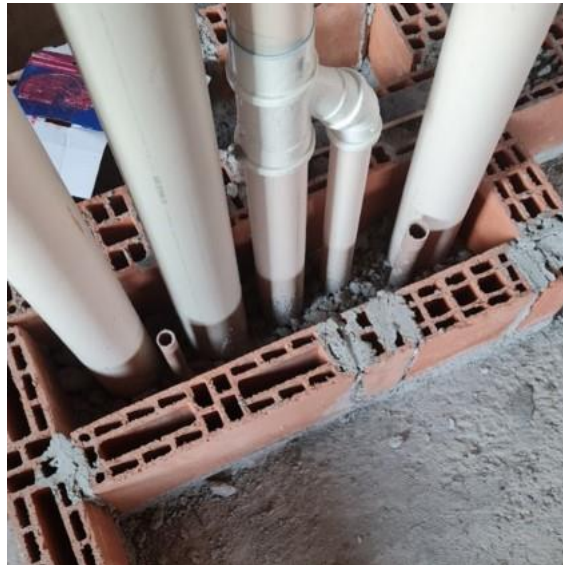
Figura 86: Marcação de 1ª fiada executada.
