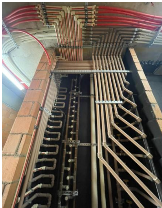
Figura 90: Coluna principal com sistema rígido e transição para sistema PEX.
