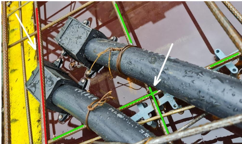
Figura 80: Caixa de ligação e fixação do tubo luva na armação positiva.
