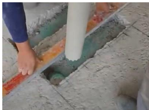
Figura 84: Furações sucessivas no passante em espuma.
