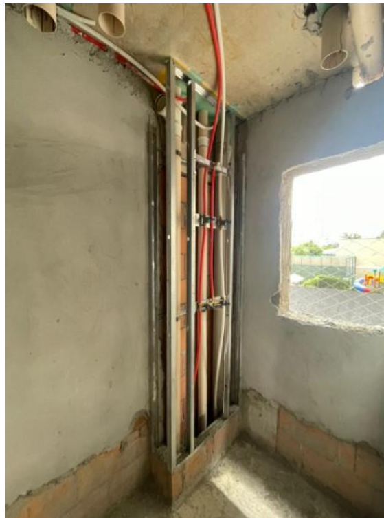
Figura 96: Shaft protótipo banheiro.
