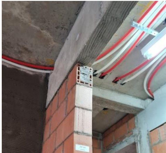
Figura 94: Entrada do ramal principal por furo em viga e tubo luva.
