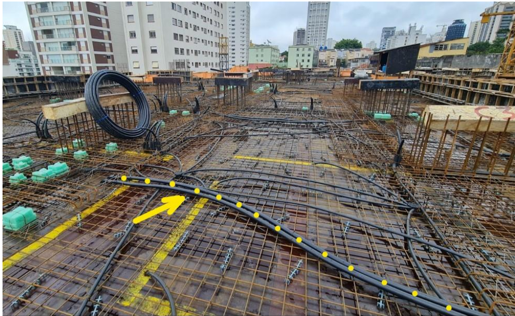
Figura 81: Tubos de elétrica e tubos luva.
