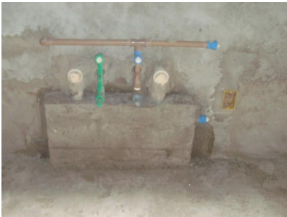
Figura 69: Enchimento em graute sob bancada de cozinha.
