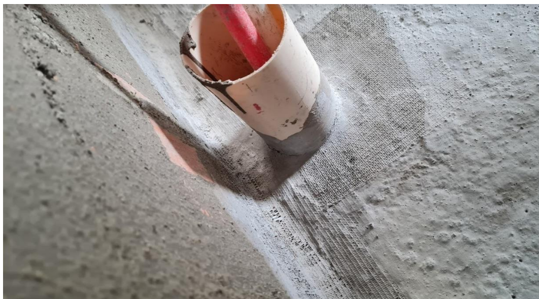
Figura 70: Passantes ou camisas e coifas para tubos de esgoto e PEX.
