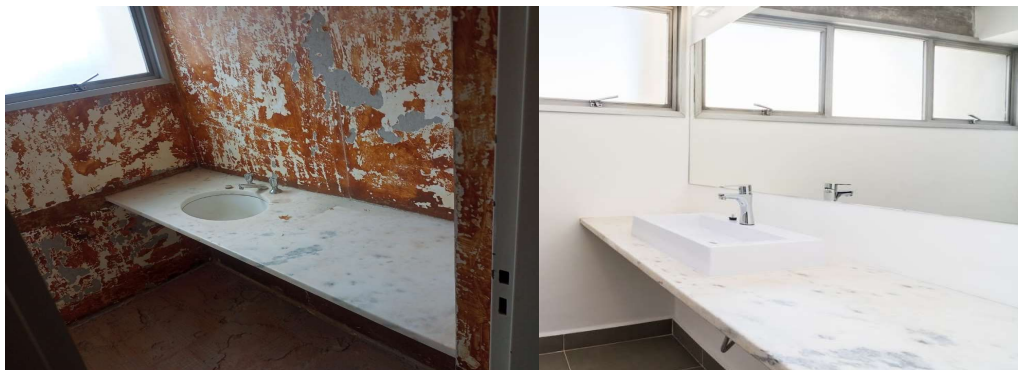
Figura 52 - Antes e Depois - Banheiro suíte
