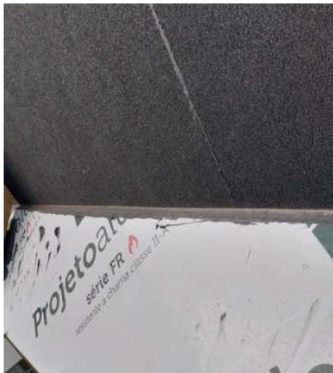
Figura 36- Conferência de vedação pela equipe de engenharia
