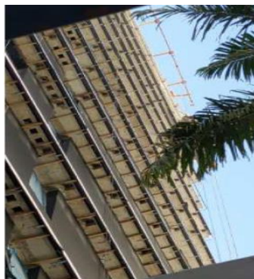
Figura 38- Instalação de estrutura para confecção do forro de madeira
