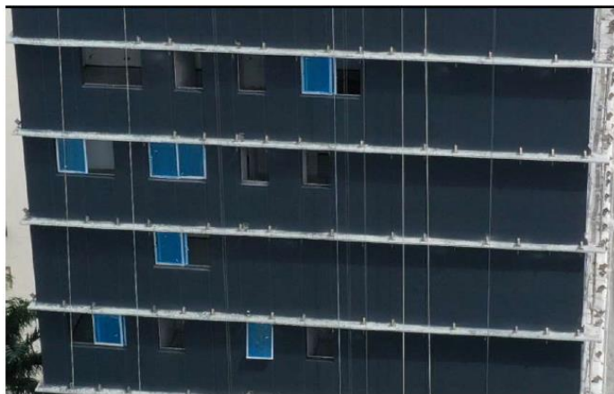
Figura 33- Insert Instalados na Aba superior e inferior
