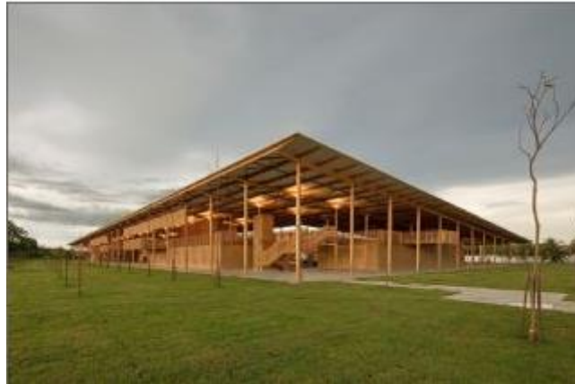
Figura 20- Moradas Infantis, Fundação Bradesco
