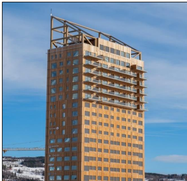
Figura 18- Edifício Mjøstårnet, Noruega
