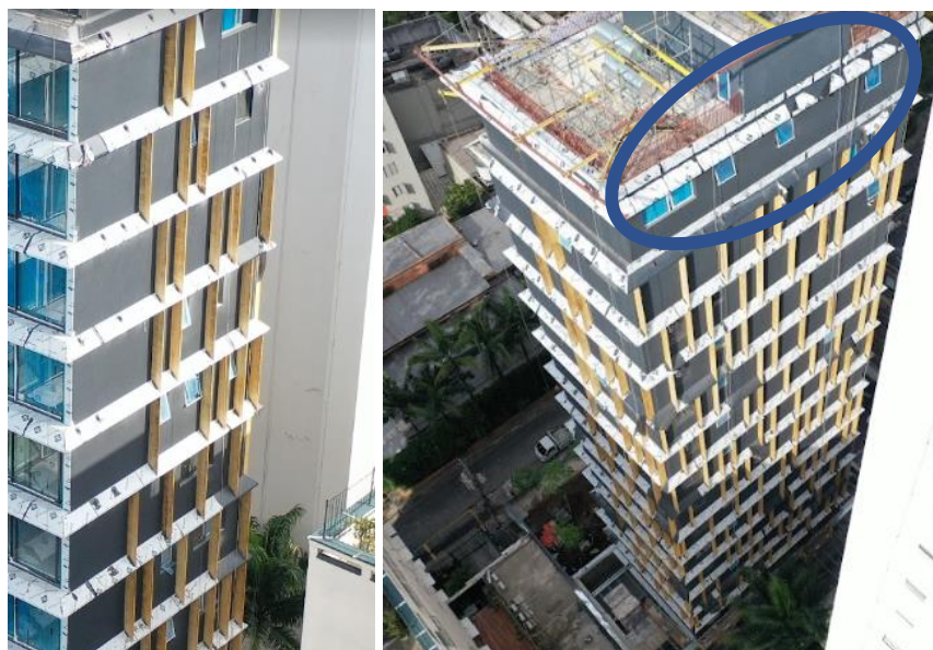
Foto: Instalação de revestimento fachada (Fonte: Autor).
