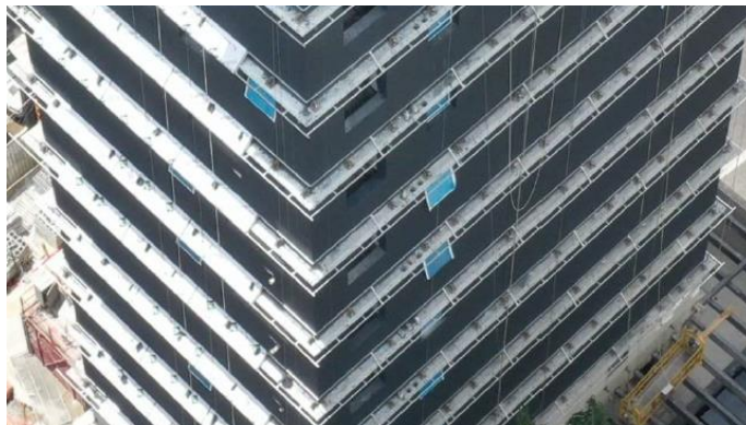
Figura 34- Montagem da Estrutura e conferência do nivelamento
