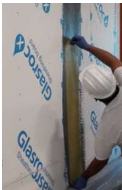
Figura 42 - Aplicação da tela de reforço
