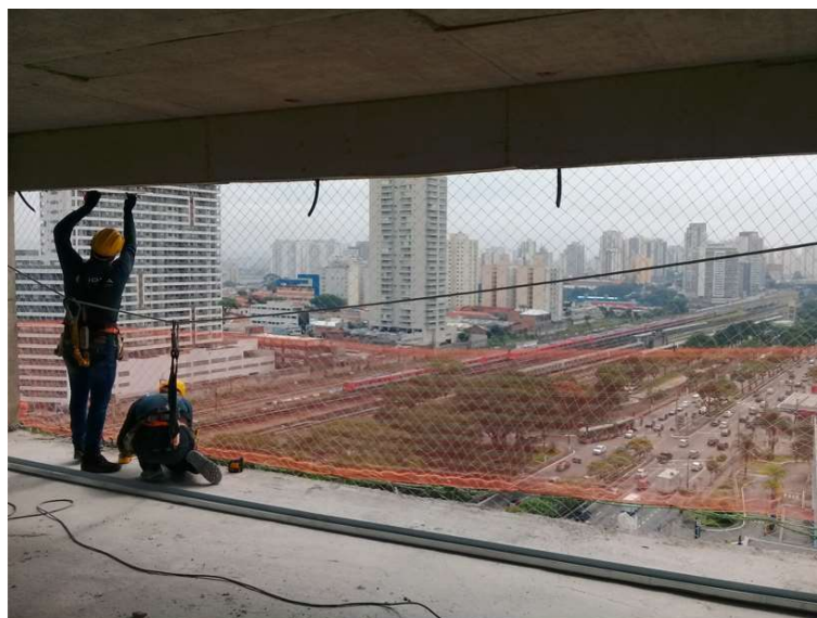
Figura 51 - Vista da proteção periférica utilizada
