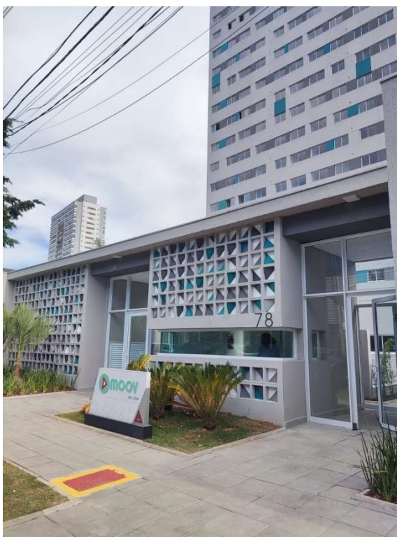
Figura 47 - Entrada do empreendimento
