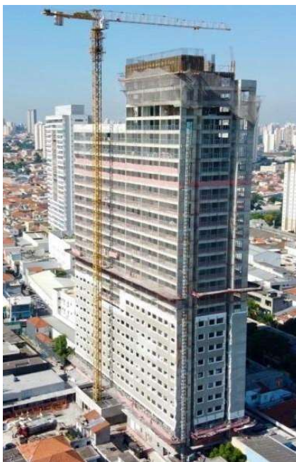
Figura 50 - Posicionamento da grua
