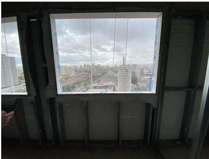
Figura 30 - Instalação do Tyvek Home Wrap
