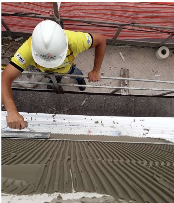
Figura 44 - Aplicação do basecoat
