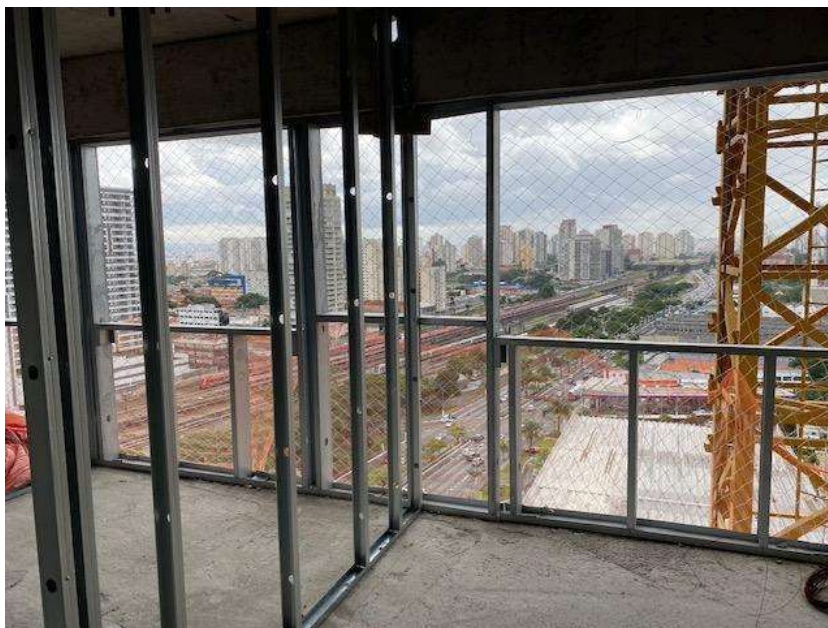
Figura 27 - Montagem dos quadros em LSF e montagem do drywall simultaneamente
