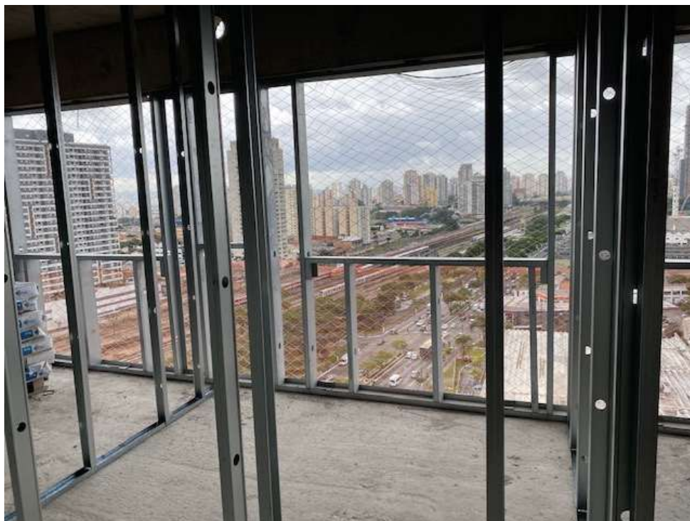
Figura 26 - Vista interna da montagem pelo método embutido
