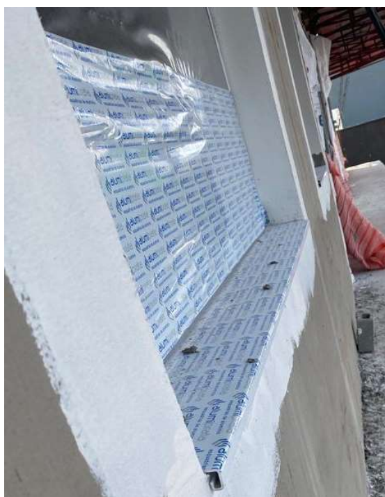
Figura 35 - Chapa em alumínio instalada formando o peitoril
