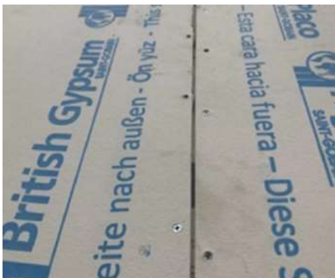
Figura 31 - Detalhamento dos parafusos
