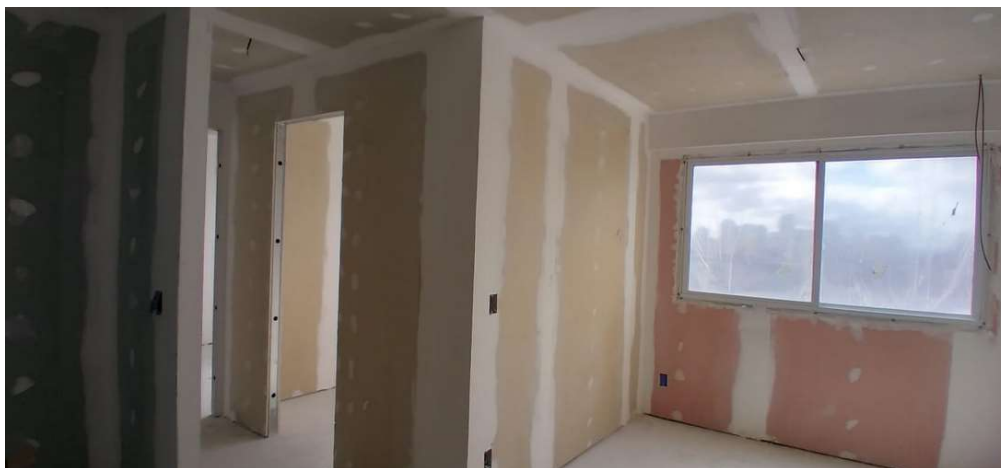
Figura 40 - Aplicação da massa de tratamento de juntas entre as chapas e parafusos
