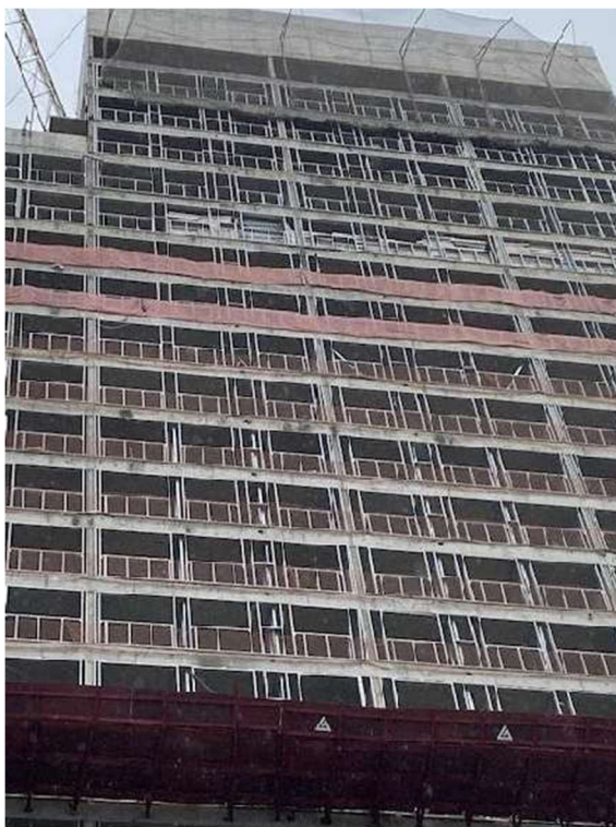
Figura 25 - Utilização do método embutido de montagem dos painéis de LSF
