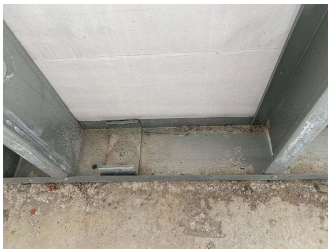
Figura 29 - Fixação da guia na laje
