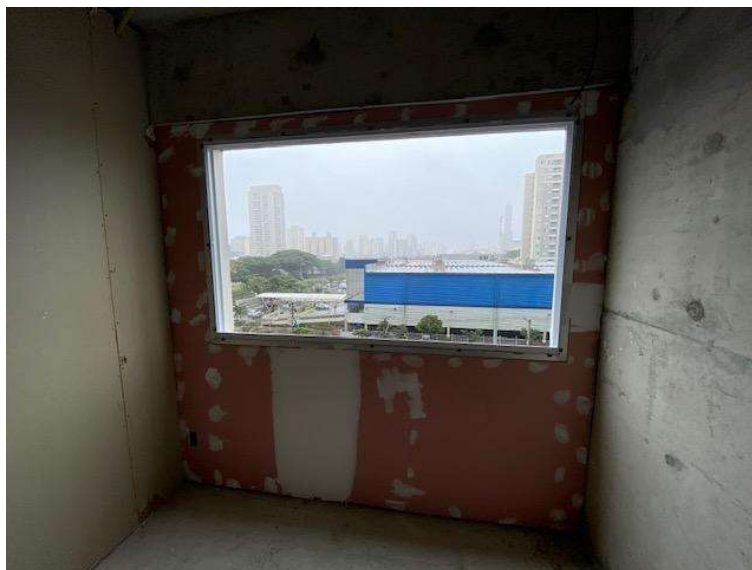
Figura 39 - Utilização de chapa RF no lado interno da vedação
