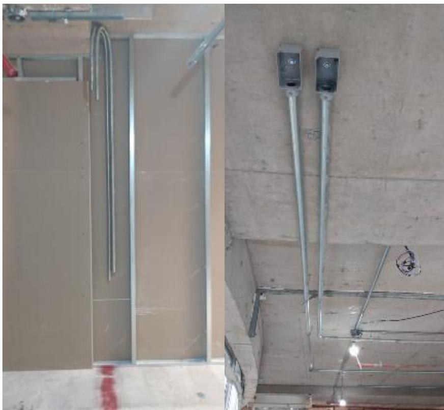
Os trechos contínuos de tubulação, sem interposição de caixas ou equipamentos, não devem exceder 15m de comprimento para linhas internas às edificações e 30m para as linhas em áreas externas às edificações, se os trechos forem retilíneos. Se os trechos incluírem curvas, o limite de 15m e o de 30m devem ser reduzidos em 3m para cada curva de 90°. (NBR 5410, 2004, p. 120).
