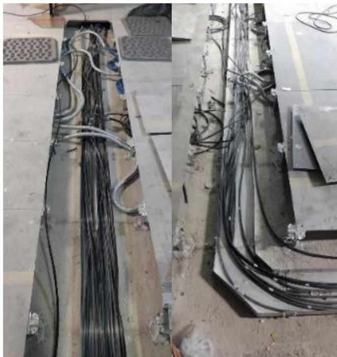
Assim como na obra A, o serviço de cabeamento elétrico feito pelo piso representou aproximadamente 85% do cabeamento total no pavimento. Isto ocorreu porque a maior parte de pontos de utilização estão localizados em mesas de estações de trabalho e, que são alimentados pelos circuitos passados pelo piso. Então, uma boa produtividade do serviço de passagem de fios dependia da execução pelo piso.
