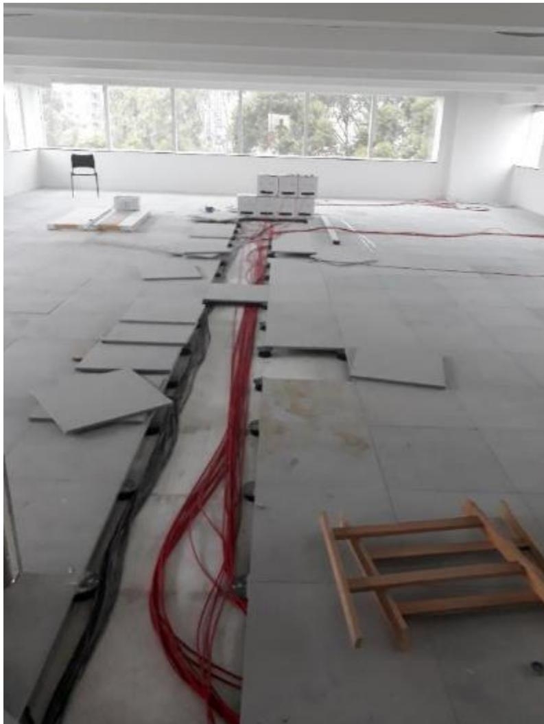
Na execução do cabeamento elétrico dos circuitos que passavam pelas paredes, piso e teto, os fios e cabos foram passados diretamente no piso ou pelos eletrodutos de 1" e 3/4" de acordo com a indicação no projeto dos circuitos. Nas obras foram usados fios e cabos de 2,5mm, 4,0mm, 6,0mm, 8mm e 10mm.
