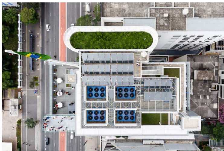
Fotografia 19 – Placas Solares na Cobertura
