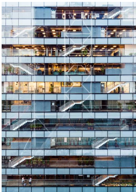
Fotografia 10 – Escadas junto a fachada
