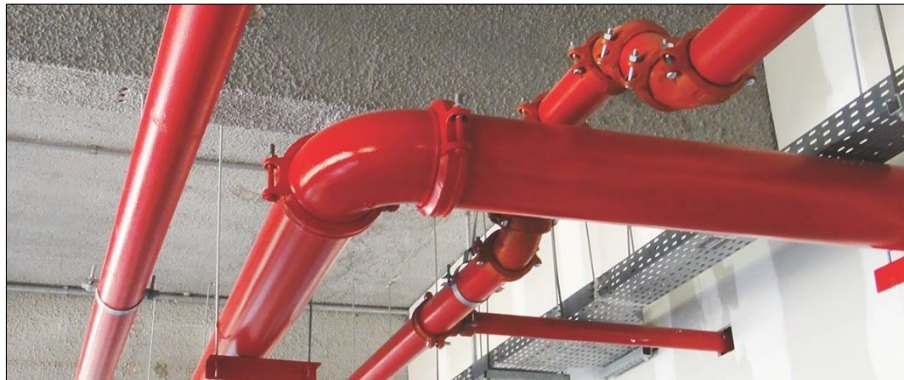
Figura 2.20 – Acoplamento mecânico ranhurado em sistemas de chuveiros automáticos
