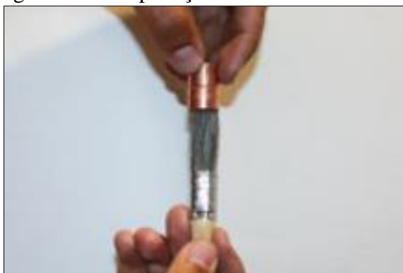
Figura 2.18 – Aplicação de fluxo de solda na conexão
