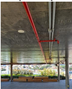
Figura 3.31 – Chuveiro tipo pendente (pendent)
