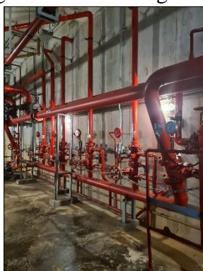
Figura 3.26 – Vista geral das VGAs
