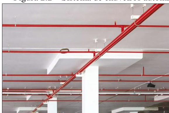
Figura 2.2 – Sistema de chuveiros automáticos
