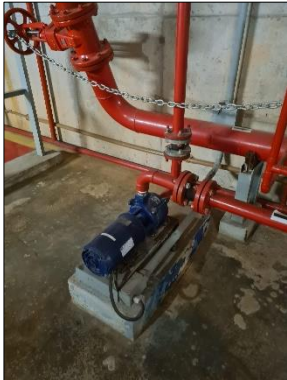
Figura 3.28 - Eletro-bomba auxiliar
