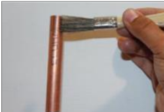
Figura 2.17 – Aplicação de fluxo de solda em tubo
