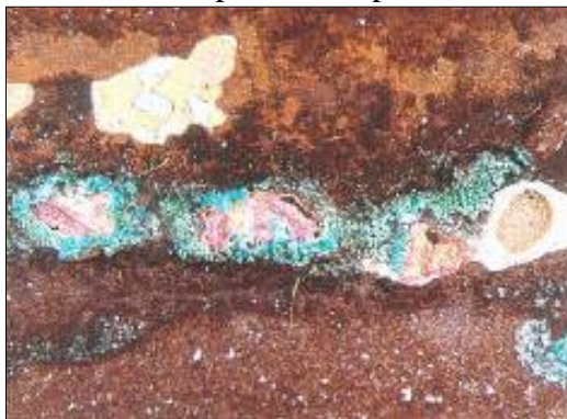
Figura 2.15 – Corrosão e pites em superfície interna de tubo de cobre
