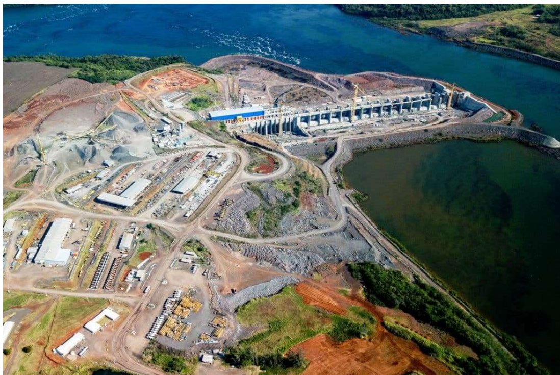
Figura 8 – Vista geral do empreendimento (foto do dia 05/10/2017)
