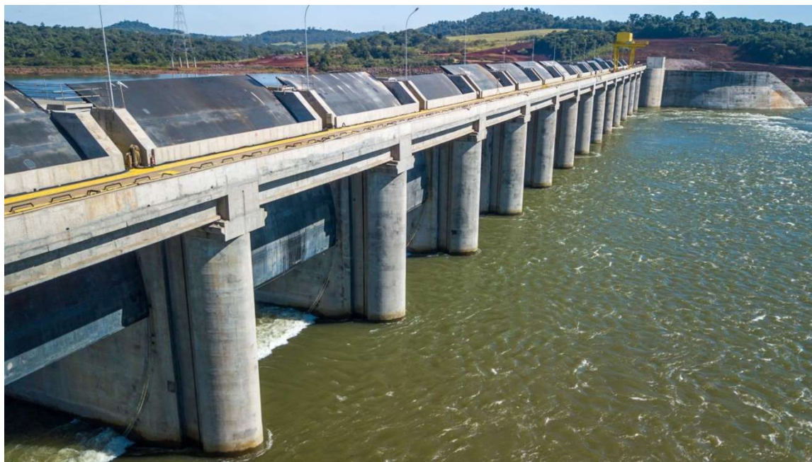
Figura 38 – Vista do vertedouro em operação
