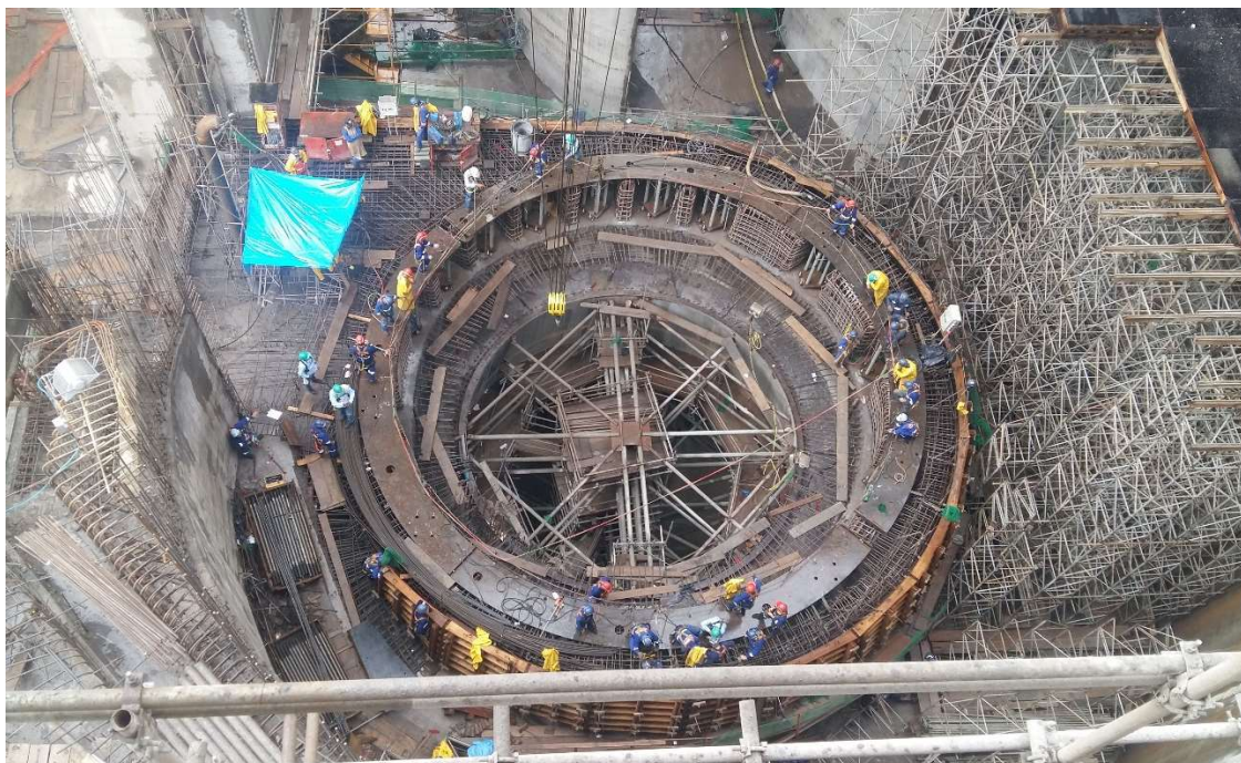
Figura 34 – Vista superior da caixa espiral em montagem
