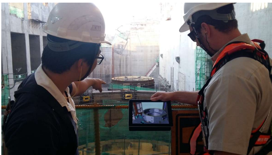
Figura 35 – Modelo BIM sendo utilizado para a visualização no canteiro de obra
