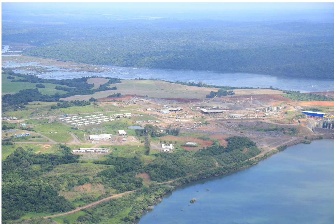
Figura 22 – Vista aérea do canteiro
