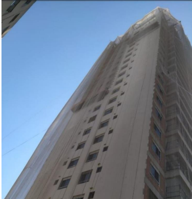
Figura 25 – Execução do EIFS no segundo estudo de caso
