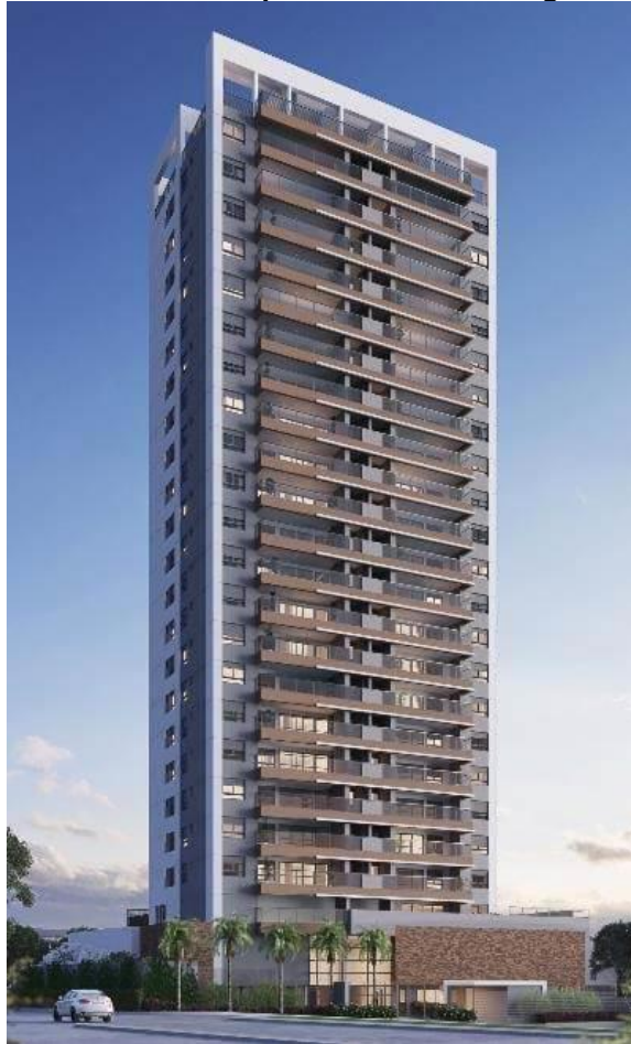
Figura 11 - Imagem da fachada do empreendimento do segundo estudo de caso
