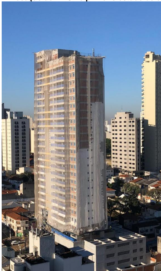
Figura 19 – Execução do EIFS no primeiro estudo de caso
