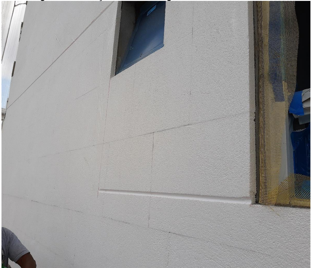
Figura 24 - Execução do EIFS no segundo estudo de caso
