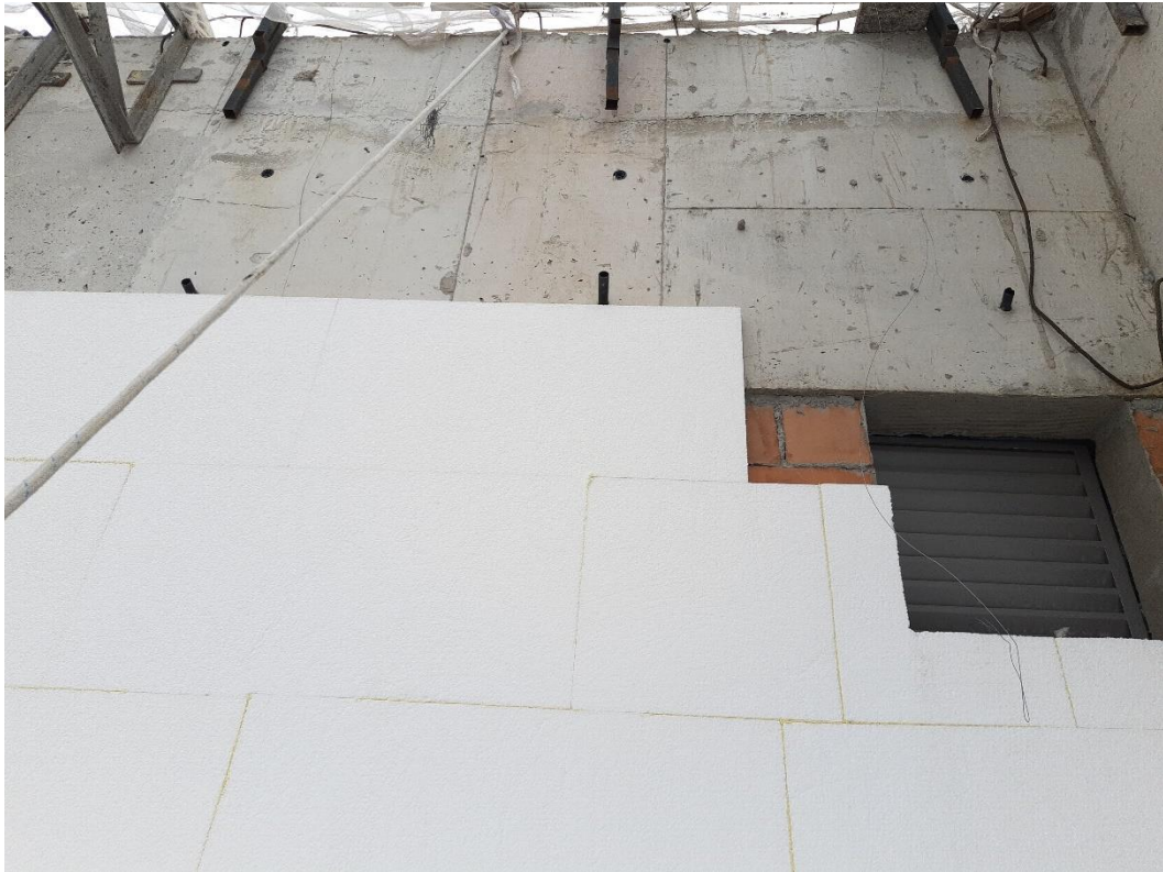
Figura 14 - Execução do EIFS no primeiro estudo de caso
