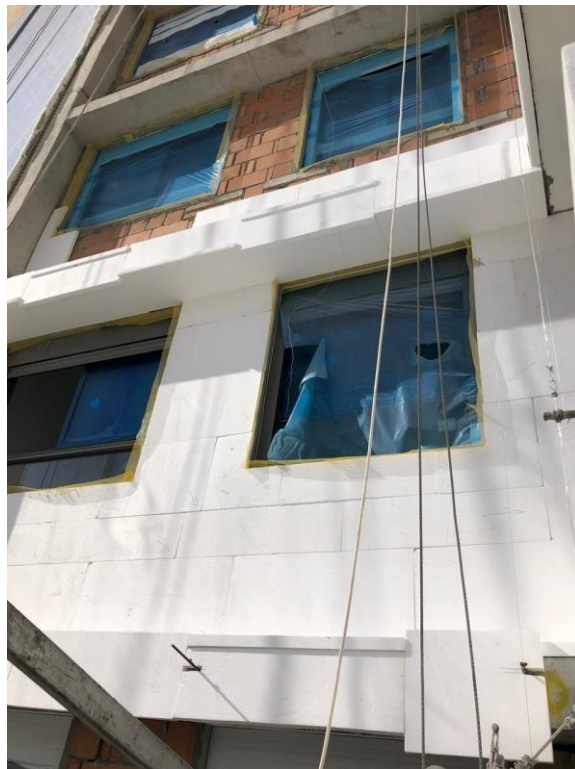
Figura 15 - Execução do EIFS no primeiro estudo de case
