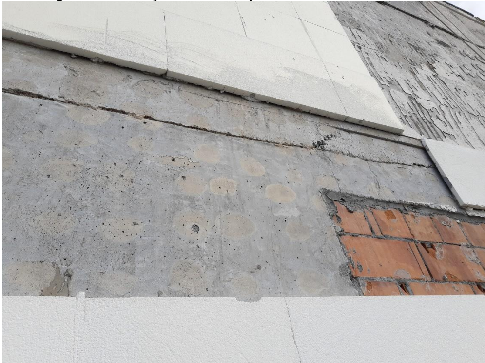
Figura 16 - Execução do EIFS no primeiro estudo de caso
