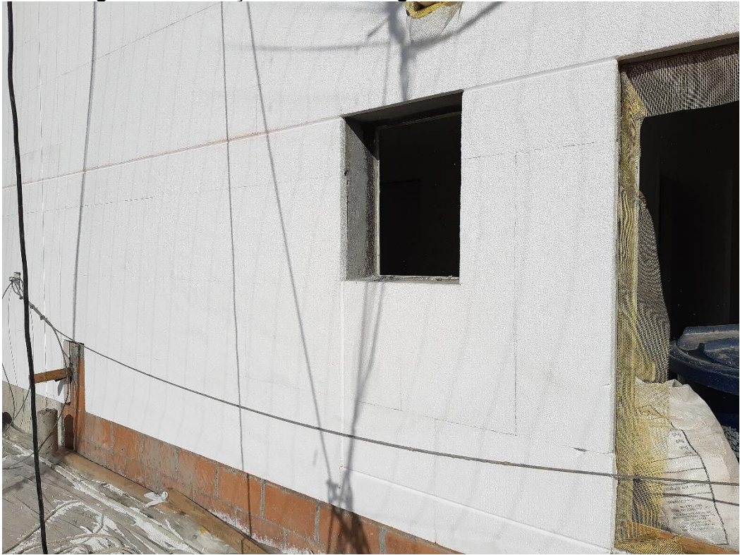
Figura 23 - Execução do EIFS no segundo estudo de caso
