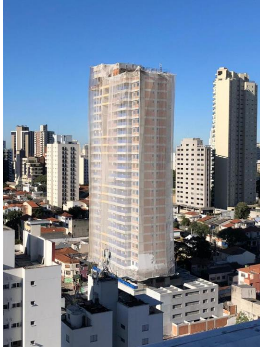
Figura 18 – Execução do EIFS no primeiro estudo de caso
