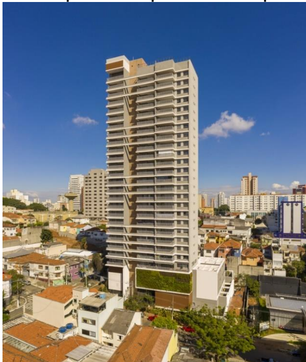
Figura 8 – Imagem da fachada pronta do empreendimento do primeiro estudo de caso
