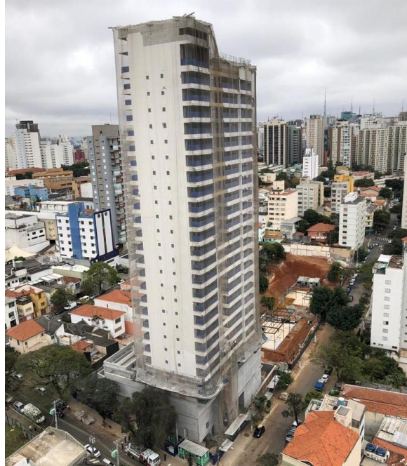
Figura 20– Execução do EIFS no primeiro estudo de caso
