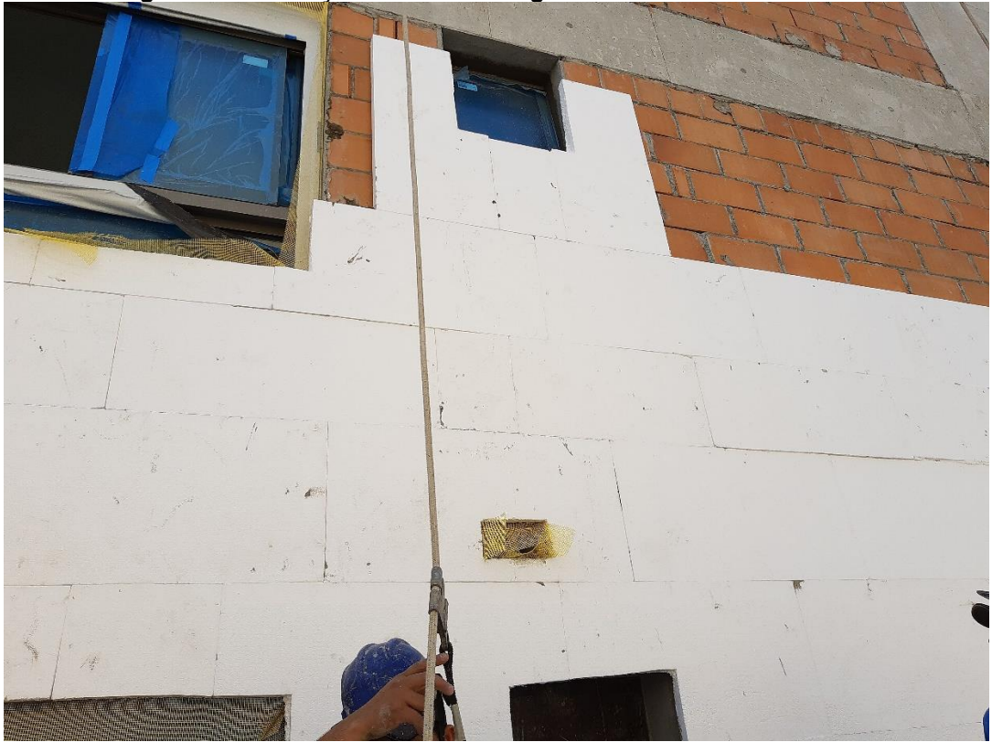
Figura 21 - Execução do EIFS no segundo estudo de caso
