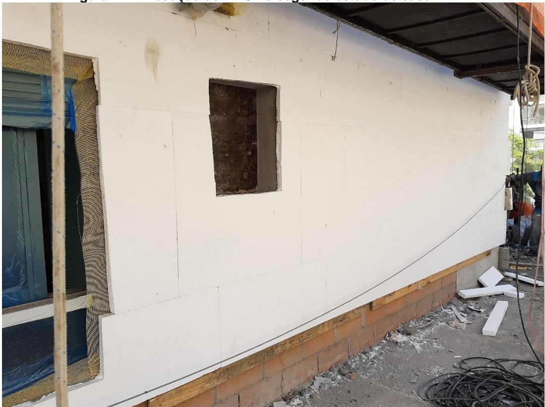
Figura 22 - Execução do EIFS no segundo estudo de caso
