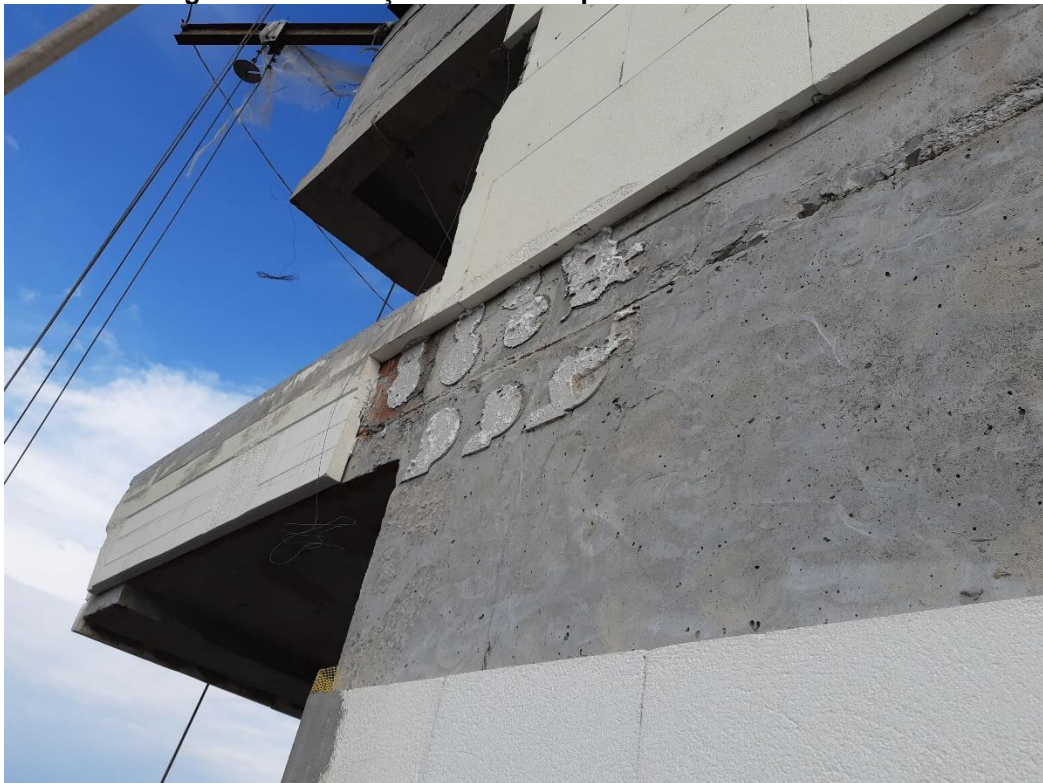
Figura 17 - Execução do EIFS no primeiro estudo de caso
