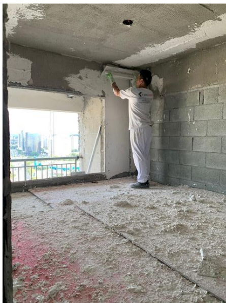
Figura 56 – Execução do revestimento no teto
