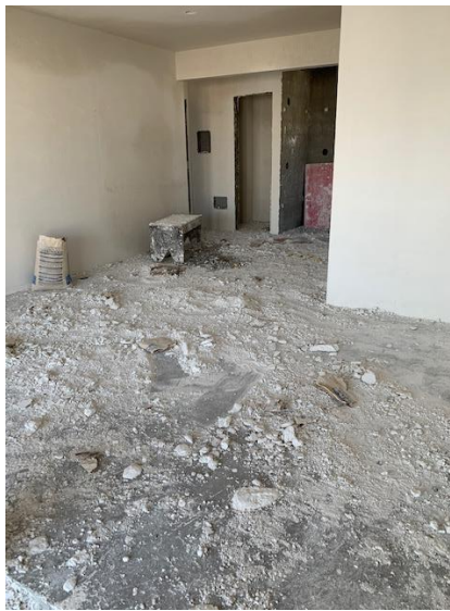
Figura 63 – Ambiente logo após a execução do revestimento de gesso por projeção manual
