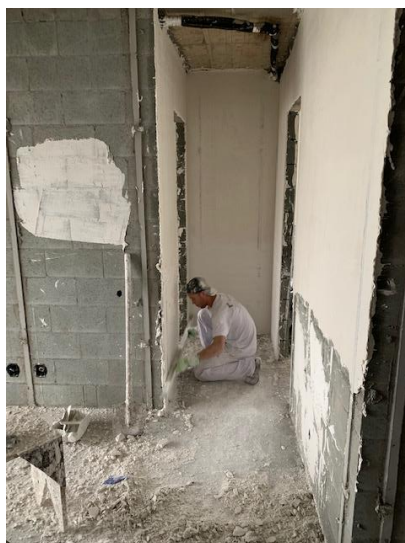
Figura 59 – Execução do revestimento na parte inferior das paredes
