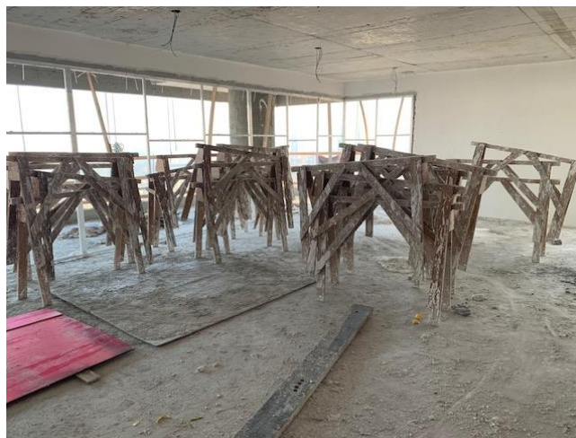
Figura 32 – Cavaletes e chapas de madeira utilizados na etapa de acabamento do revestimento
