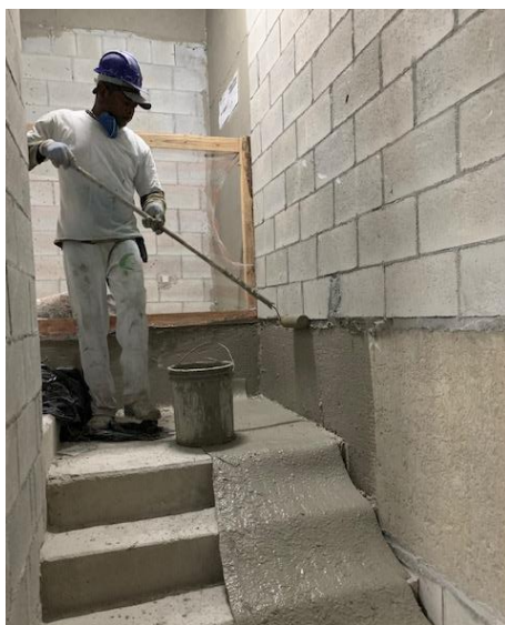
Figura 12 – Aplicação de chapisco rolado na estrutura antes de receber o revestimento em gesso projetado
