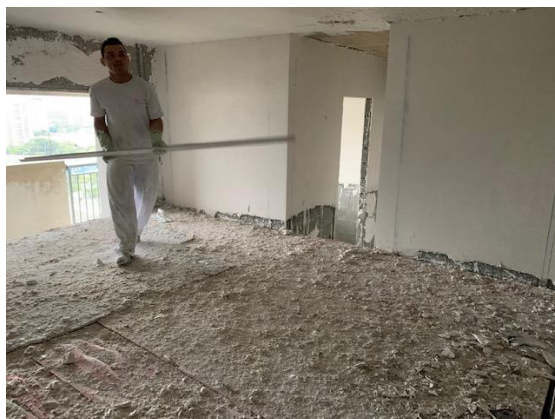
Figura 57 – Execução do revestimento na parte superior das paredes
