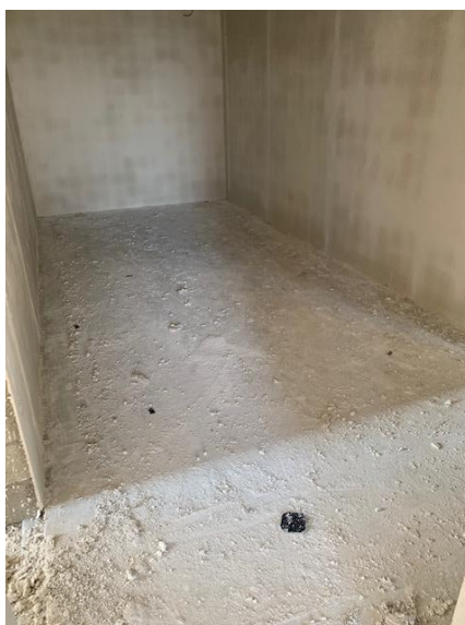
Figura 45 – Ambiente logo após a execução do revestimento e retirada do andaime
