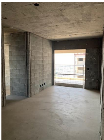
Figura 53 – Taliscas e mestras são feitas por pedreiros e o chapisco rolado por ajudante, anteriormente ao início do revestimento em gesso
