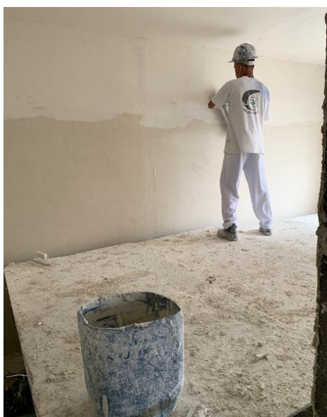
Figura 21 – Etapa de pré-acabamento da argamassa de gesso
