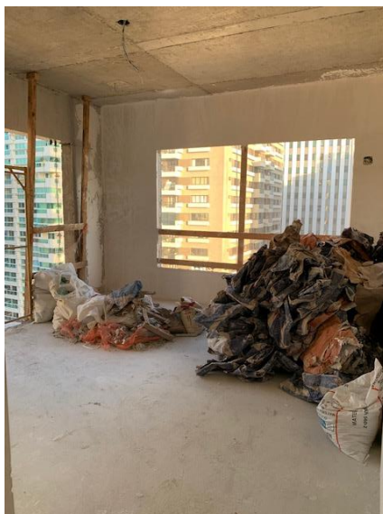
Figura 44 – Entulho e sacos de gesso armazenados próximo à cremalheira para serem descartados
