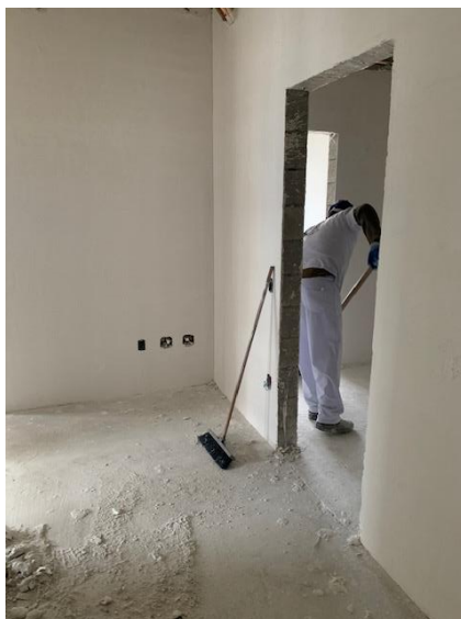
Figura 42 – Ajudante limpando o pavimento após a execução do revestimento
