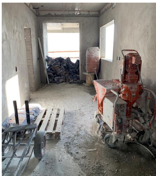
Figura 9 – Abastecimento de água para o equipamento de projeção de argamassa de gesso
