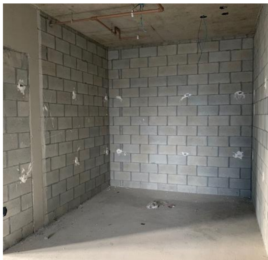
Figura 13 – Taliscas para a execução do revestimento em gesso projetado
