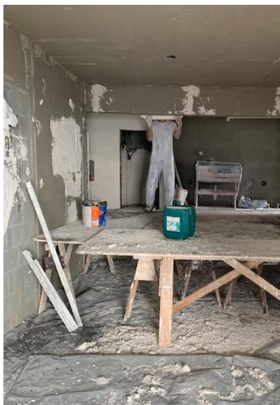
Figura 52 – Cavaletes e chapas de madeira utilizados durante a execução do revestimento
