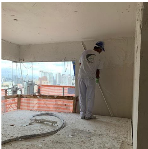
Figura 20 – Sarrafeamento da parte superior da parede
