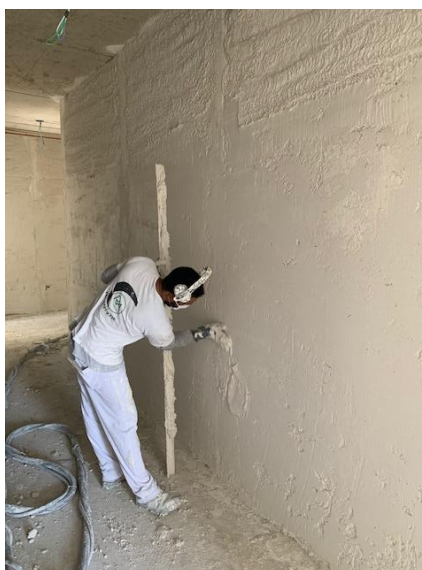
Figura 38 – Sarrafeamento do gesso recém jateado
