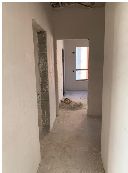
Figura 43 – Limpeza do pavimento após a execução do revestimento
