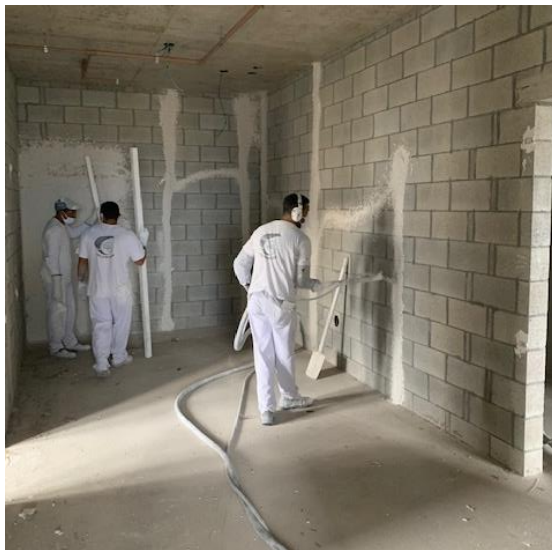
Figura 14 – Mestras para a execução do revestimento em gesso projetado
