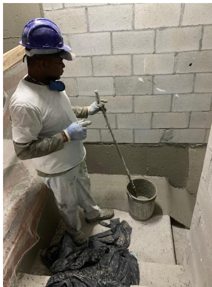
Figura 35 – Ajudante aplicando chapisco rolado nos elementos estruturais
