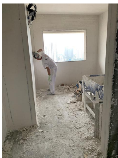
Figura 60 – Acabamento do revestimento
