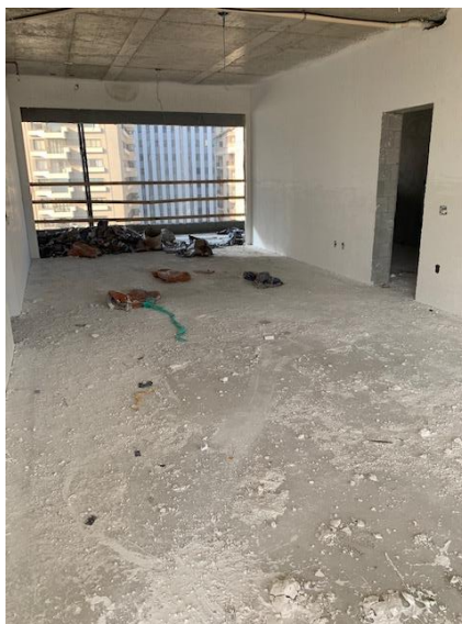
Figura 46 – Ambiente logo após a execução do revestimento e retirada do andaime
