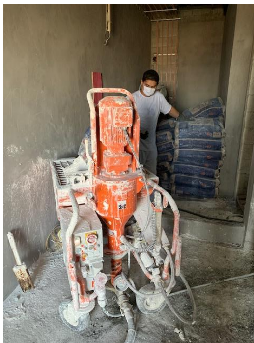
Figura 18 – Abastecimento do equipamento de projeção
