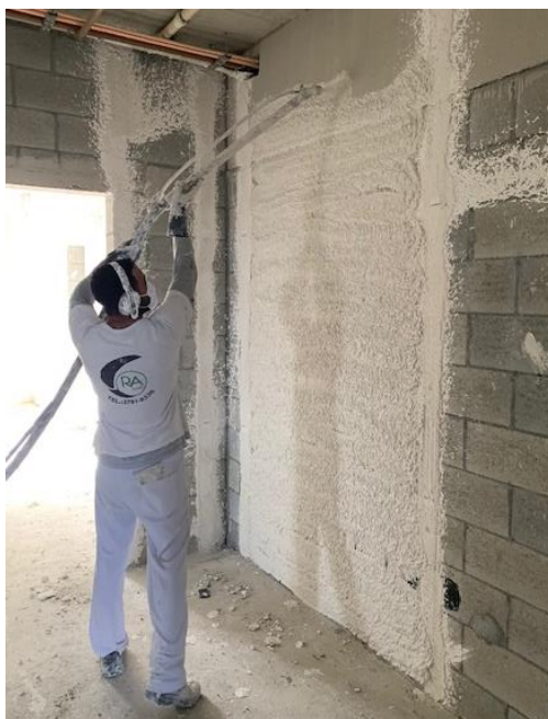
Figura 16 – Projeção da argamassa de gesso na parte superior da parede
