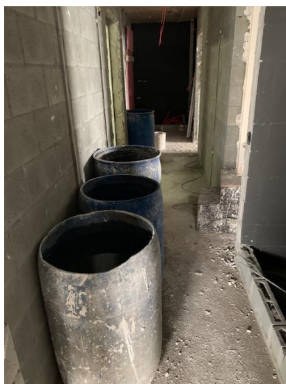
Figura 51 – Tambores com água para utilização no revestimento de gesso
