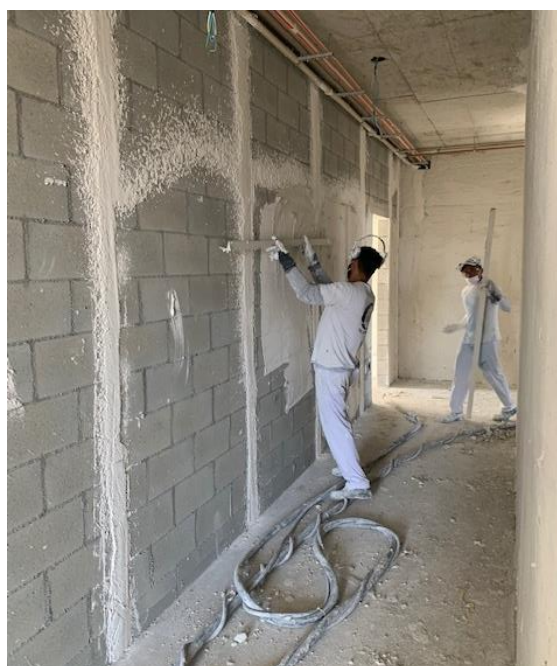
Figura 15 – Acerto das mestras para a execução do revestimento em gesso projetado
