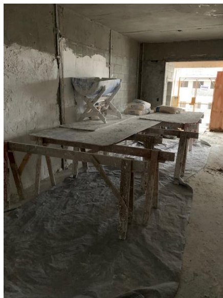
Figura 55 – Preparação para início do serviço
