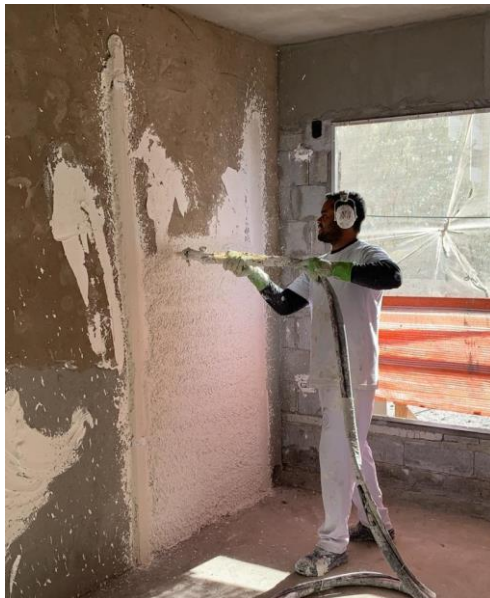
Figura 17 – Projeção da argamassa de gesso de baixo para cima
