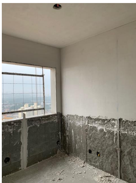
Figura 58 – Retirada do andaime para a execução do revestimento na parte inferior das paredes
