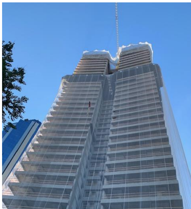
Figura 27 – Fachada da Obra 1 (Canvas High Houses)
