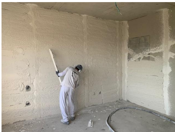
Figura 19 – Etapa de sarrafeamento da argamassa de gesso
