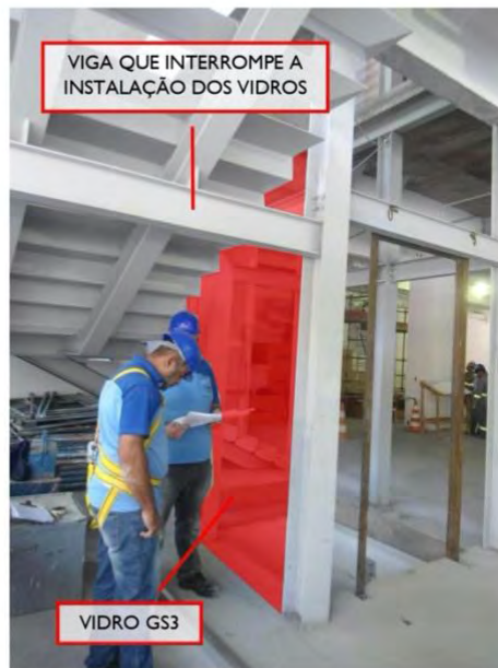
VISTA LATERAL ELEVADOR
