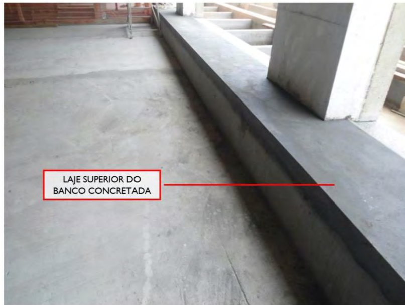
BANCO NA FACHADA DO RESTAURANTE (SALÃO MULTIUSO 2)
