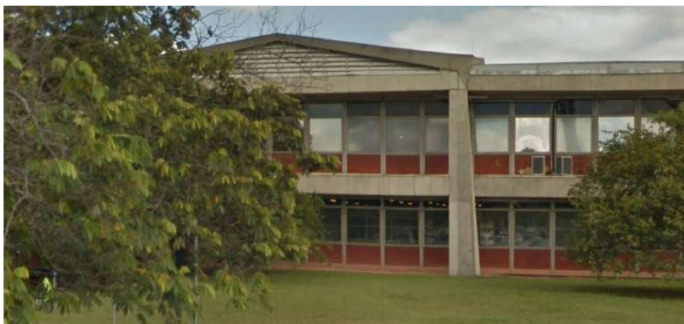
Figura 23 – Fotografia da vista externa do edifício da Faculdade de Engenharia Civil da Escola Politécnica da USP
