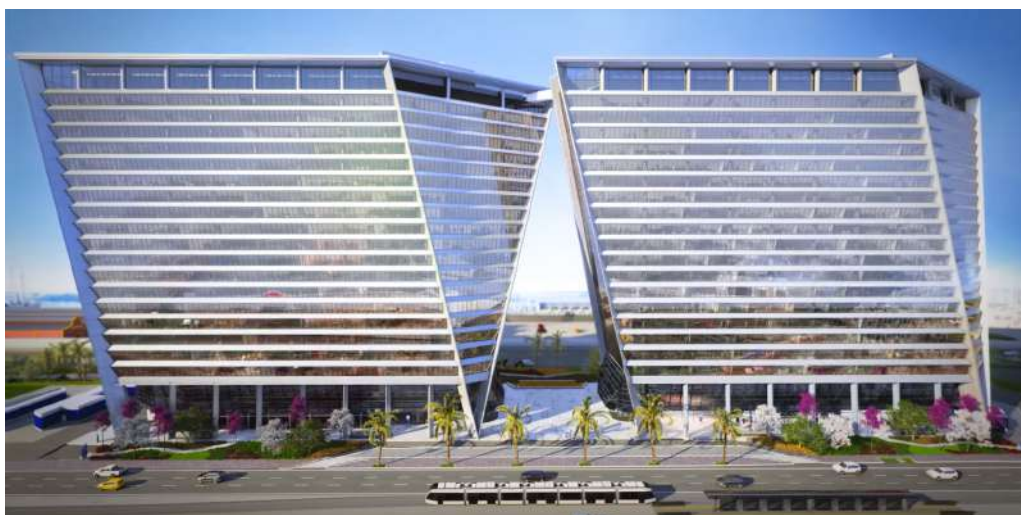
Figura 9 - Empreendimento AQWA Corporate da Tishman Speyer, localizado na região do Porto Maravilha no Rio de Janeiro, cuja execução da estrutura metálica foi controlada com escaneamento a laser
