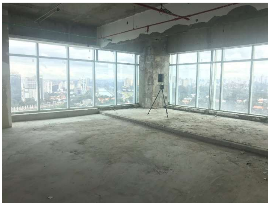
Figura 15 - Posicionamento inicial do equipamento para o início do escaneamento
