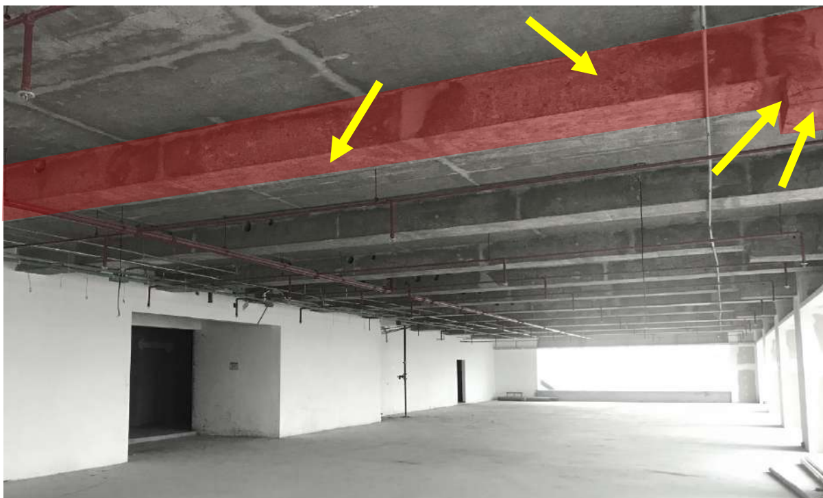
Figura 10 - Exemplo de superfícies de elemento estrutural a serem capturadas
