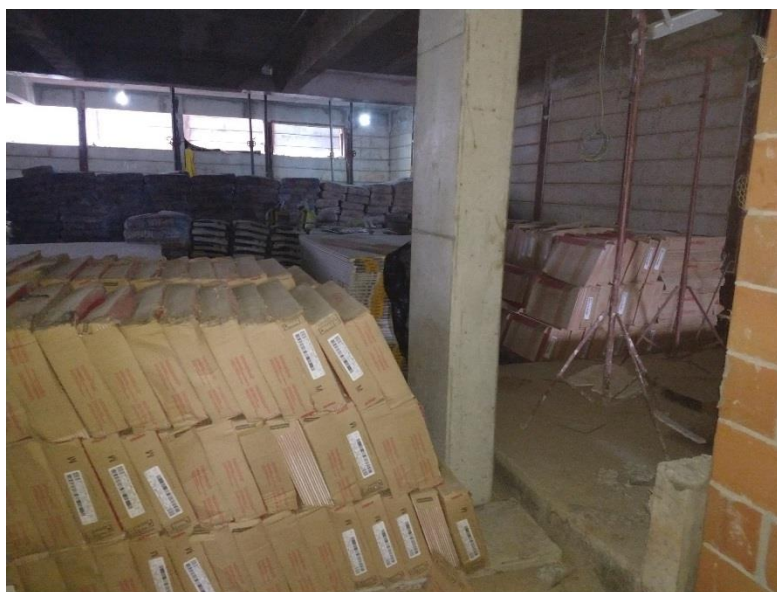
Figura 30 - Armazenamento de cimento e azulejo no 1º subsolo
