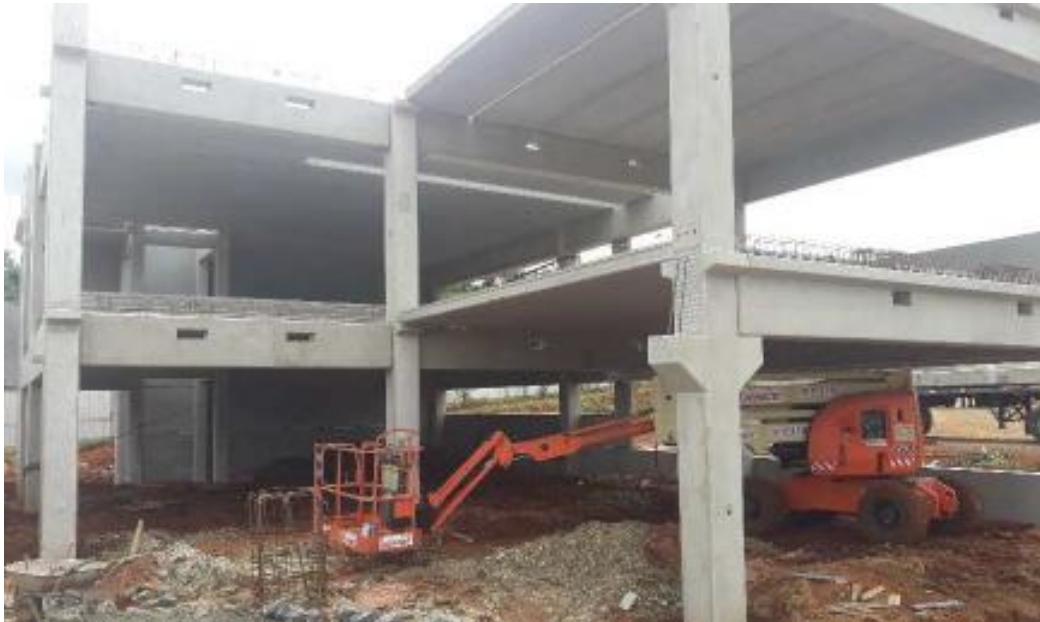
FIGURA 33: Foto obra em abril de 2019
