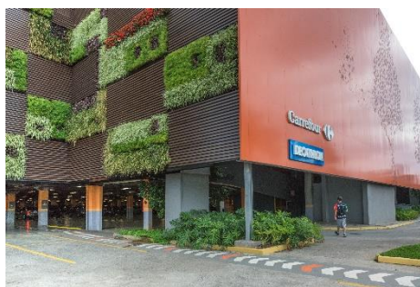
Figura 32. Fachada Carrefour Vila Leopoldina
