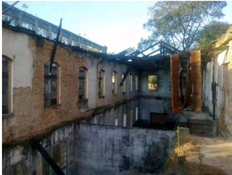
Figura 57 - Foto da área antes da obra
