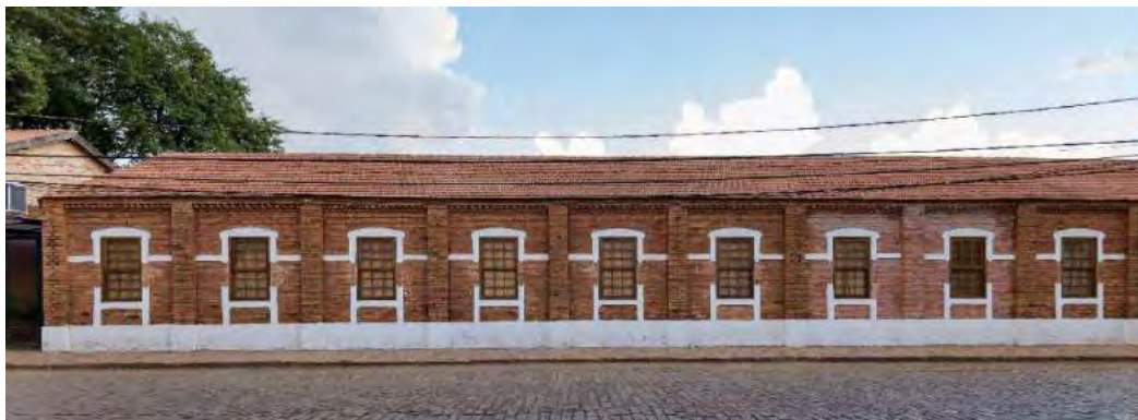
Figura 46 - Fachada externa da antiga carpintaria restaurada
