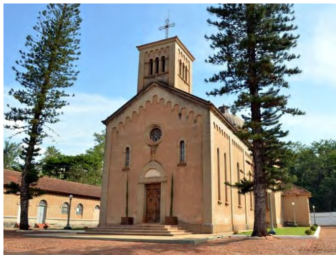
Figura 31 - Foto da capela depois de restaurada
