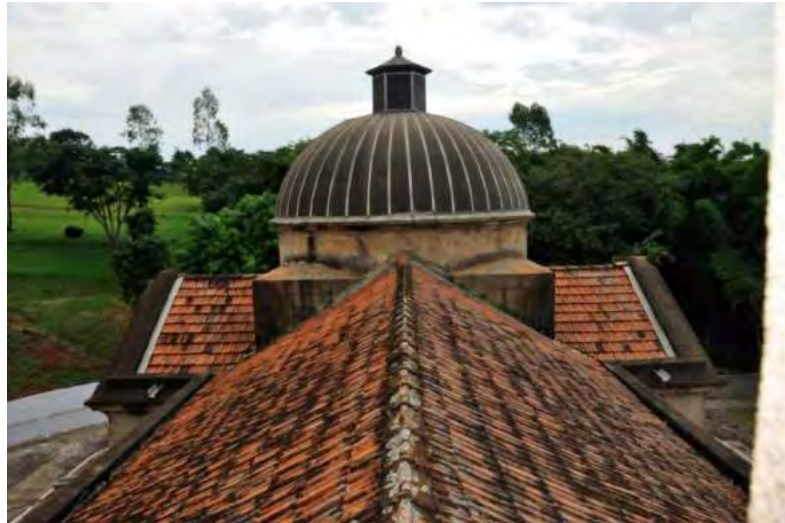
Figura 52 - Vista de cima do telhado da capela
