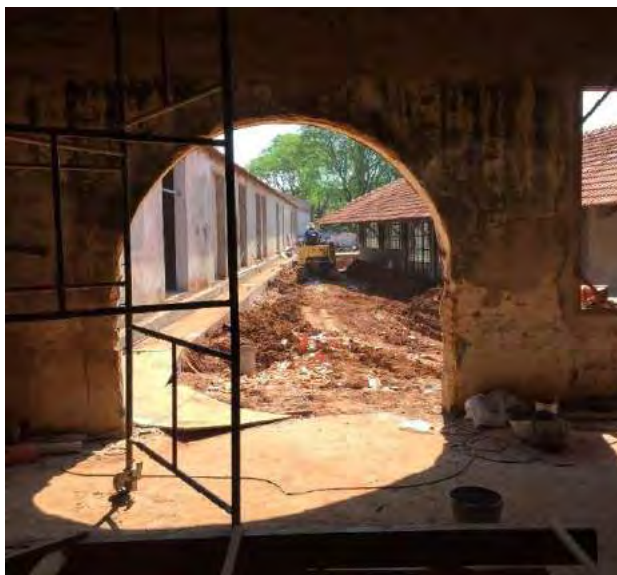
Figura 45 - Obras no edifício que abrigava o grupo musical
