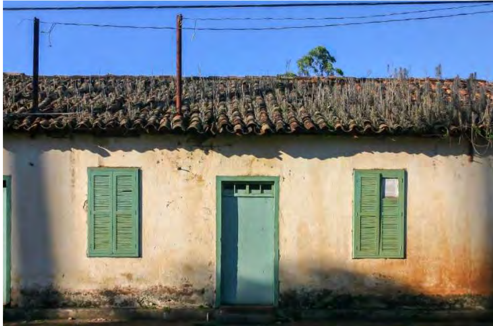
Figura 11 - Fachada de residência da Vila Heloísa II
