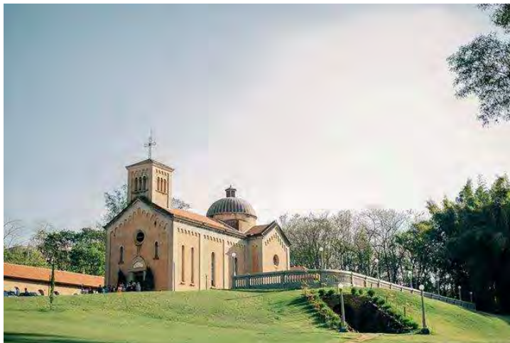
Figura 53 - Capela de São Pedro com o telhado já recuperado
