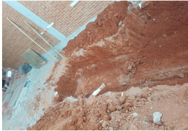
Figura 25 - Envelopamento das instalações elétricas.
