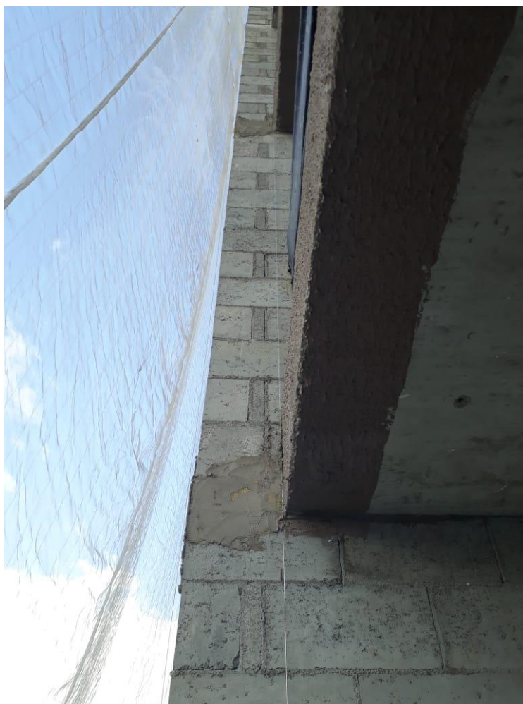
Figura 15 – Recuo dos arames para execução do plano de revestimento da fachada.
