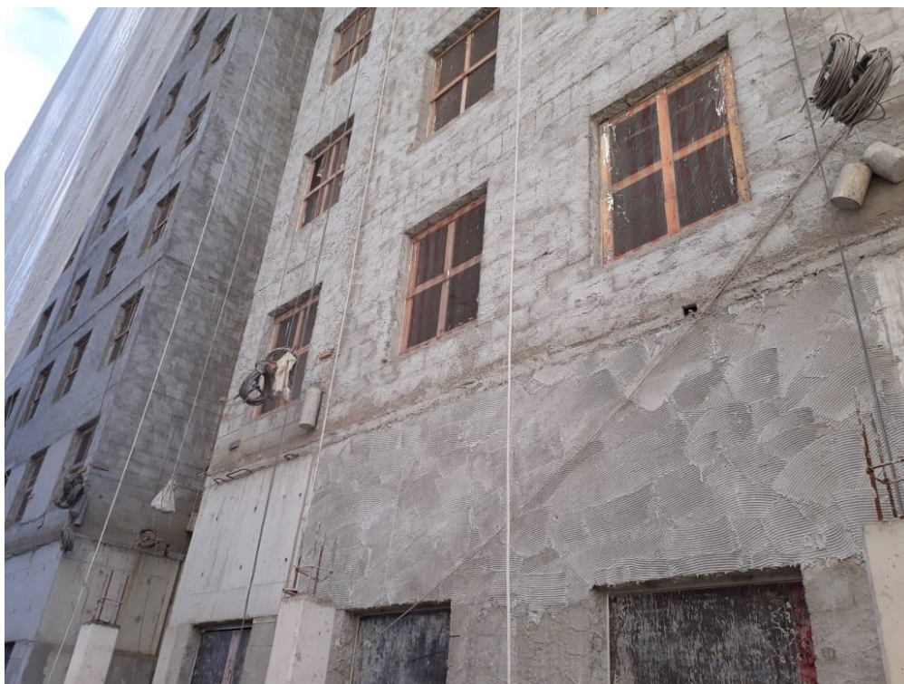
Figura 16 – Chapisco utilizado na preparação da base na empresa 'A'.
