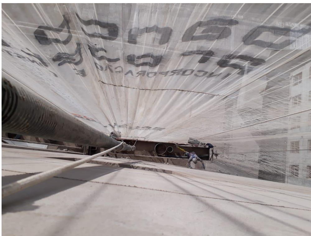
Figura 191 – Transporte da argamassa por funil ao balancim.
