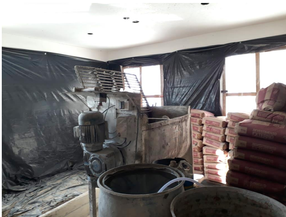
Figura 19 – Produção da argamassa industrializada.
