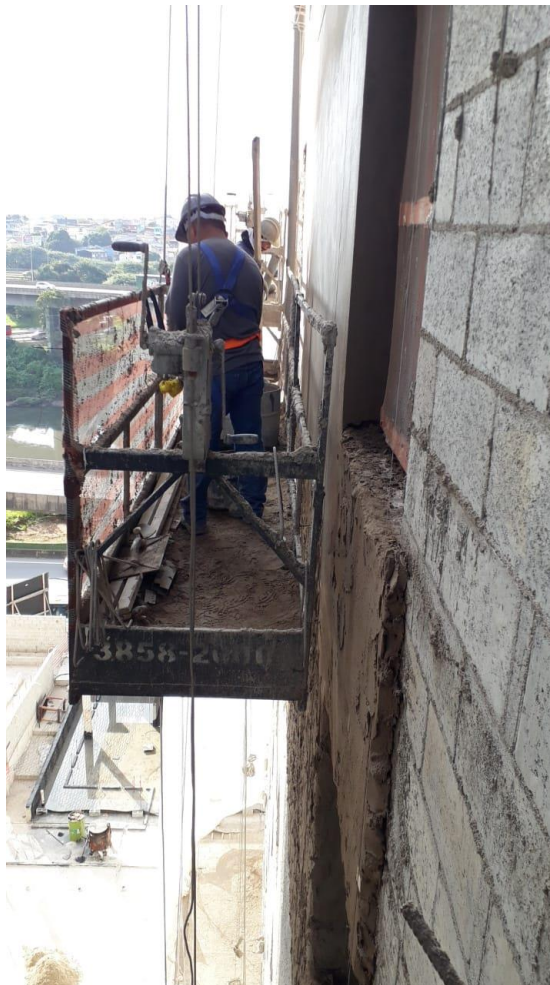
Figura 20 – Aplicação e acabamento da argamassa.
