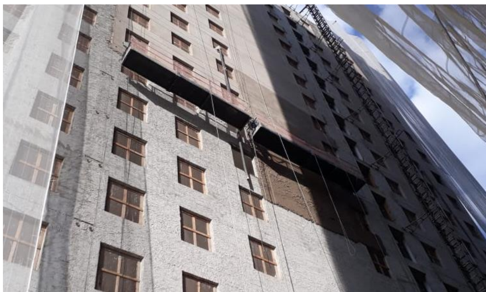
Figura 20 – Execução da camada de revestimento argamassa.
