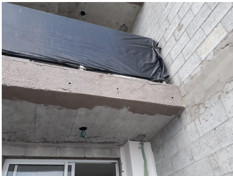
Figura 17 – Chapisco utilizado na preparação da base na empresa 'B'.
