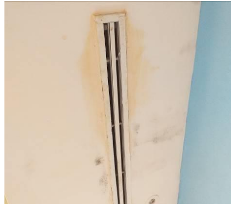
Figura 19. Manchas no forro na região dos difusores de ar condicionado
