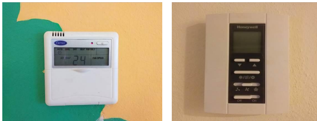
Figura 18. Controladores Carrier e Honeywell e chillers York
