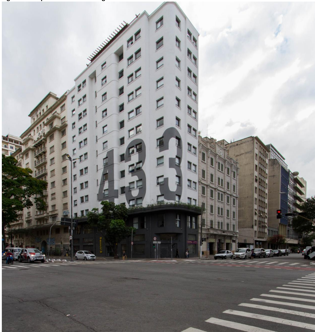
Figura 45: Empreendimento Uliving 433 – fachada edifício
