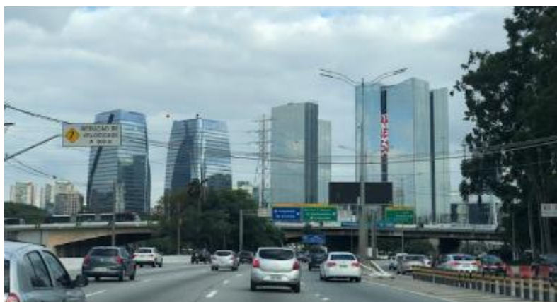
Figura 6 - Exemplo de edifícios corporativos na cidade de São Paulo com fachadas do tipo curtain-wall
