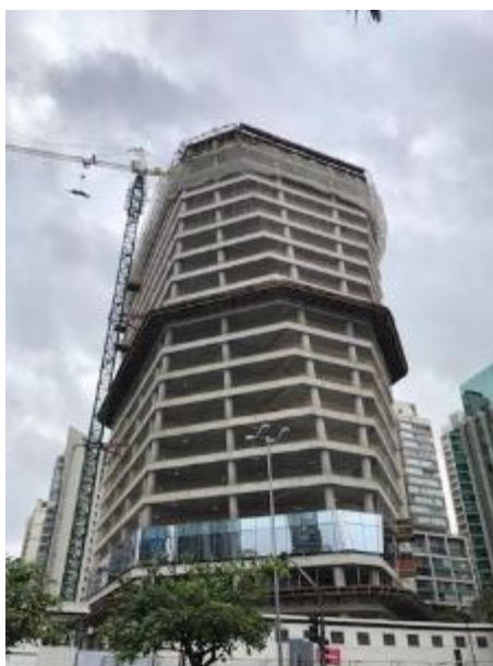
Figura 8 – Edifício corporativo em construção com fachada em sistema unitizado
