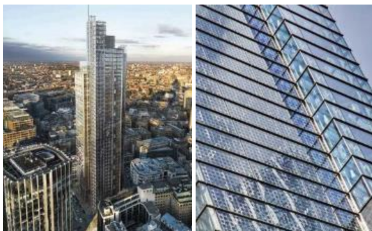
Quadro 8 - Exemplo de aplicação de BIPV em Londres – Reino Unido
