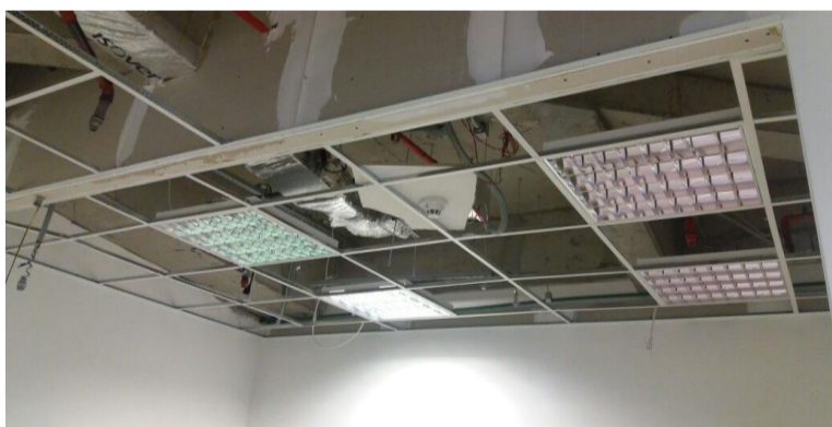
INSTALAÇÃO LUMINÁRIAS / LAMPS INSTALLATION
