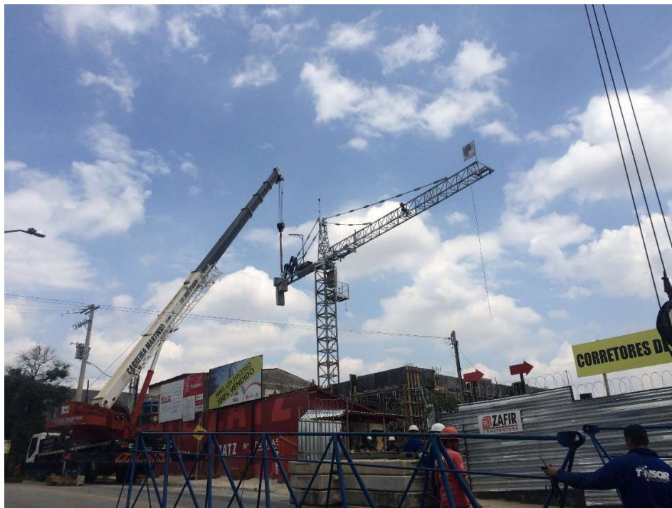
Figura 25 – Instalação da grua ascencional
