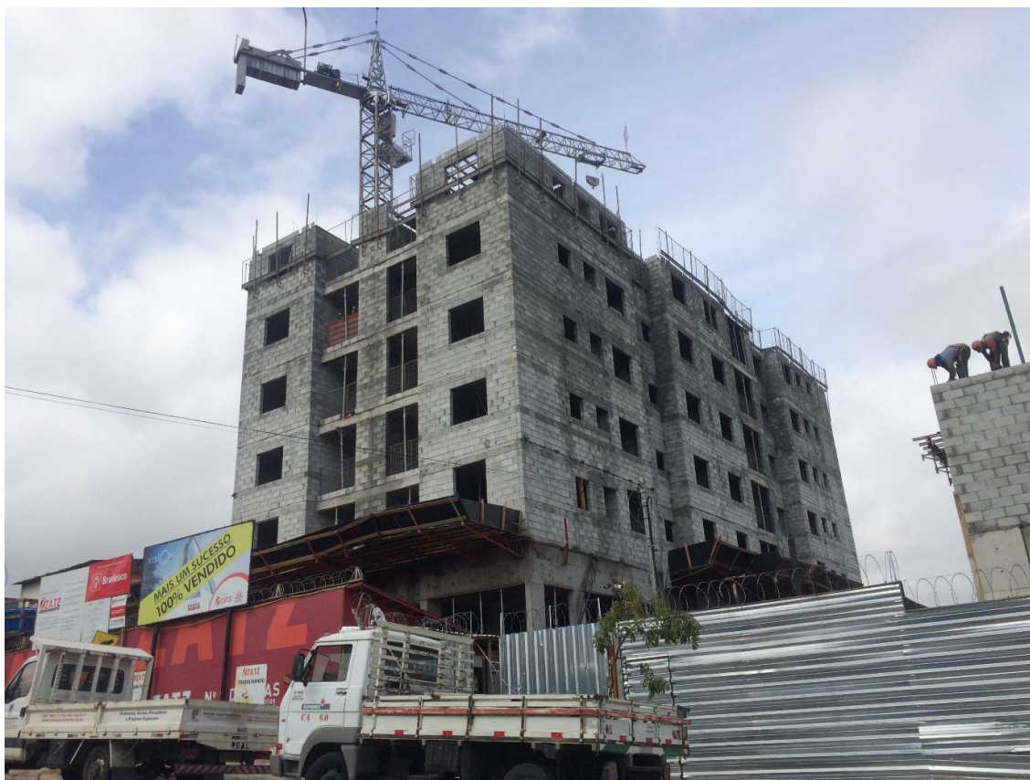
Figura 27 – Grua ascensional em operação
