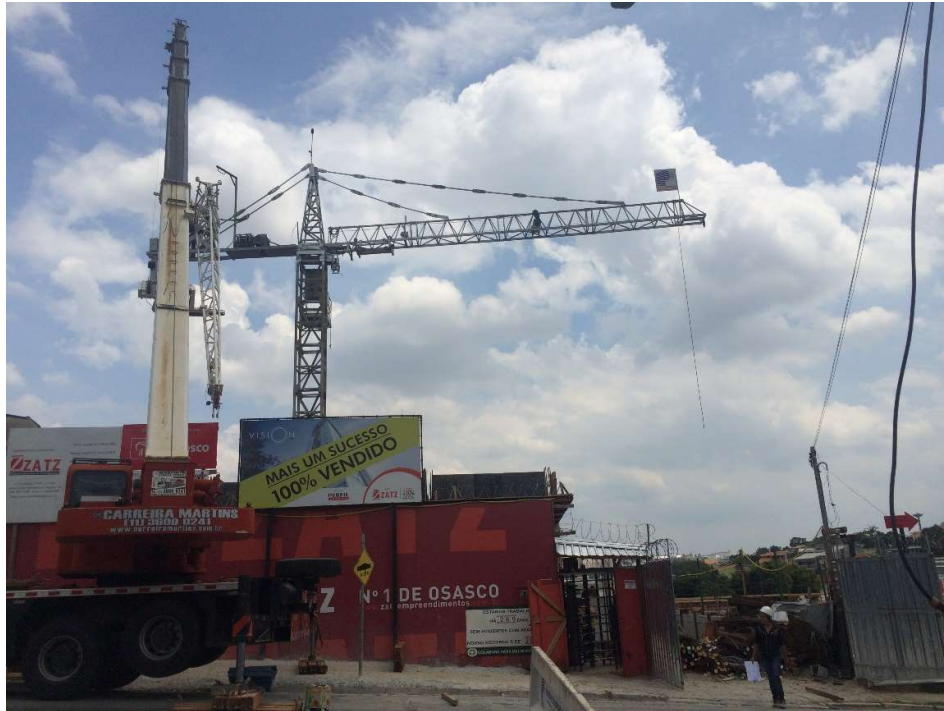
Figura 24 – Instalação da grua ascencional
