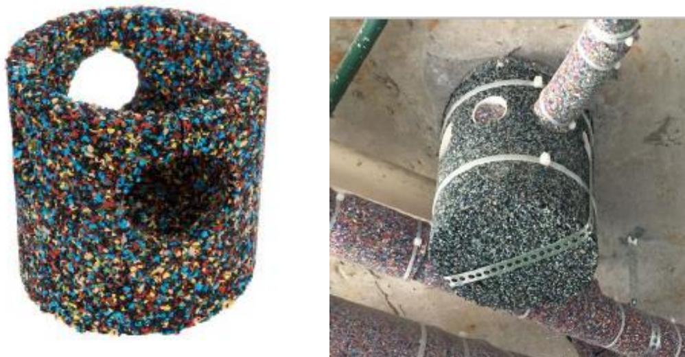
Figura 49 - Proteção acústica de ralos sifonados (material 3)
