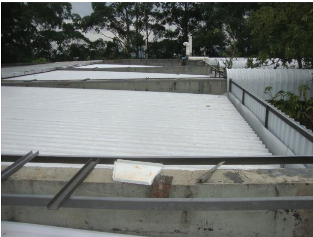
Figura 67 - Bloco da Engenharia Química sendo instalado o telhado
