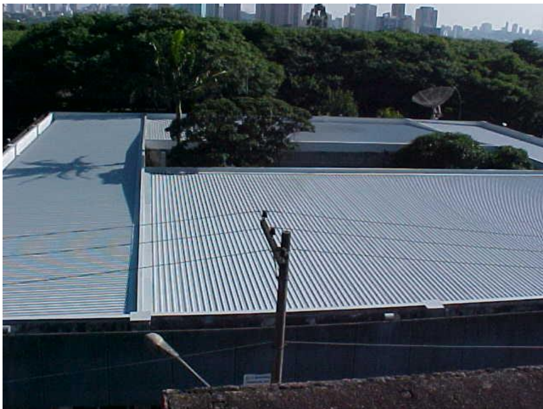
Figura 34 - Vista geral do telhado no Bloco A da ECA (Fonte: SEF)
