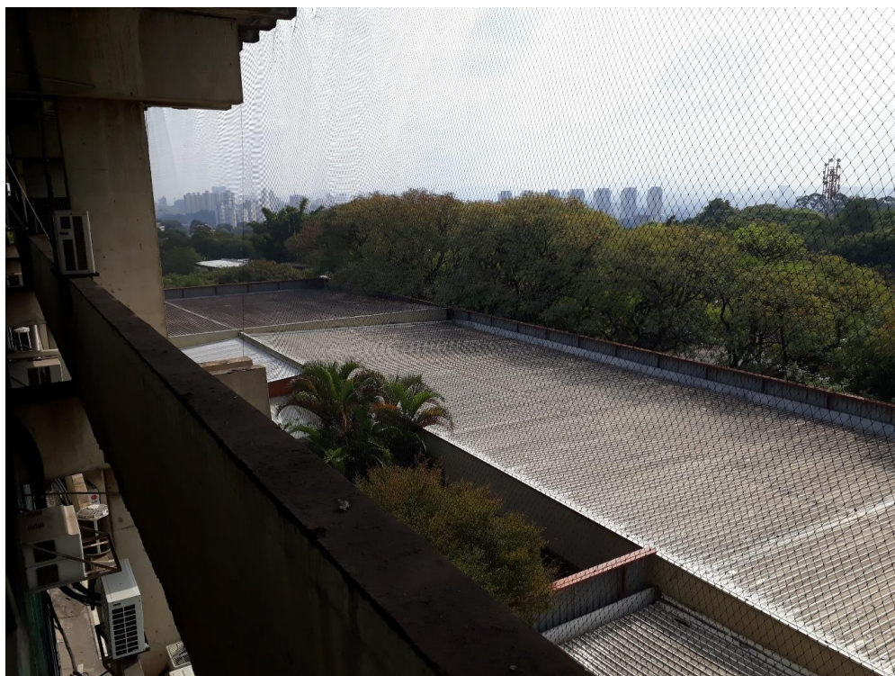
Figura 7 - Telhado sobre laje de terraço (Fonte: SEF)
