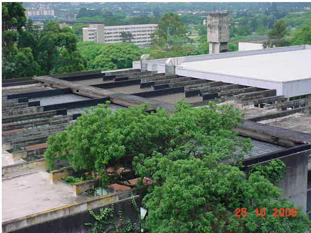
Figura 17 - Vista à direita do telhado sobre o Centro de Vivência do Conjunto das Químicas (Fonte: SEF)
