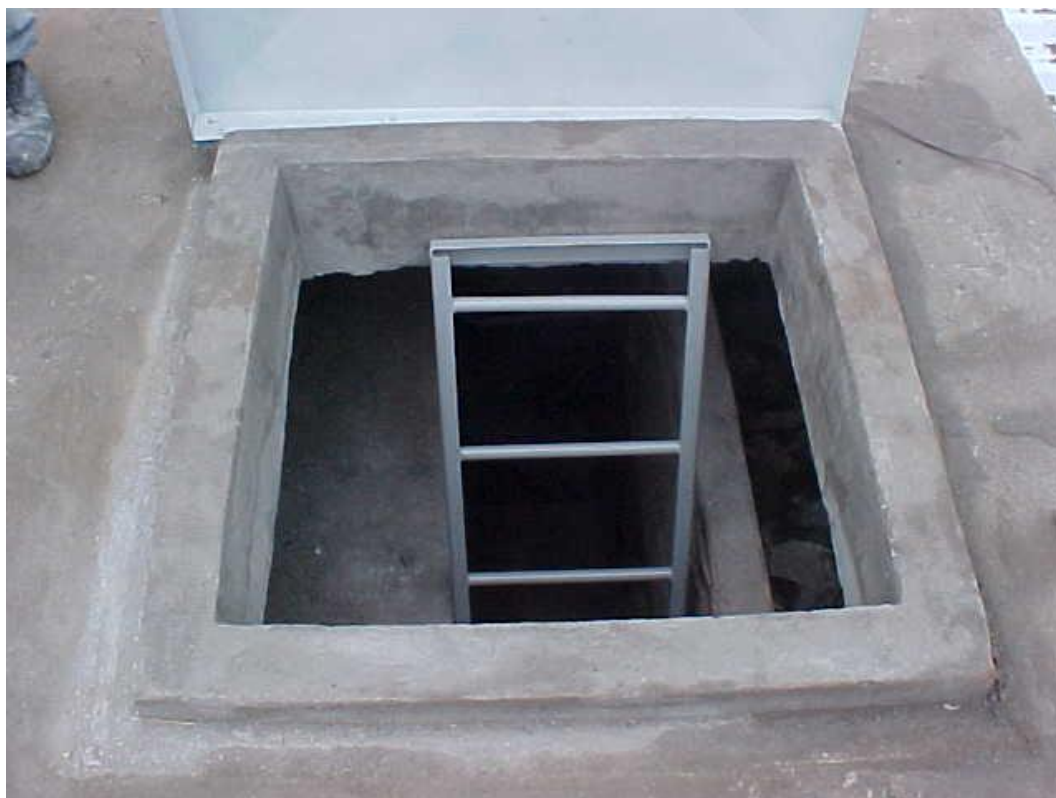
Figura 68 - Alçapão e escada marinheiro na laje de cobertura do “shaft” nos Blocos do Conjunto das Químicas (Fonte: SEF)
