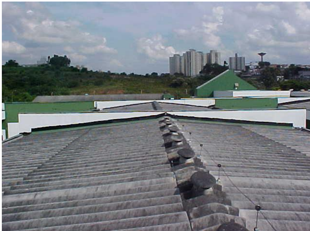
Figura 23 - Telhado com cumeeira ventilada e os arremates em chapa metálica da F.M.V.Z. (Fonte: SEF)
