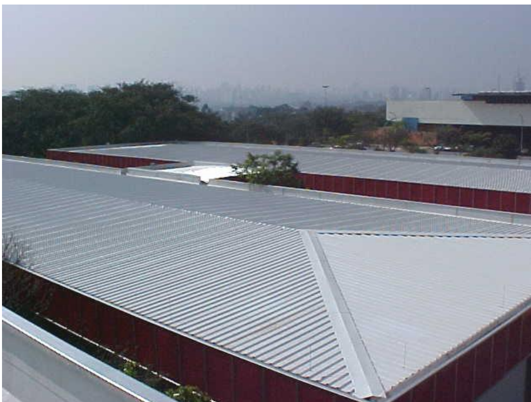
Figura 46 - Vista geral do telhado instalado nos Blocos do departamento de Ciências Sociais da FFLCH (Fonte: SEF)
