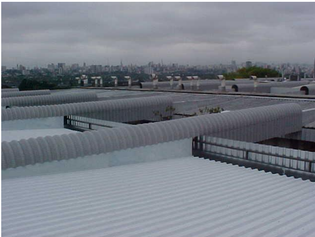
Figura 61 - Vista geral da cobertura dos Blocos 13, 15 e 17 da F.C.F. (Fonte: SEF)
