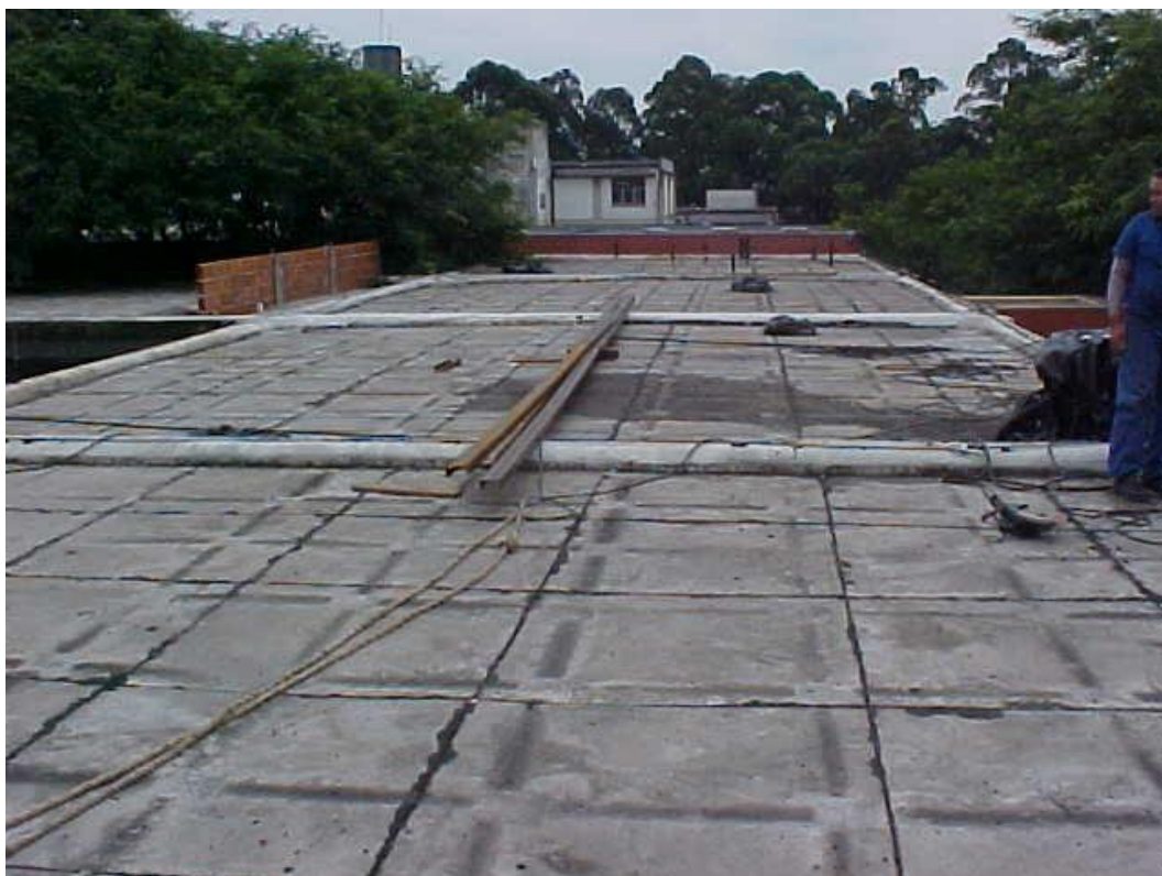
Figura 40 - Laje de cobertura sem as placas de sombreamento e pronta para receber o telhado dos Blocos do Departamento de Ciências Sociais da FFLCH (Fonte: SEF)
