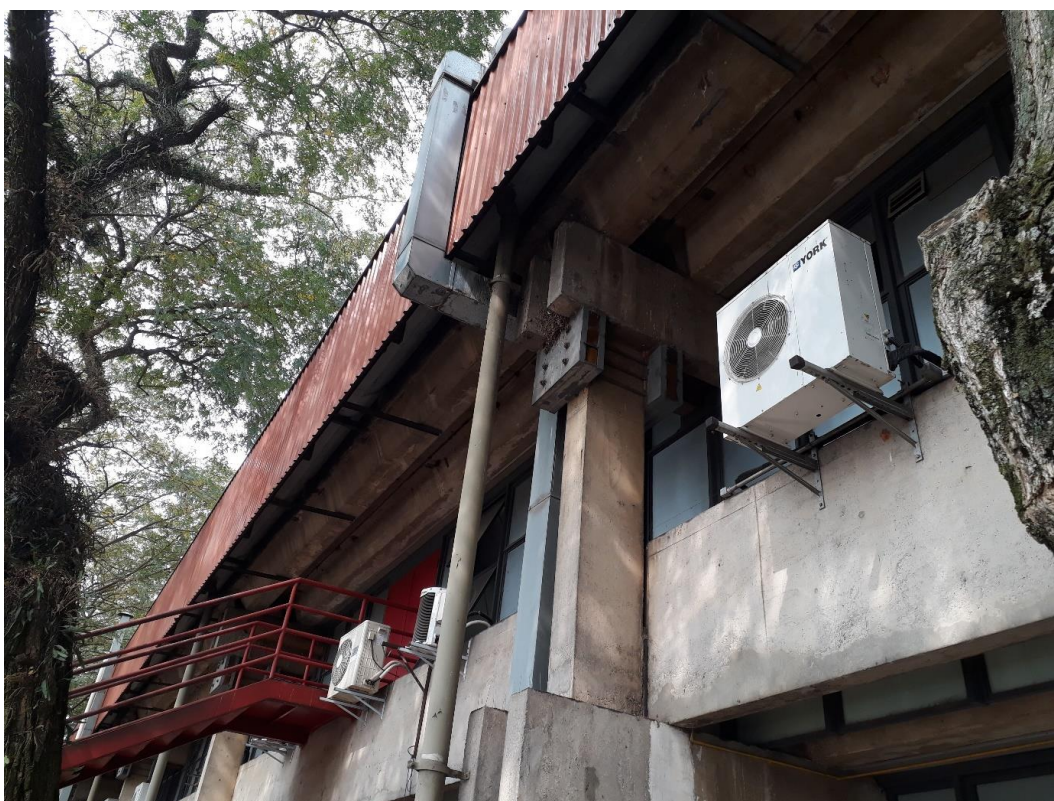
Figura 12 - A platibanda e sua estrutura apoiada nas vigas-calhas existente e as descidas de A.P. fixadas na estrutura de concreto (Fonte: SEF)
