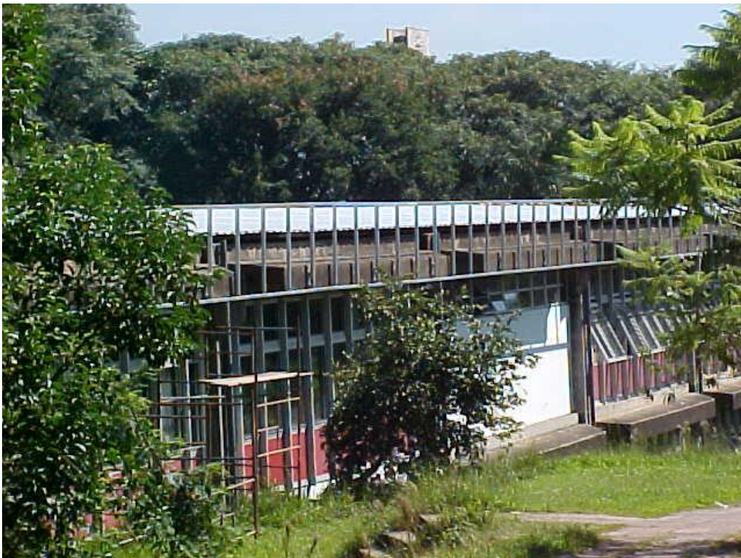
Figura 43 - Platibandas sendo instaladas nos Blocos do Departamento de Ciências Sociais da FFLCH (Fonte: SEF)
