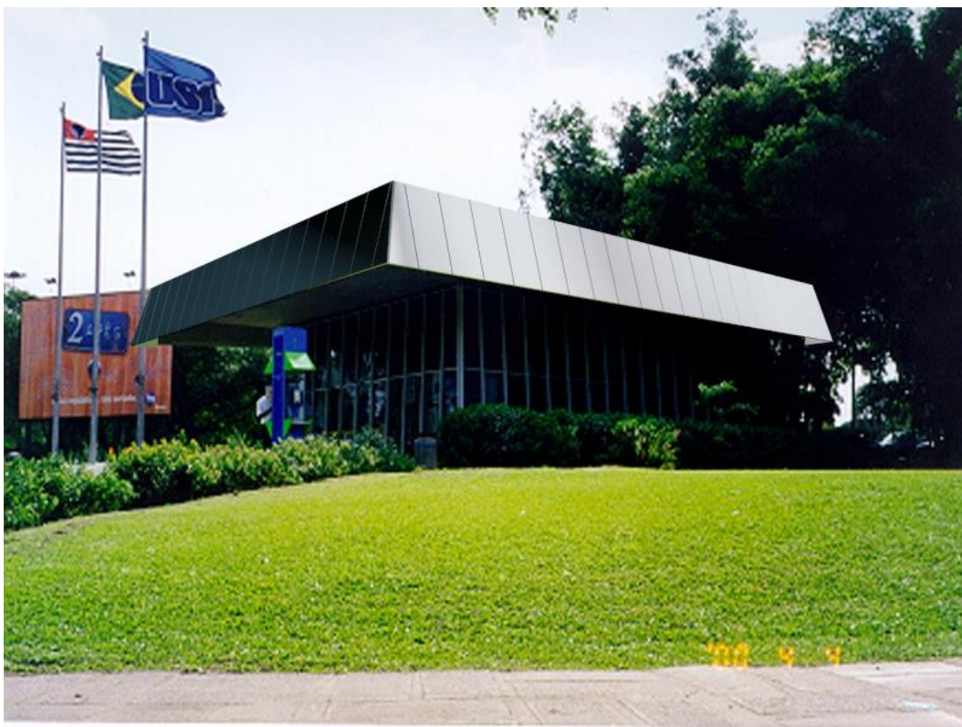
Figura 28 - Vista do Centro de Informações com a platibanda em chapas de alumínio (Fonte: SEF)
