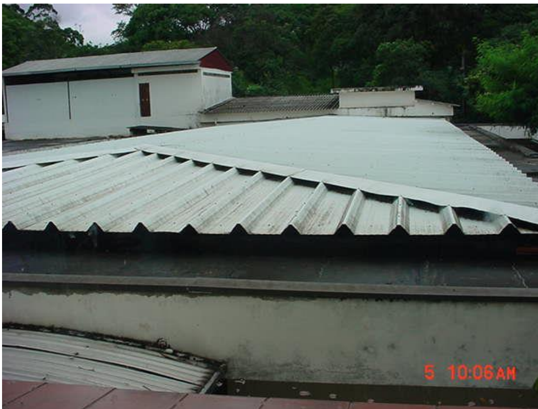
Figura 39 - Vista do telhado em três águas no Bloco B do Conjunto Alessandro Volta do IF (Fonte: SEF)
