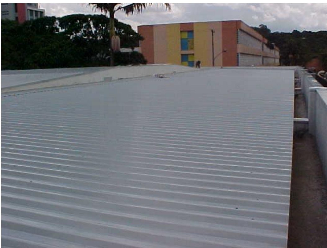
Figura 31 - Telhado instalado no Bloco A da ECA (Fonte: SEF)
