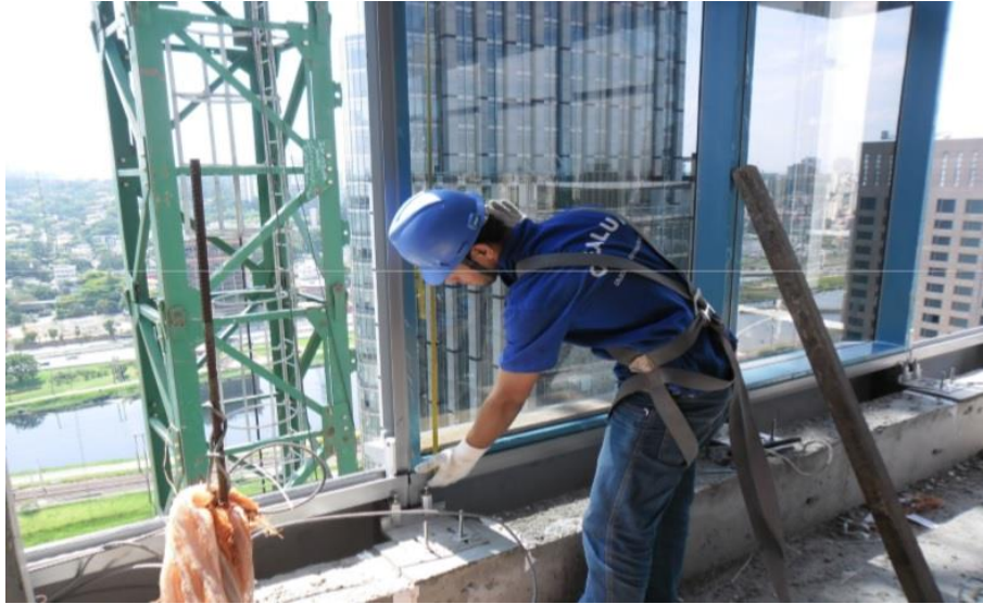
Figura 37 – Acomodação do módulo no andar inferior
