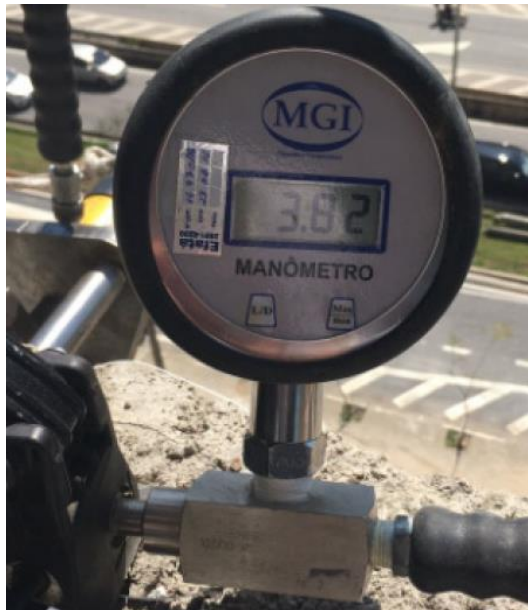
Figura 14 – Ensaio de arrancamento dos chumbadores
