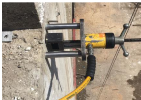
Figura 13 – Ensaio de arrancamento dos chumbadores
