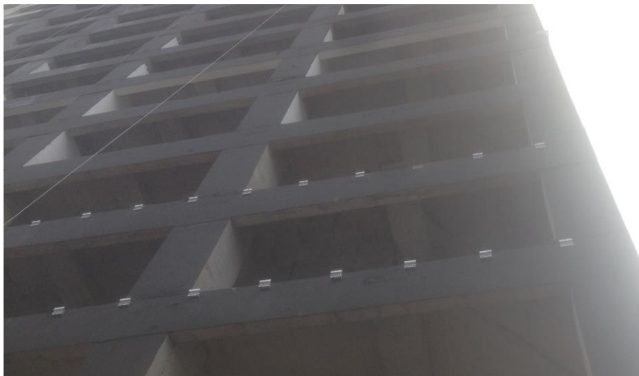
Figura 27 – Início da locação das ancoragens
