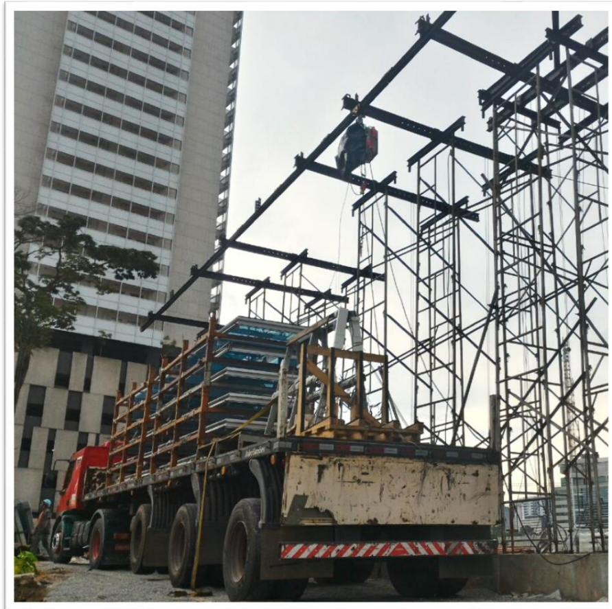
Figura 16 – Ponte rolante descarregando os caminhões com os módulos
