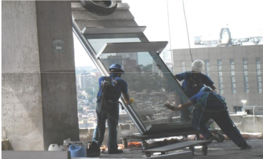
Figura 35 – Saída do módulo para instalação na fachada
