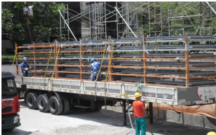
Figura 28 – Recebimento de carga paletizada em obra
