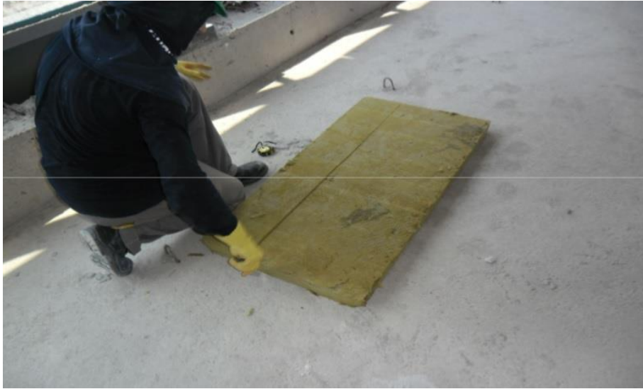
Figura 41 – Instalação de selo corta fogo ( fire stop )
