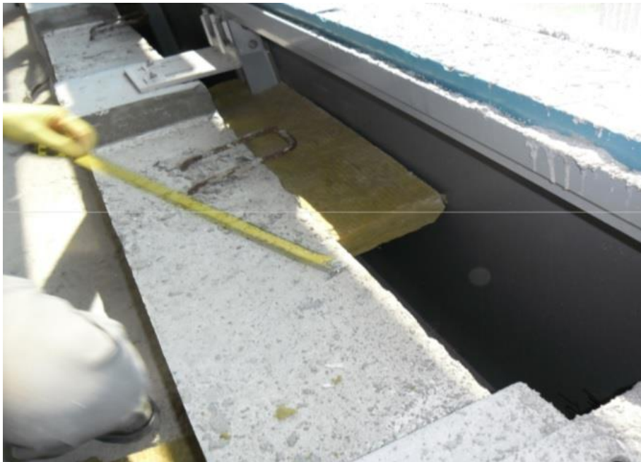
Figura 42 – Instalação de selo corta fogo ( fire stop )
