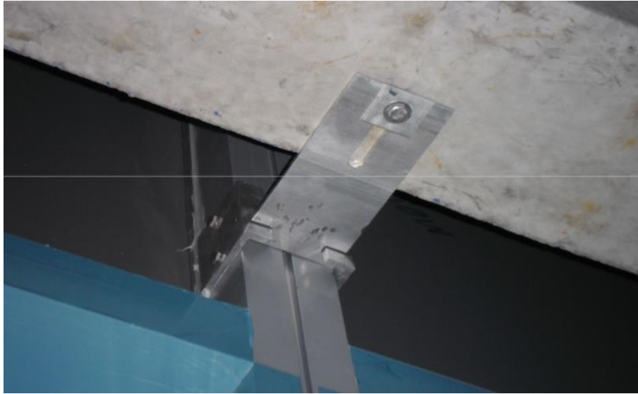
Figura 39 – Instalação de ancoragens auxiliares
