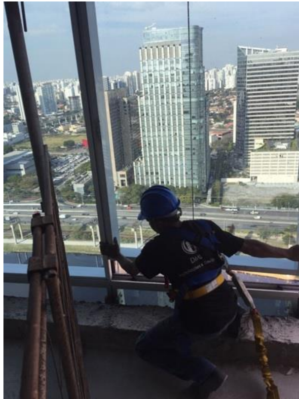
Figura 24 – Instalação dos módulos
