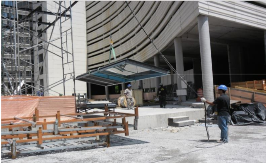
Figura 29 – Descarga dos painéis com uso de monovia
