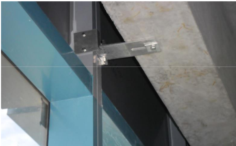
Figura 40 – Instalação de ancoragens auxiliares com vista dos filmes de proteção
