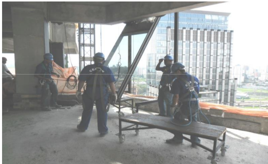
Figura 32 – Recebimento dos painéis nos andares
