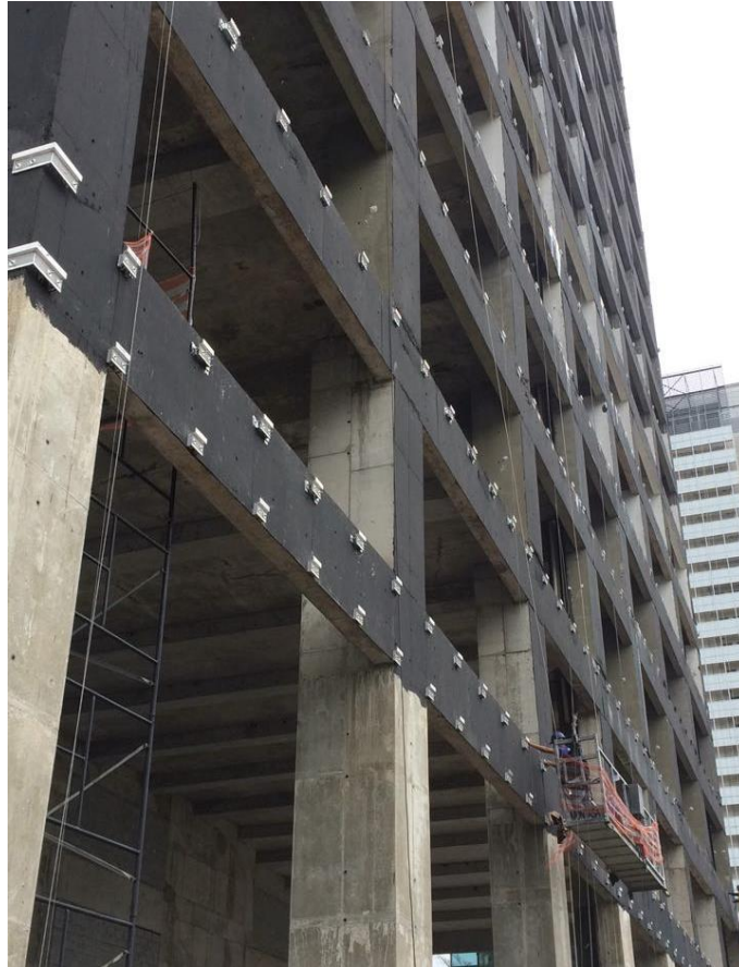
Figura 12 – Locação das ancoragens na estrutura
