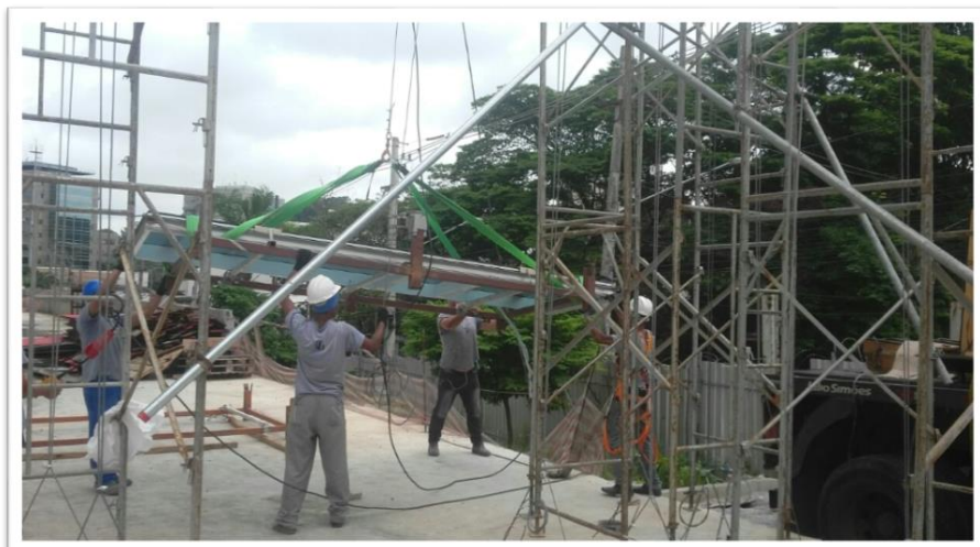
Figura 17 – Ponte rolante descarregando os módulos
