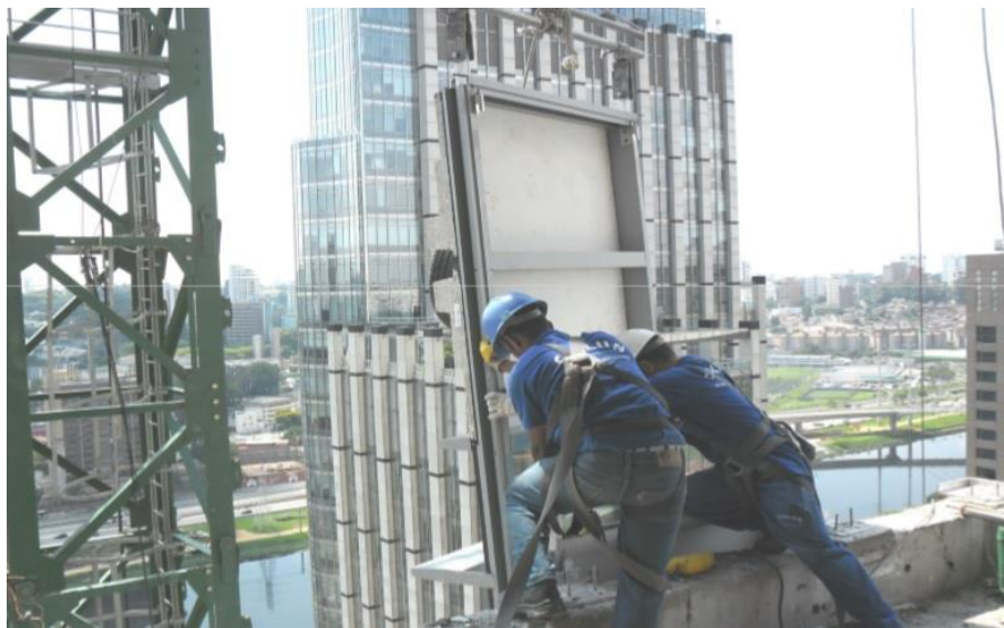
Figura 36 – Instalação do módulo
