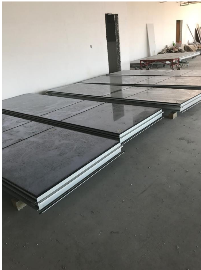
Figura 34 – Armazenamento dos painéis no pavimento
