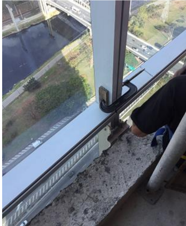
Figura 25 – Instalação dos módulos
