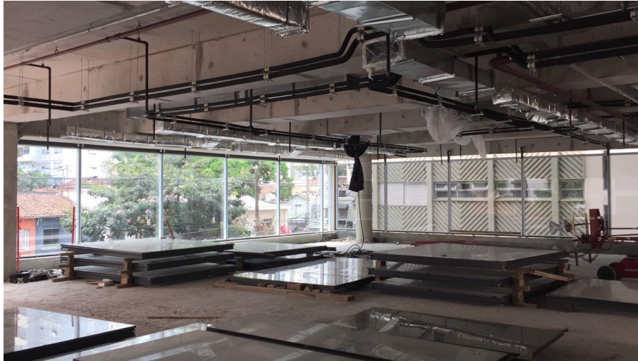
Figura 33 – Armazenamento dos painéis no pavimento
