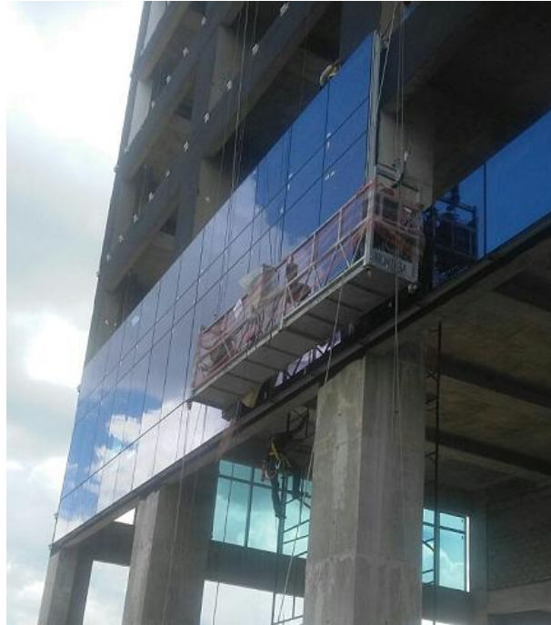
Figura 23 – Início da montagem da pele de vidro
