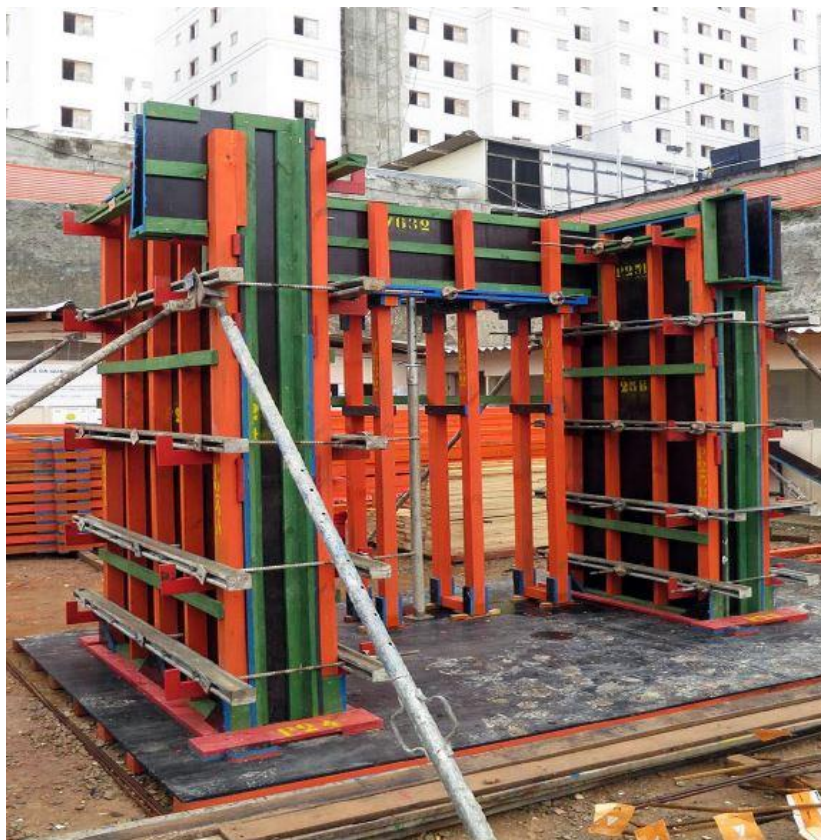
Figura 06 – Protótipo para confecção das fôrmas (Fonte: ASSAHI, 2015)
