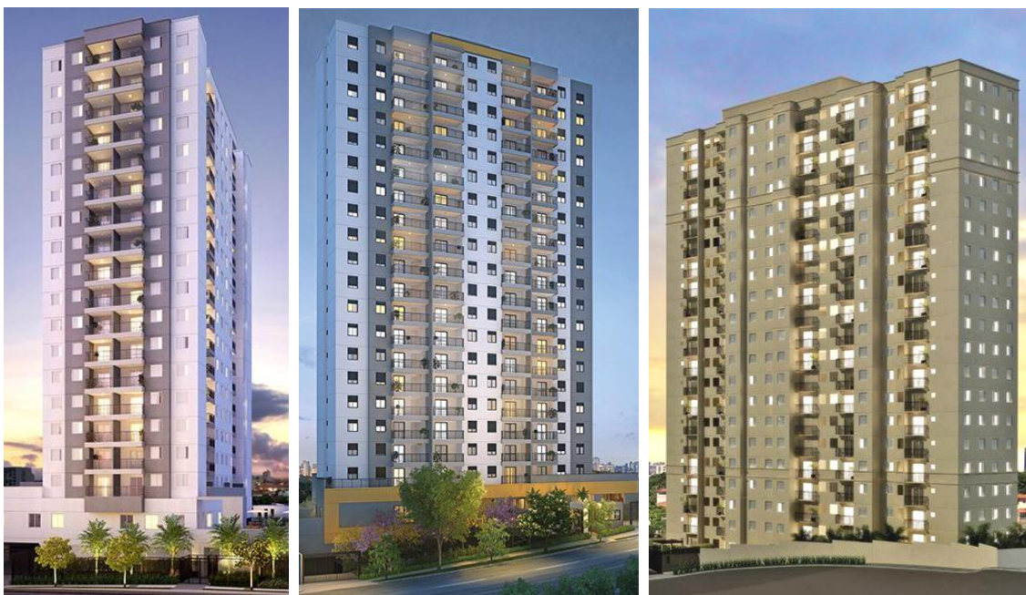
Figura 21 – Exemplos de alguns edifícios em execução da empresa construtora (Fonte: Documentos internos Tibério Construções e Incorporações S.A., 2018)
