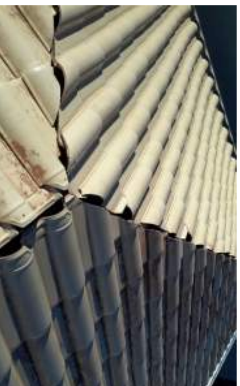
Detalhe do recorte das telhas
