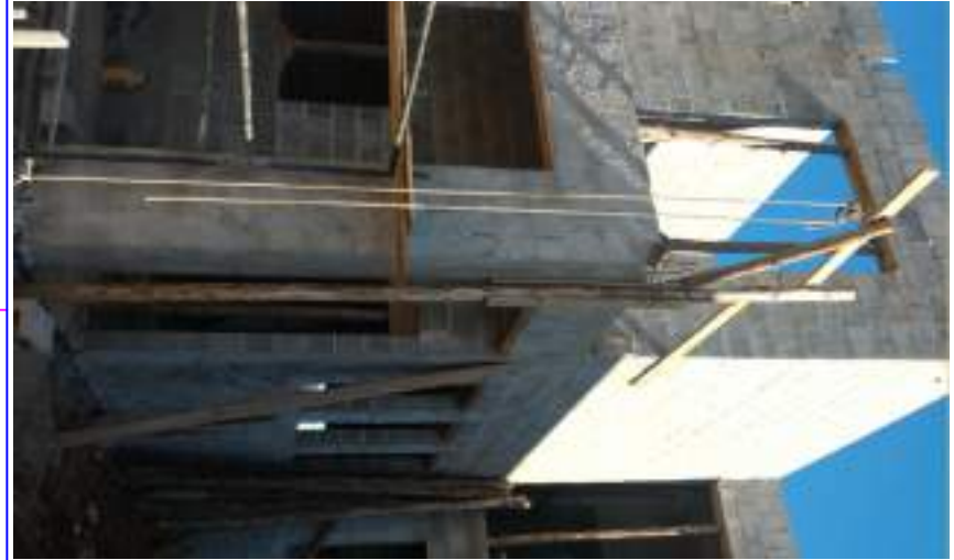
Detalhe da Polia para subida de blocos fixada junto a da Parede P08
