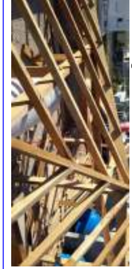
Montagem dos cabros do telhado
