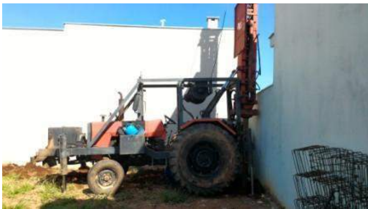
Figura 33 – Execução de estacas escavadas – 20/02/2017
