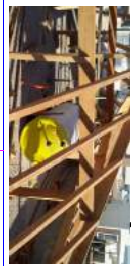
Subir o Boiler antes da montagem
