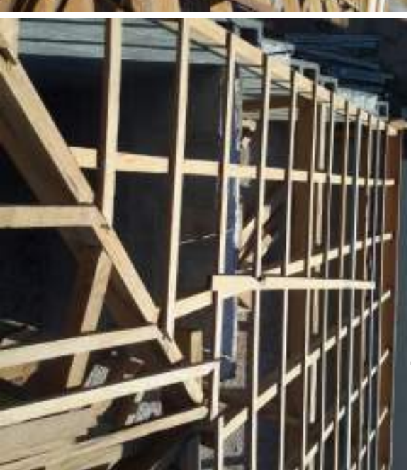
Estrutura do telhado sobre as paredes
