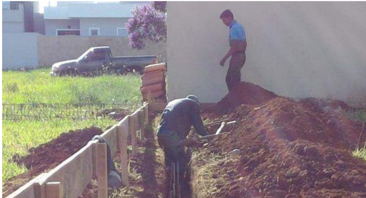
Figura 37 – Escavação das vigas baldrames – 23/02/2017
