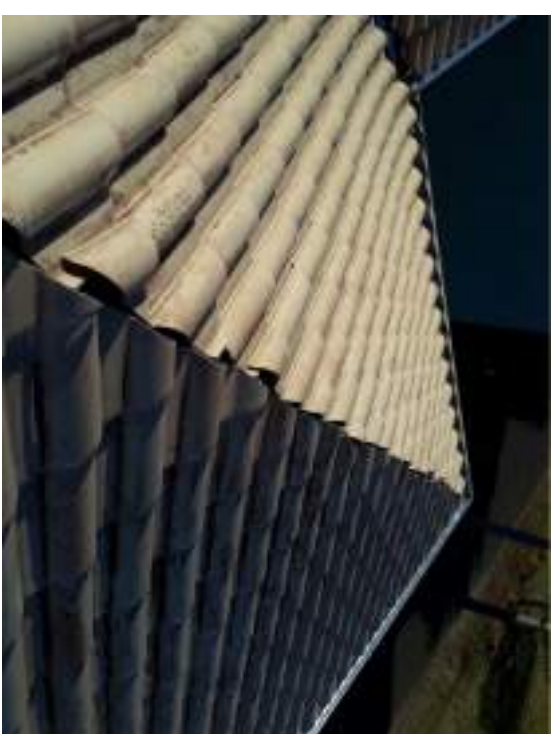
Detalhe da Cumeeira da Leste
