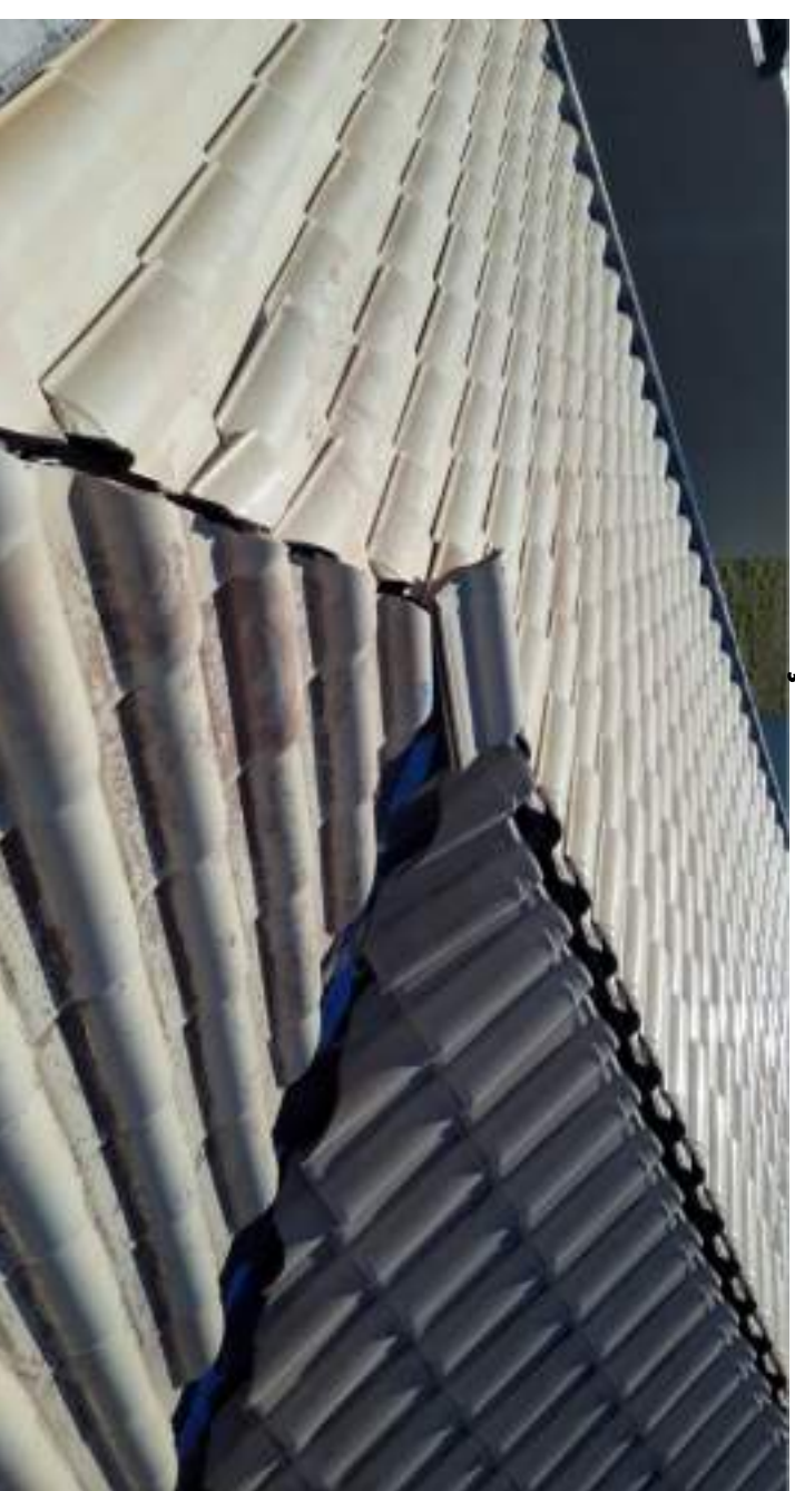
Detalhe do lançamento das telhas cerâmicas
