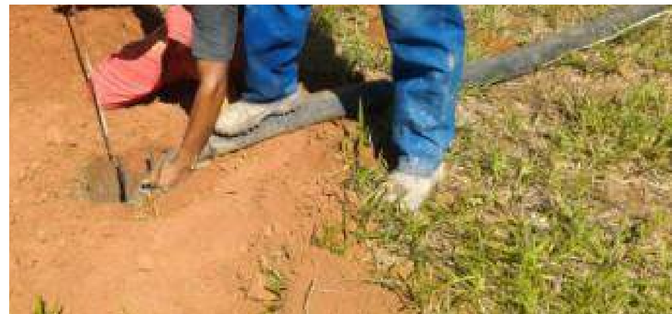
Figura 36 – Concretagem das estacas – 21/02/2017
