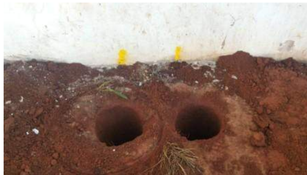
Figura 34 – Estacas escavadas do muro de divisa (junta de dilatação) – 20/02/2017
