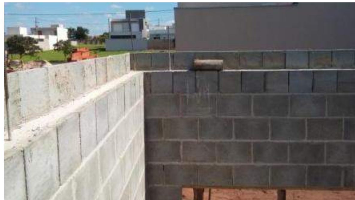
Figura 40 – Canaleta “J” grauteada – 30/04/2017
