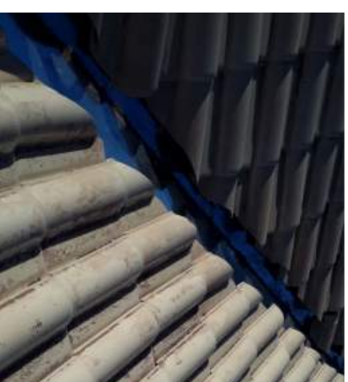
Detalhe do lançamento das telhas cerâmicas
