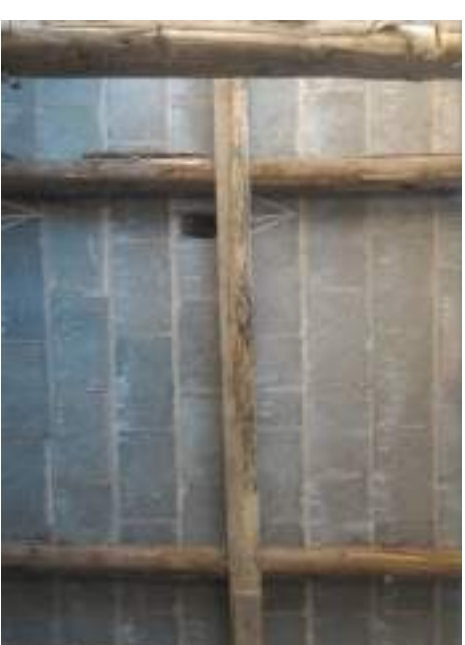
Detalhe da guia de travamento das escoras
