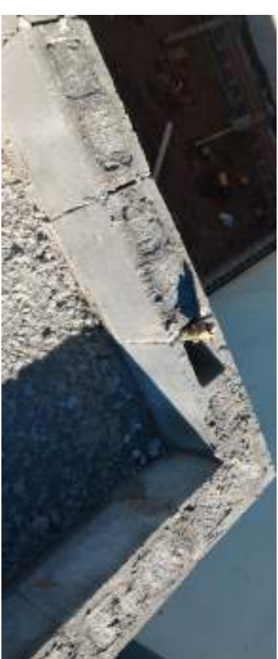
Encontro das Paredes P32 e P35: Prumada hidráulica do banheiro e lavanderia
