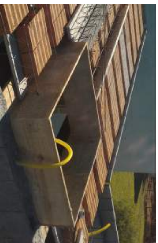
Detalhe da montagem da laje junto ao Alçapão
