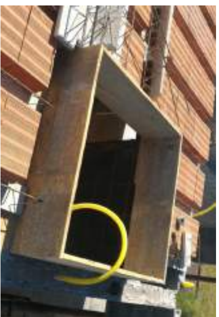
Detalhe da montagem do Alcapão
