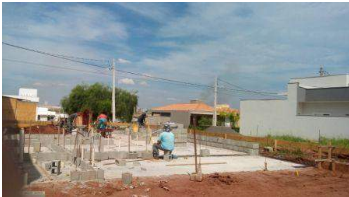
Figura 39 – Execução da primeira fiada – 05/04/2017
