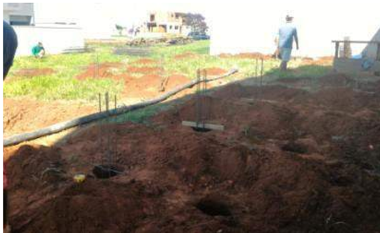
Figura 35 – Estacas preparadas para concretagem – 21/02/2017
