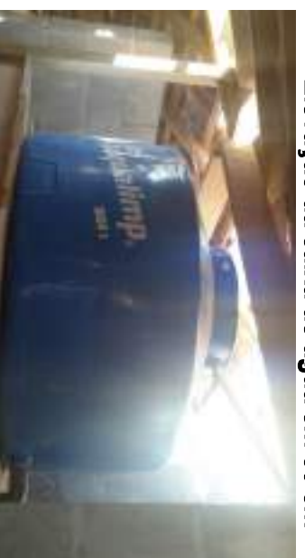
Elevação da caixa de água em 80 cm
