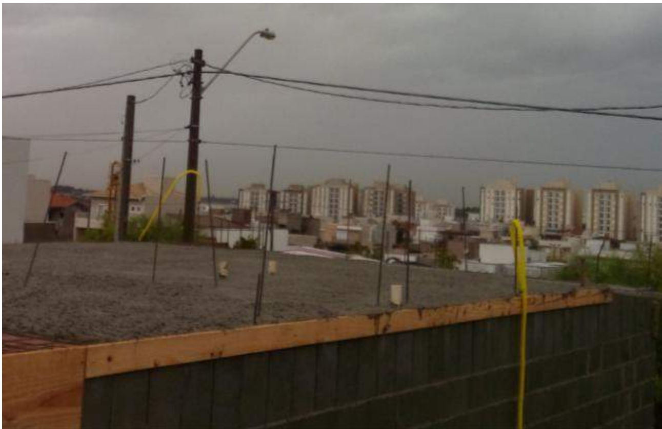
Figura 42 – Concretagem da laje – 05/05/2017
