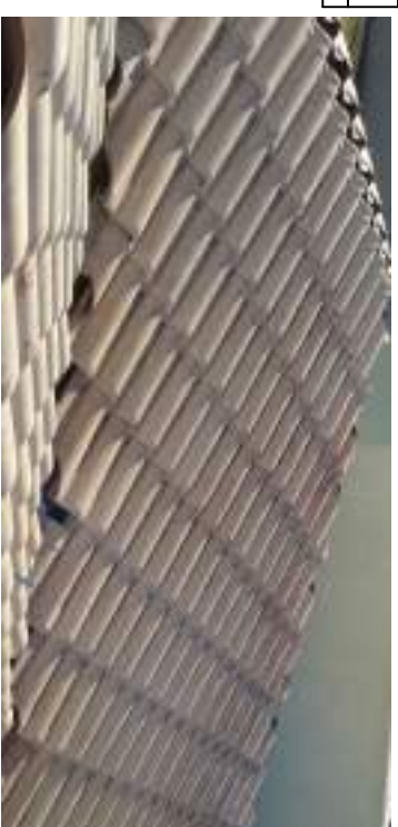
Detalhe das telhas cerâmicas
