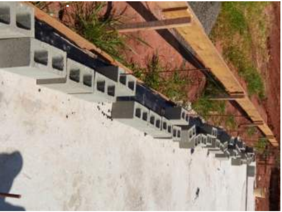
Modulação da primeira fiada da Parede P07
