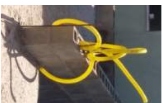
Detalhe da subida dos Eletrodutos da Parede P16
