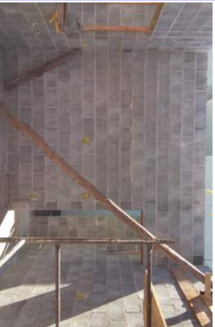
Parede P09 vista pelo lado da cozinha
