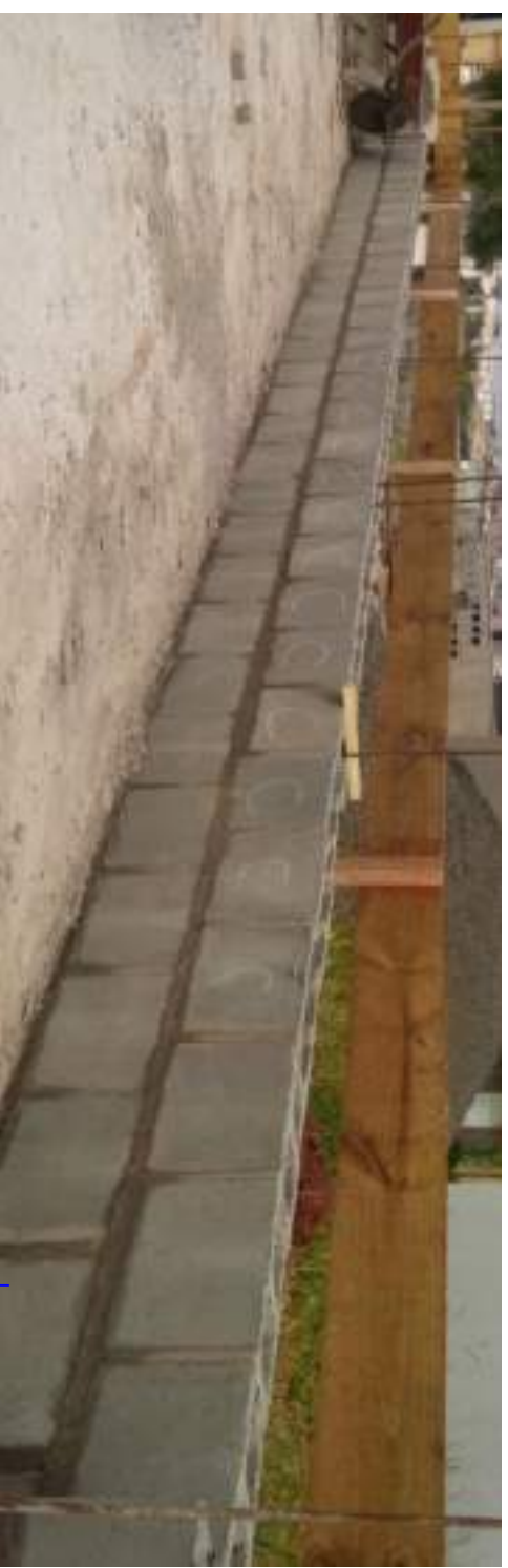
Elevação da segunda fiada da Parede P07: Aentar para os blocos canaletas e pontos de graute
