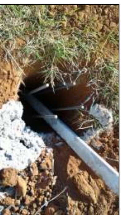
Exemplo de cota de arrasamento
