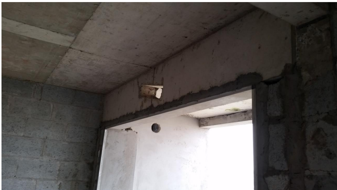
Foto 06 - Abertura em viga da varanda
