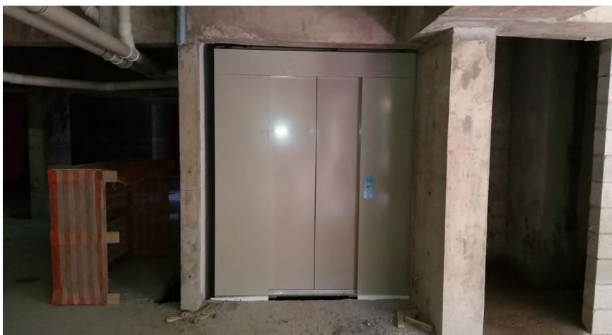
Foto 24 – Detalhe dos vãos dos elevadores
