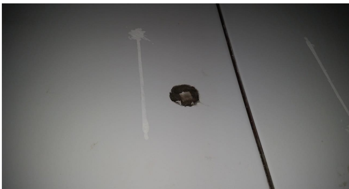
Foto 10 - Kit hidráulico da parede hidráulica do box
