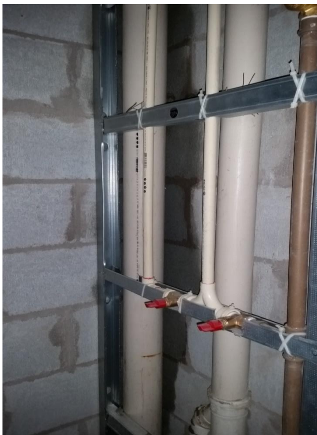
Foto 08 - Kit hidráulico da parede hidráulica do box
