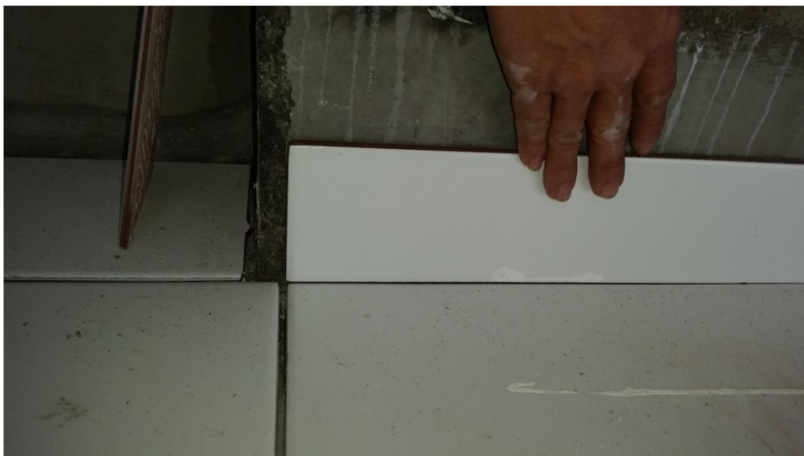
Foto 13 - Shaft Hidráulico – Diferença para acabamento
