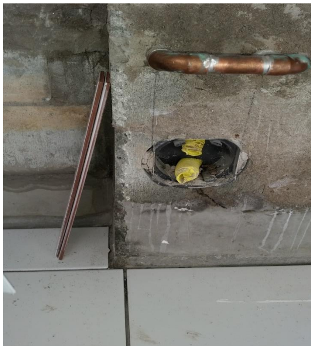
Foto 12 - Shaft Hidráulico – Diferença para acabamento
