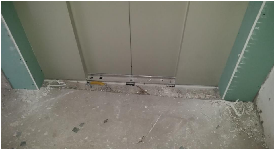
Foto 26 – Detalhe vãos elevadores
