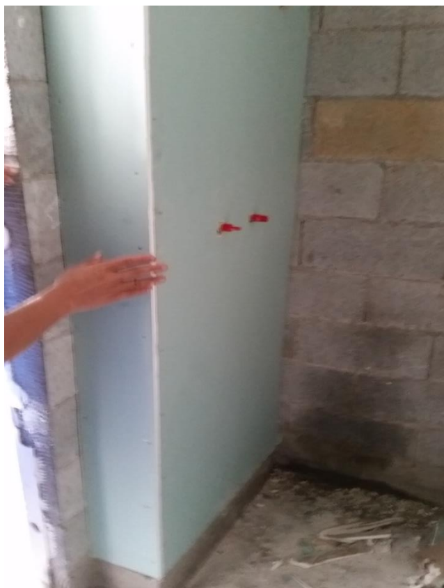
Foto 09 - Kit hidráulico da parede hidráulica do box
