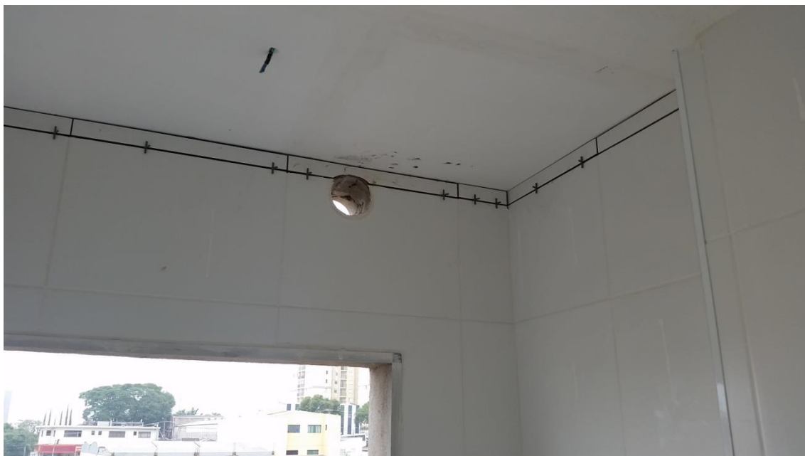
Foto 22 – Detalhe da saída do duto aquecedor a gás - execução
