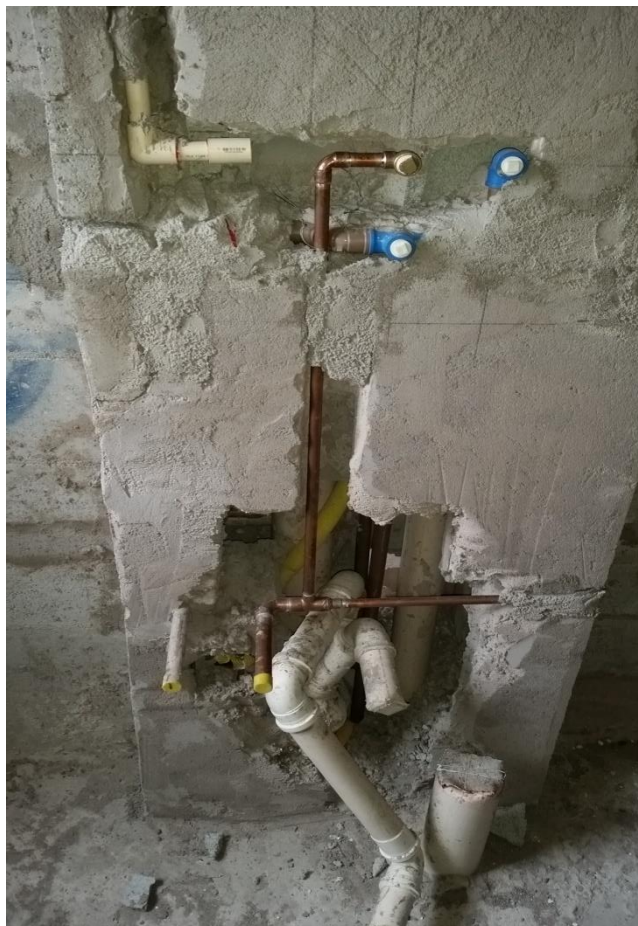
Foto 14 - Shaft hidráulico
