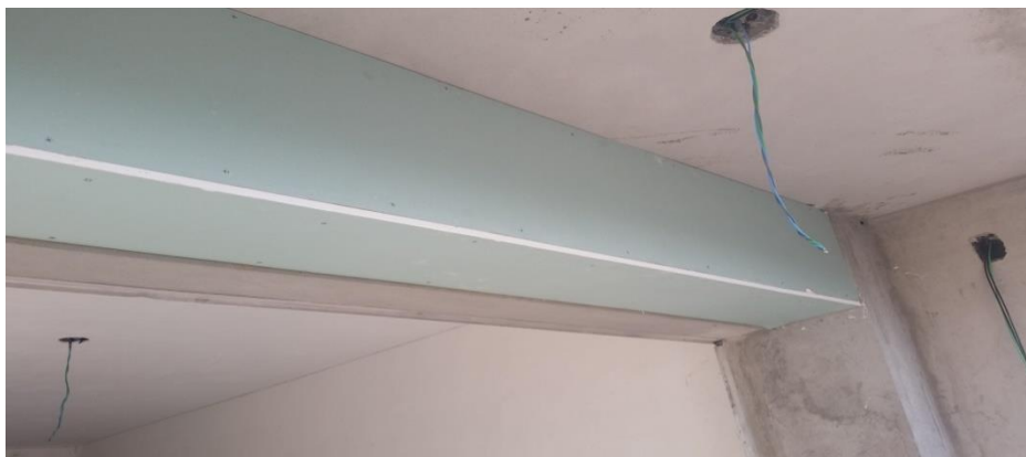
Foto 07 - Fechamento do abrigo das instalações do ar condicionado
