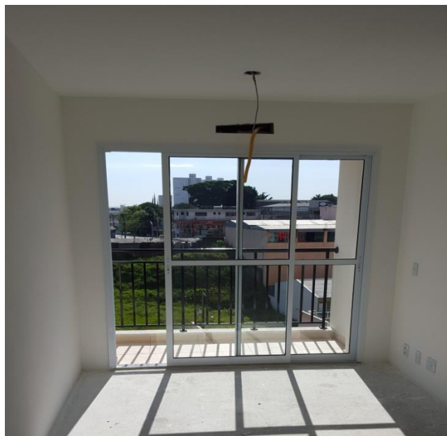
Foto 04 - Abertura em viga da varanda
