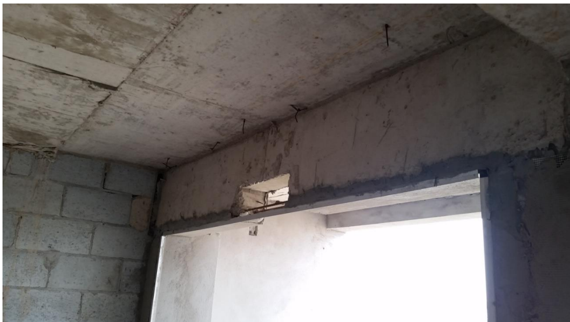
Foto 05 - Abertura em viga da varanda
