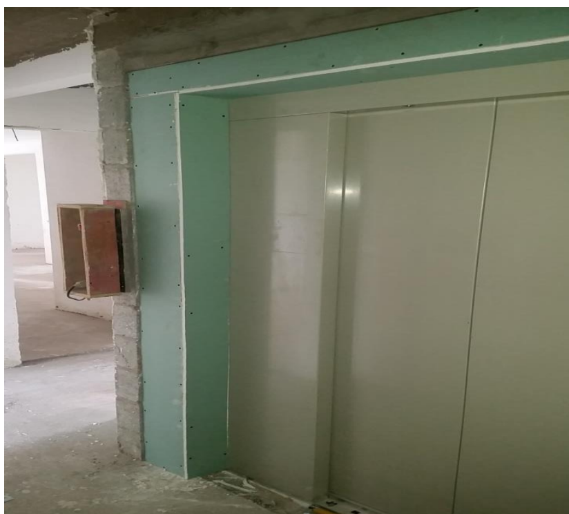
Foto 25 – Detalhe vãos elevadores
