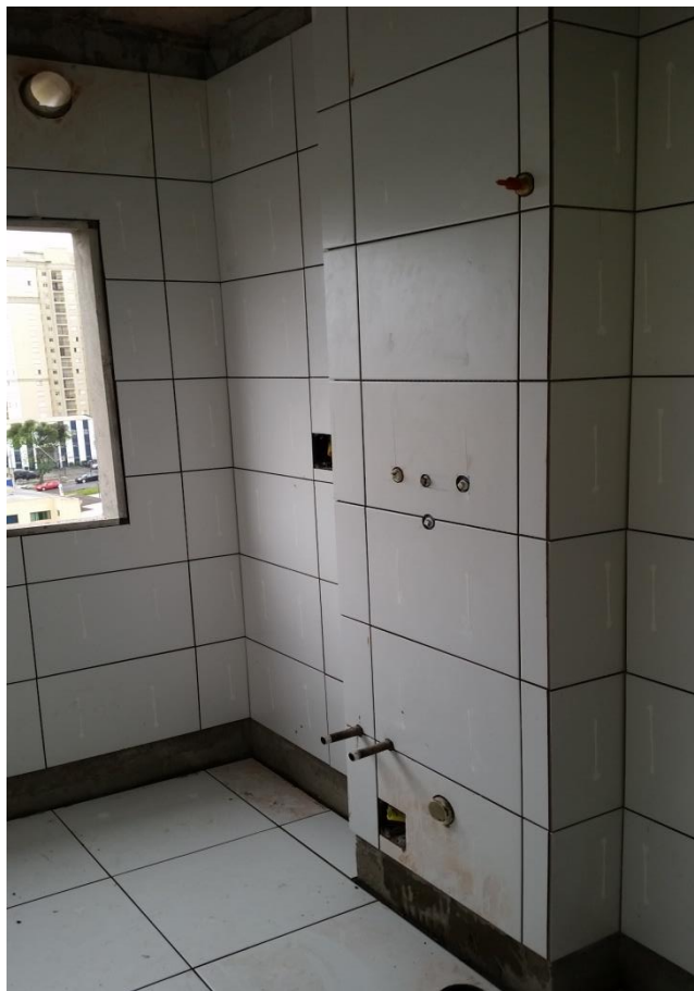
Foto 17 - Shaft hidráulico
