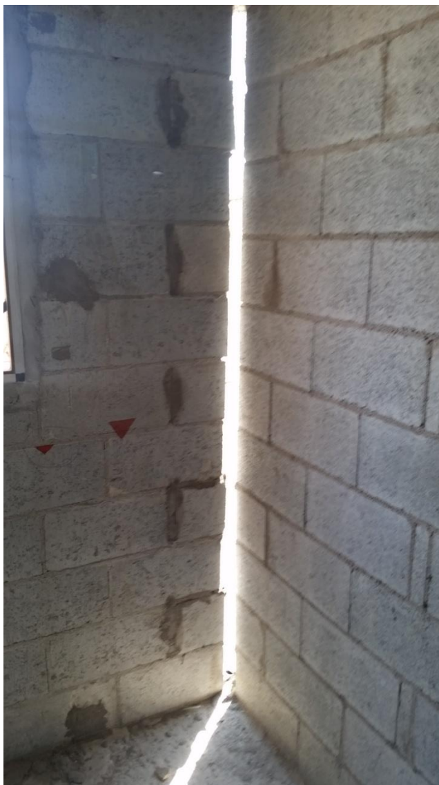
Foto 31 - Interferência causada pelo vão da cremalheira
