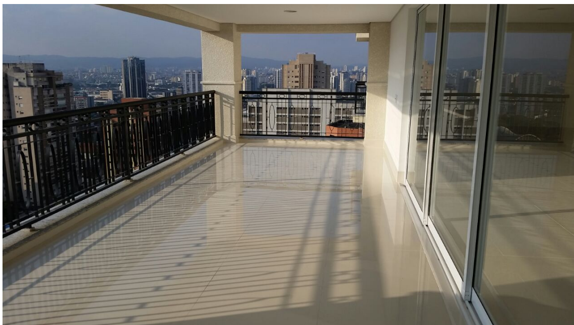
Figura 25–Terraço – Material Prime – Empreendimento Padrão A
