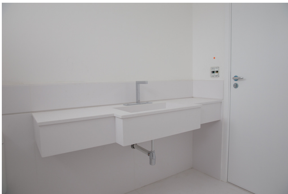
Figura 23–Foto do Banho – Material Prime – Empreendimento Padrão A
