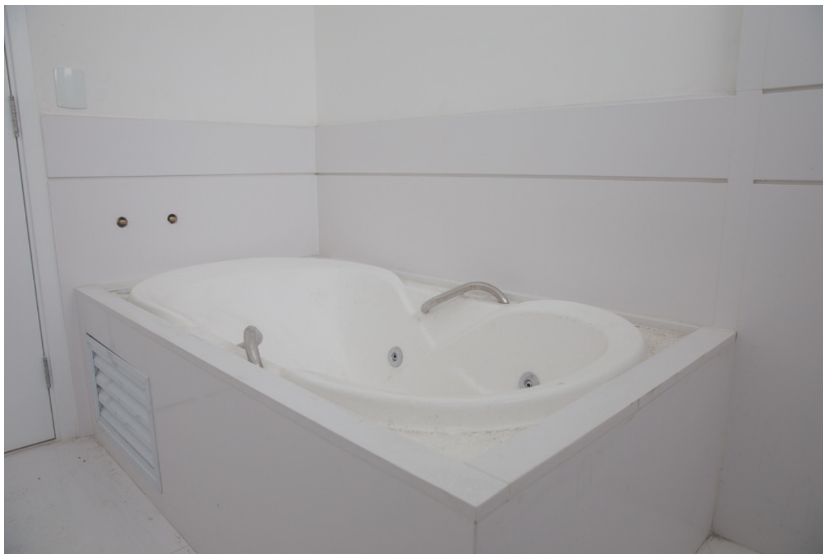
Figura 24–Foto do Banho – Material Prime – Empreendimento Padrão A
