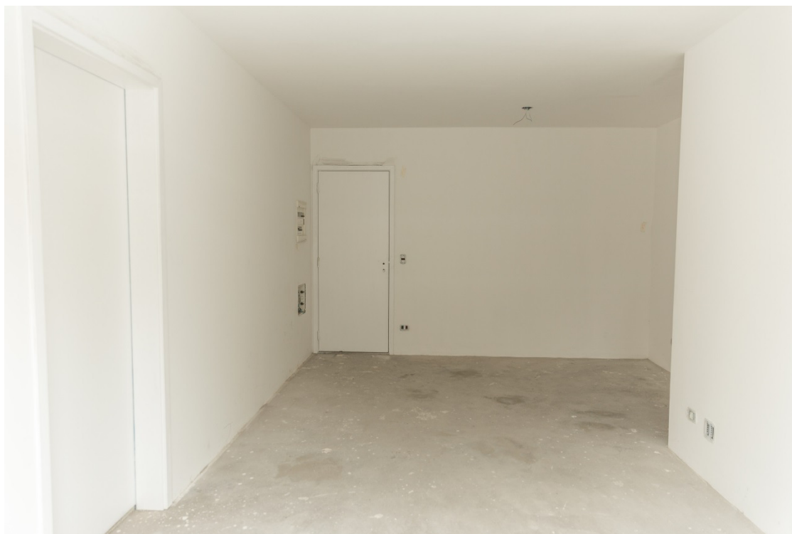
Figura 57–Sala – Material Padrão – Empreendimento Padrão C
