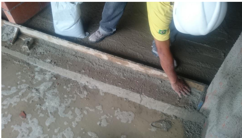
Figura 9 – Preenchimento da fresta entre a contenção e a laje com areia
