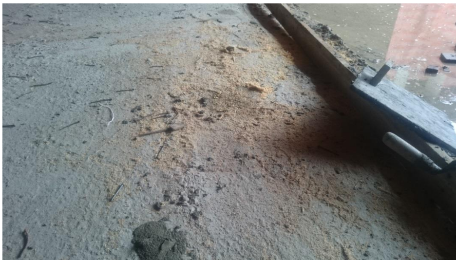
Figura 12 – Resíduos gerados na produção das contenções para o contrapiso
