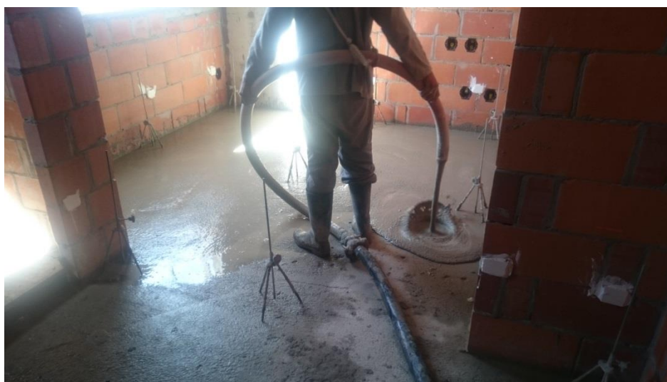
Figura 19 – Bombeamento da argamassa fluida
