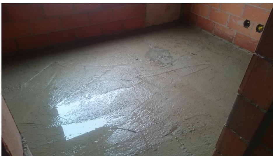
Figura 13 – Laje de concreto limpa e umedecida
