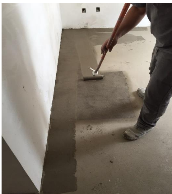
Figura 30 – Tratamento de fissuras superficiais
