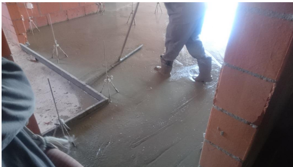
Figura 20 – Adensamento e acabamento do contrapiso
