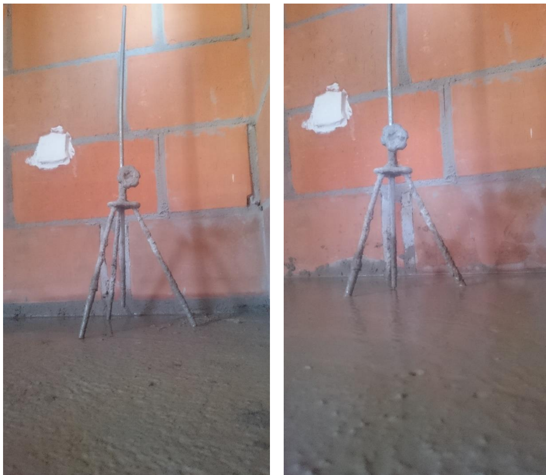
Figura 16 – Niveleta antes e após o lançamento da argamassa
