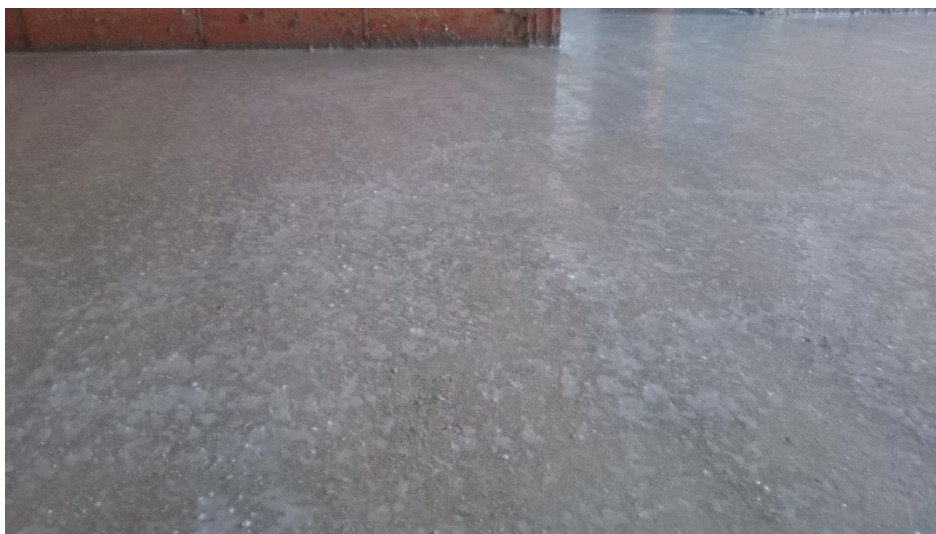
Figura 22 – Aspecto do contrapiso após a cura química
