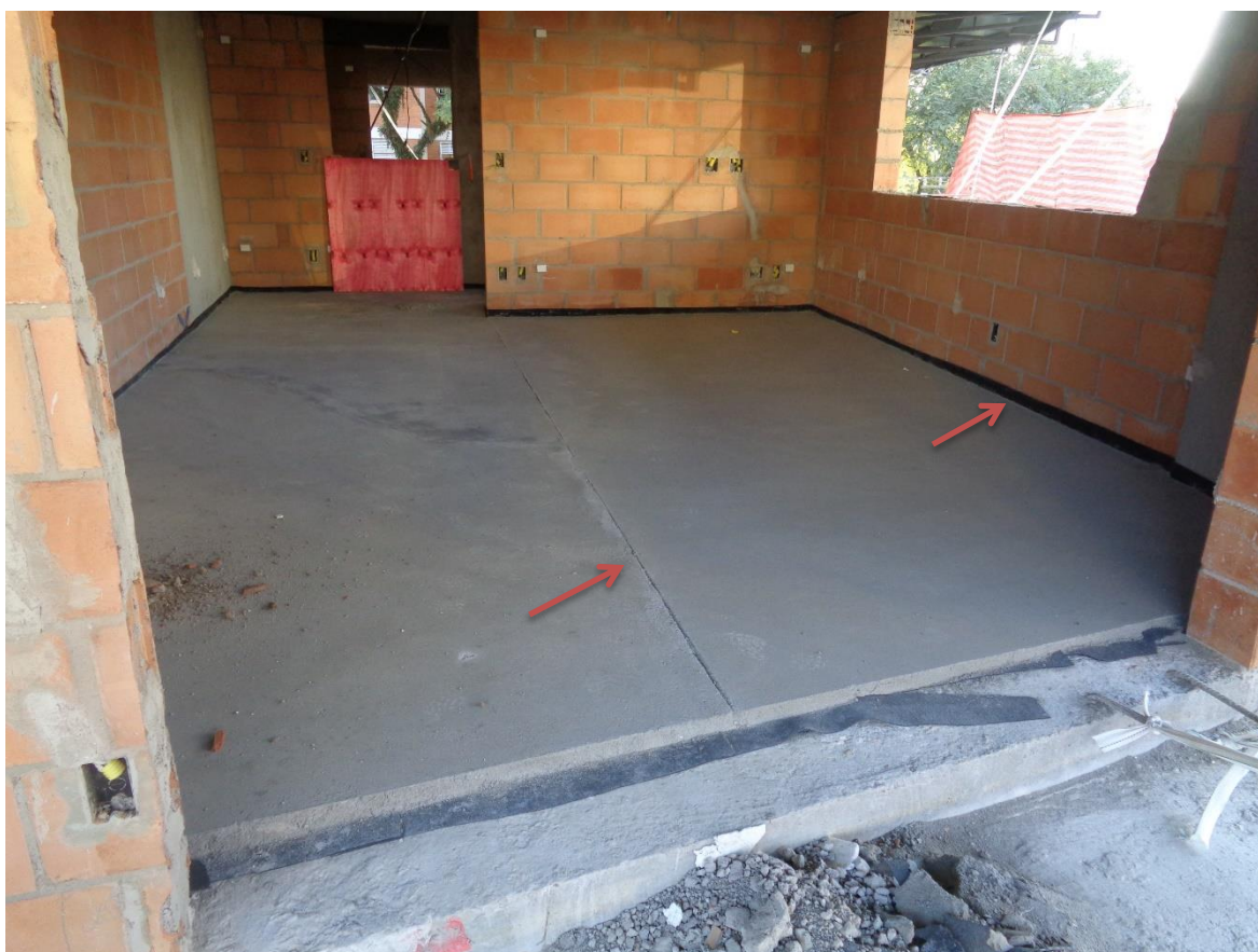
Figura 33 – Juntas de dessolidarização e de movimentação
