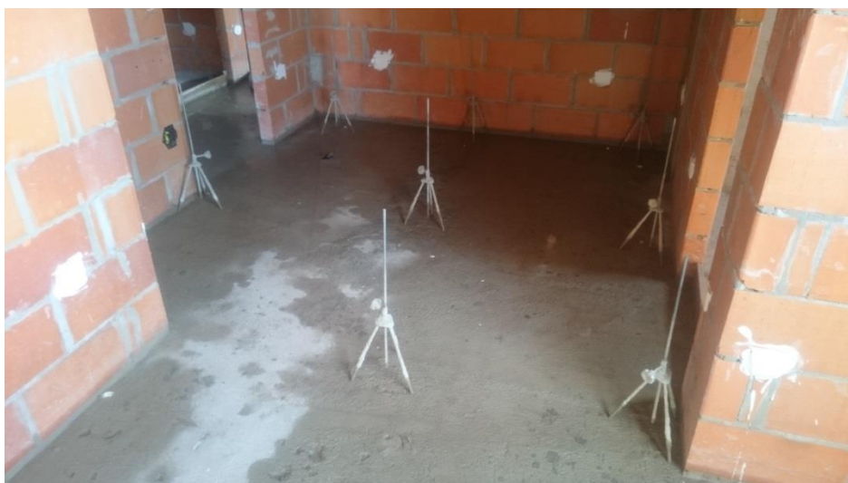
Figura 15 – Distribuição das niveletas
