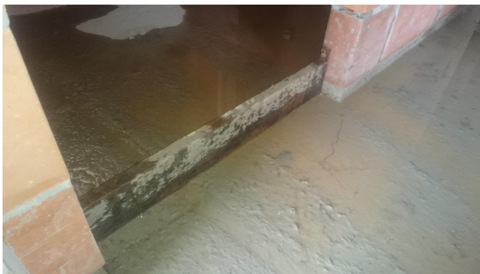
Figura 11 – Contenção da área do quarto com o banheiro (área seca / área molhável)
