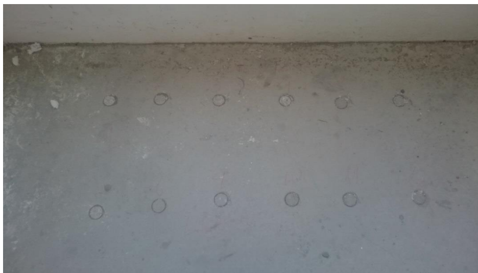
Figura 23 – Ensaio de resistência de aderência à tração no contrapiso
