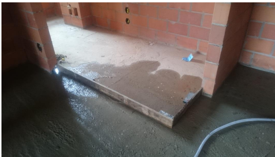
Figura 10 – Contenção da área da sala com a cozinha (área seca / área molhável)
