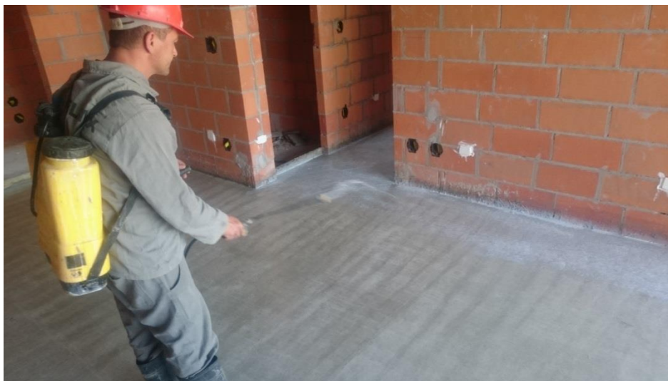
Figura 21 – Cura química da argamassa de contrapiso
