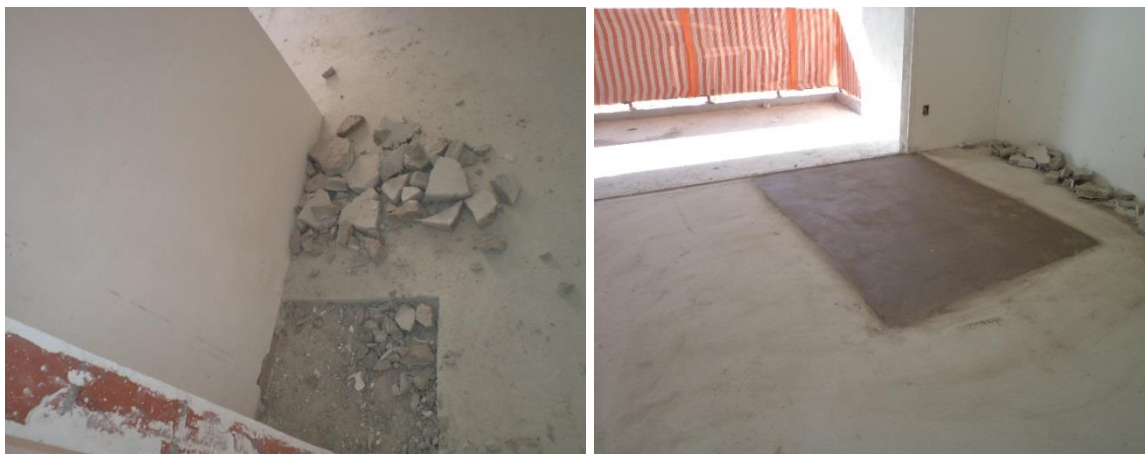
Figura 31 – Tratamento de som cavo em contrapiso
