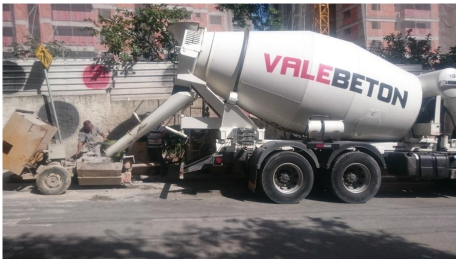
Figura 17 – Preparação da bomba e da argamassa
