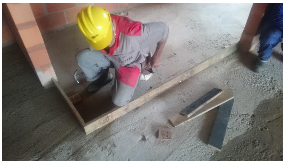
Figura 8 – Contenção da área da sala com a cozinha sendo executada
