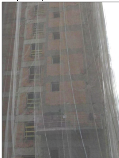
Foto 3 – Chapisco aplicado na subida do balancim.
