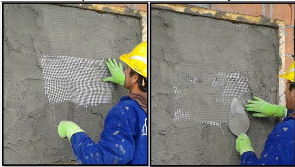
Foto 8 - Reforço com tela de fibra de vidro álcali-resistente na argamassa.
