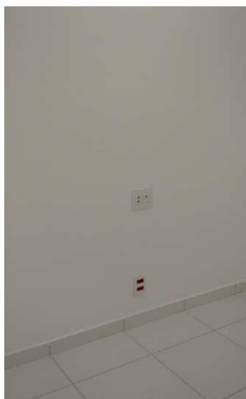
Figura 46: Pontos executados no apoio (HSE) Fonte: Acervo da empresa (2016)
