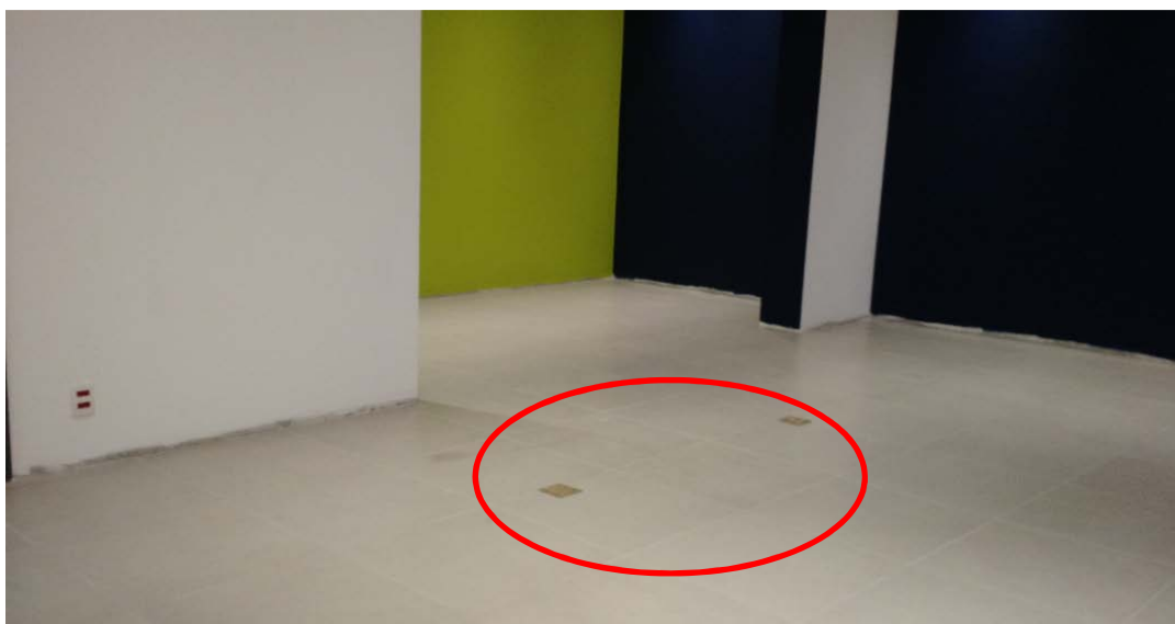
Figura 53: Piso do restaurante Fonte: Acervo da empresa (2016)
