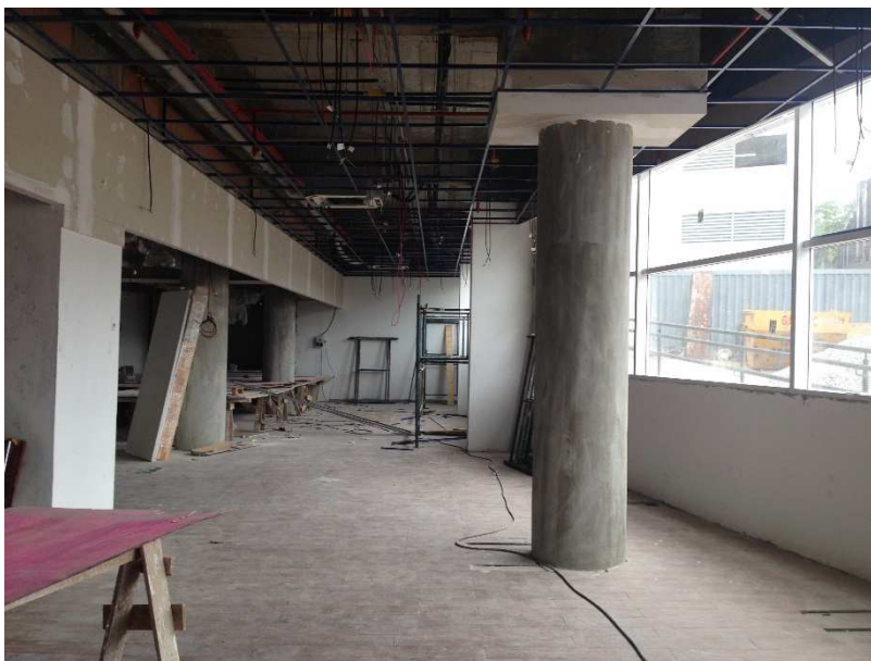
Figura 26: Capitel sobre pilar no restaurante Fonte: Acervo da empresa (2016)
