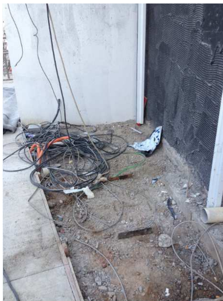
Figura 35: Canteiro para instalação do totem Fonte: Acervo da empresa (2015)
