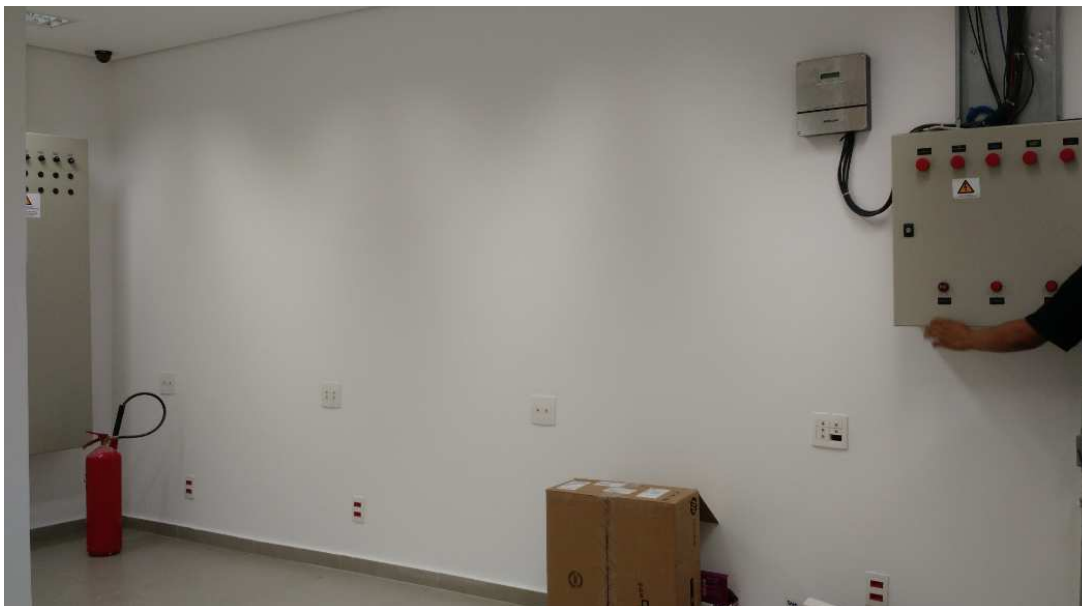
Figura 45: Pontos executados no apoio (HE) Fonte: Acervo da empresa (2016)
