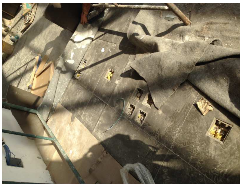
Figura 16: Pontos executados para balcão da recepção Fonte: Acervo da empresa (2016)
