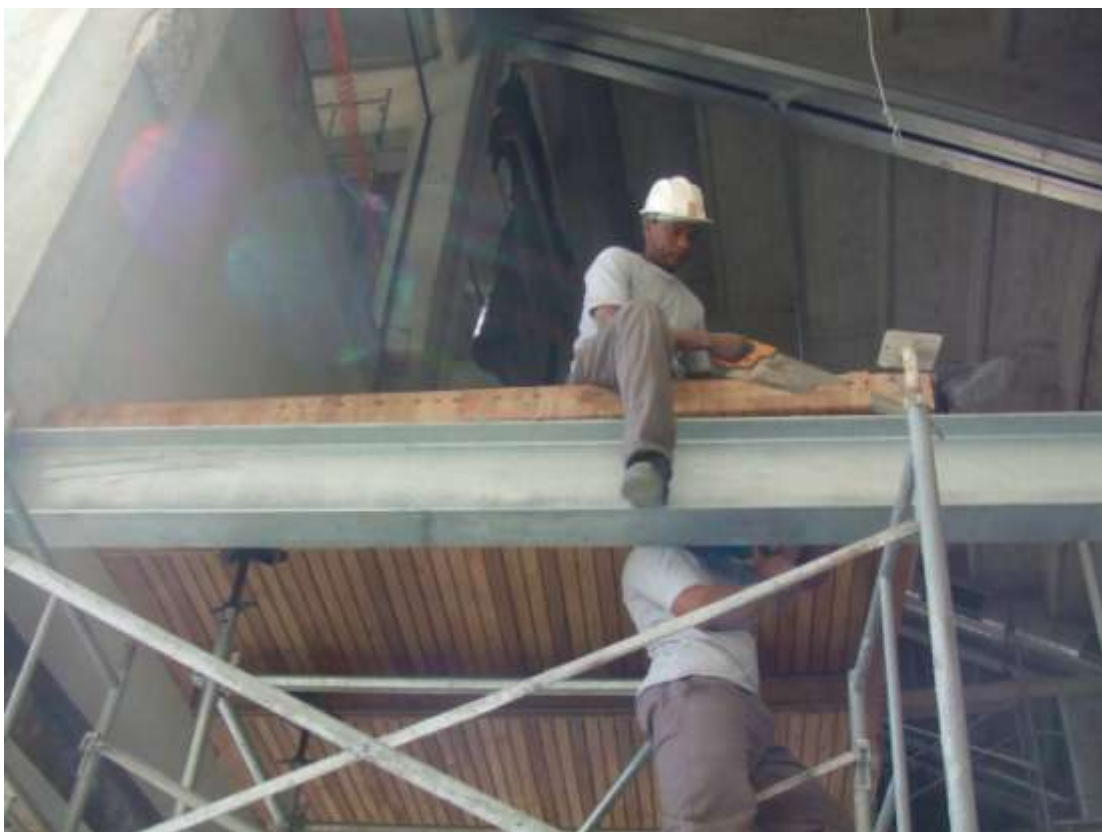
Figura 24 – MF: Imagens da 2ª Fase de Obras – Ajuste da Passarela
