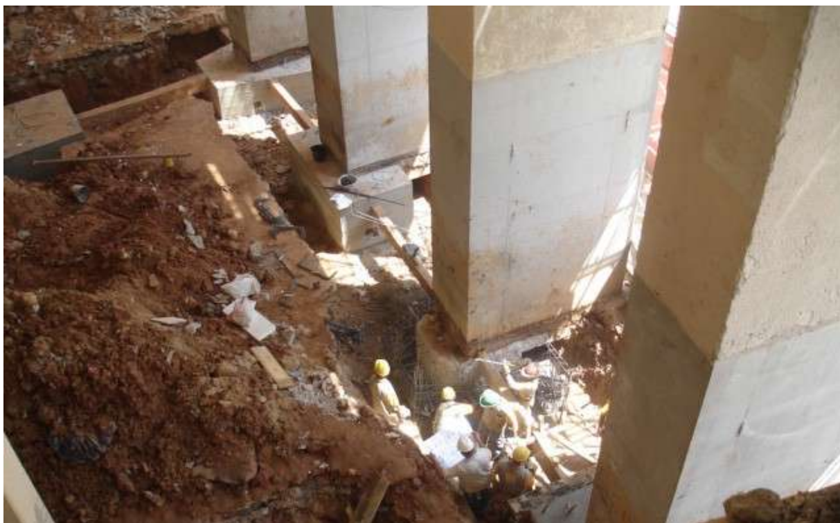
Figuras 57 e 58 – Imagens da 1ª Fase de Obras – Reforços Estruturais
