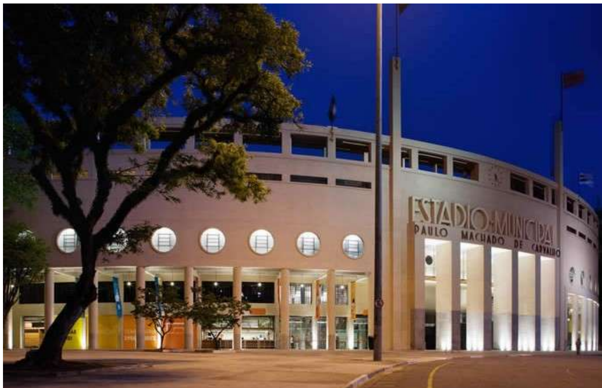
Figuras 11 e 12 – Imagens da Fachada e Galeria do Museu do Futebol no Estádio do Pacaembu e Praça Charles Miller
