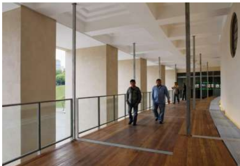
Figuras 13 e 14 – Imagens da Passarela de madeira suspensa atirantada
