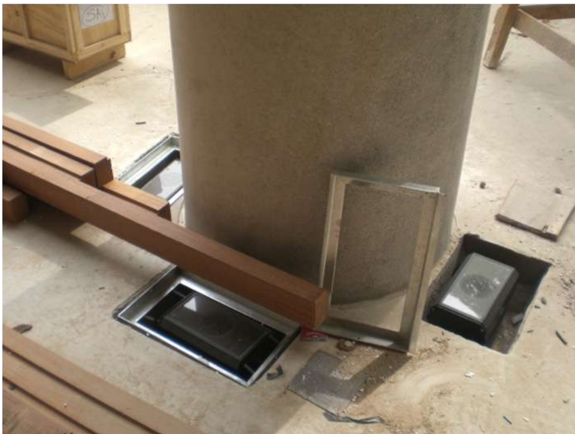
Figuras 68 e 69 – MF: Imagens da 2ª Fase de Obras – Instalação do Sistema de Iluminação
