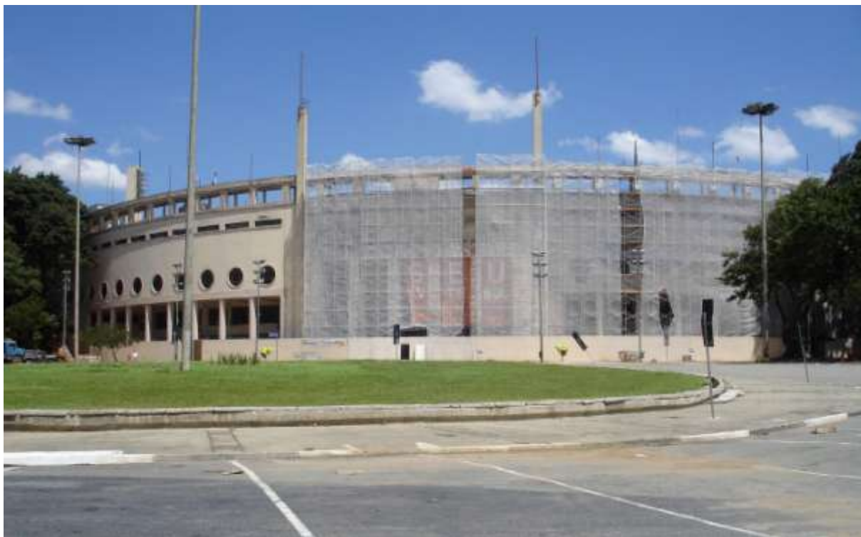
Figuras 59 e 60 – MF: Imagens da 1ª Fase de Obras – Demolições
