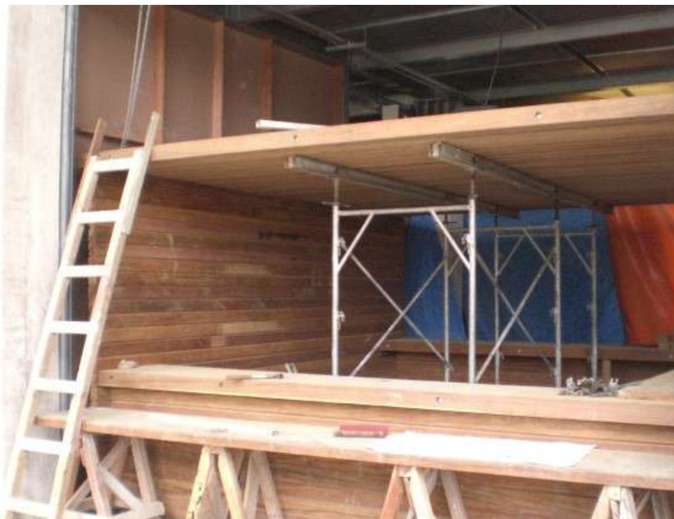
Figuras 62 e 63 – MF: Imagens da 2ª Fase de Obras – Estruturas de Madeira
