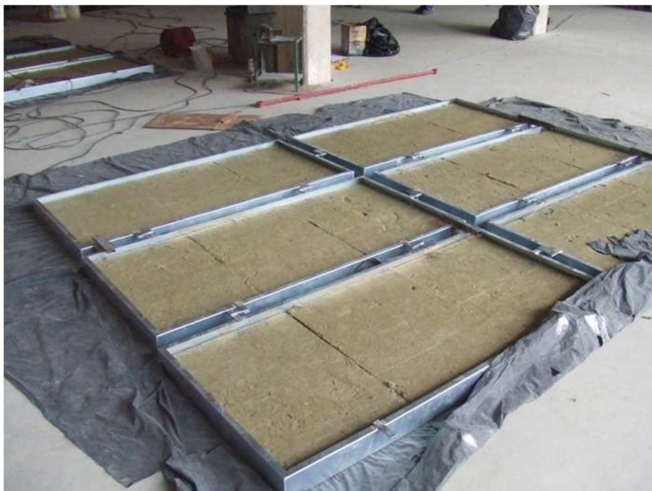
Figuras 54 e 55 – MF: Imagens da 2ª Fase de Obras – Instalação dos Painéis Acústicos
