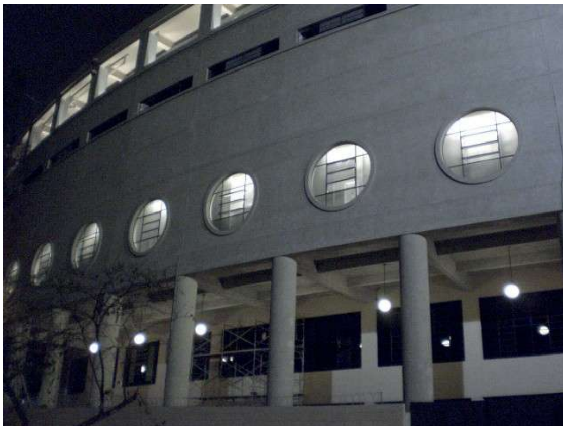
Figuras 70 e 71 – MF: Imagens da 2ª Fase de Obras – Instalação do Sistema de Iluminação
