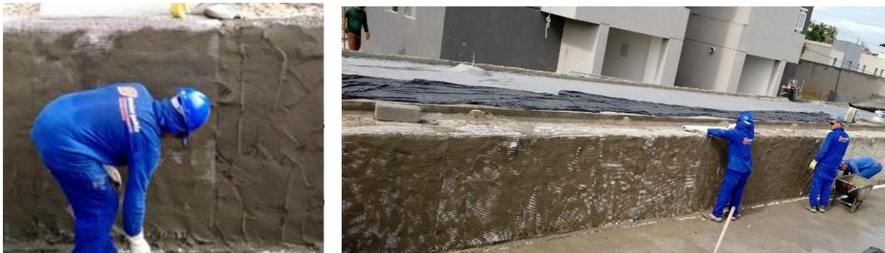
Fotografia 11: Acabamentos do revestimento argamassado em dispositivos e juntas
